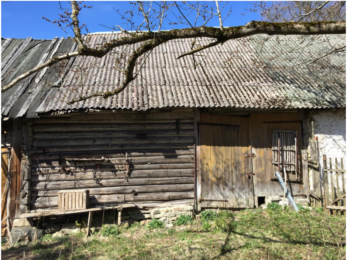
28. Väikese rehealuse fassaad
