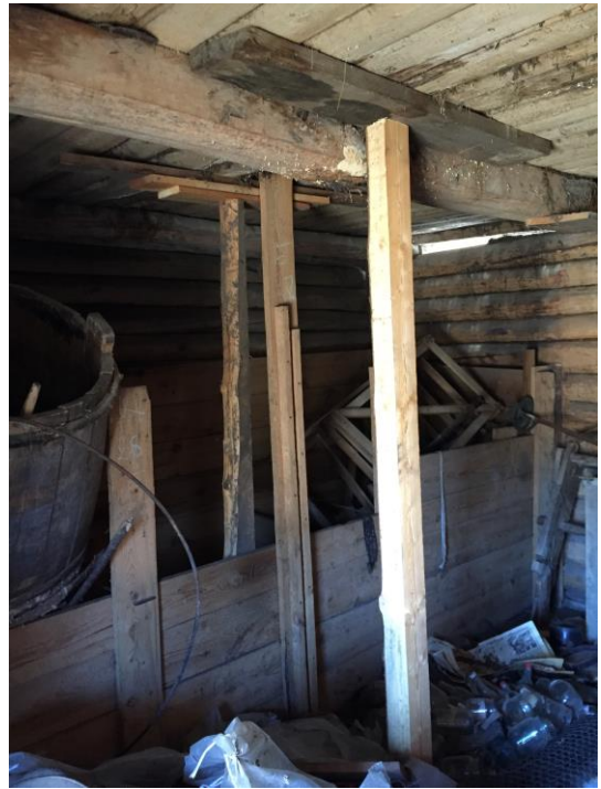
95.Katuse ajutine toestamine aamtala kõrval
