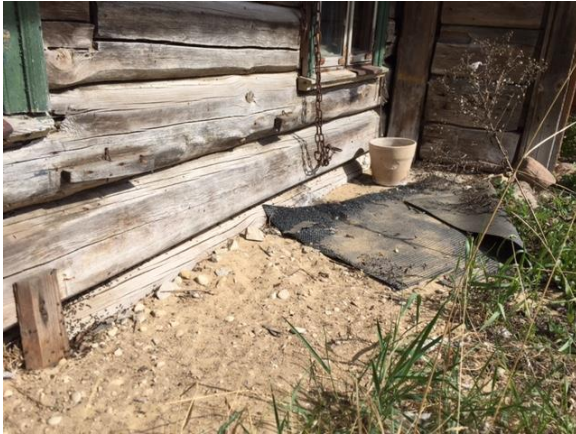
16. Rehetoa vundament asub madalamal kui maapind
