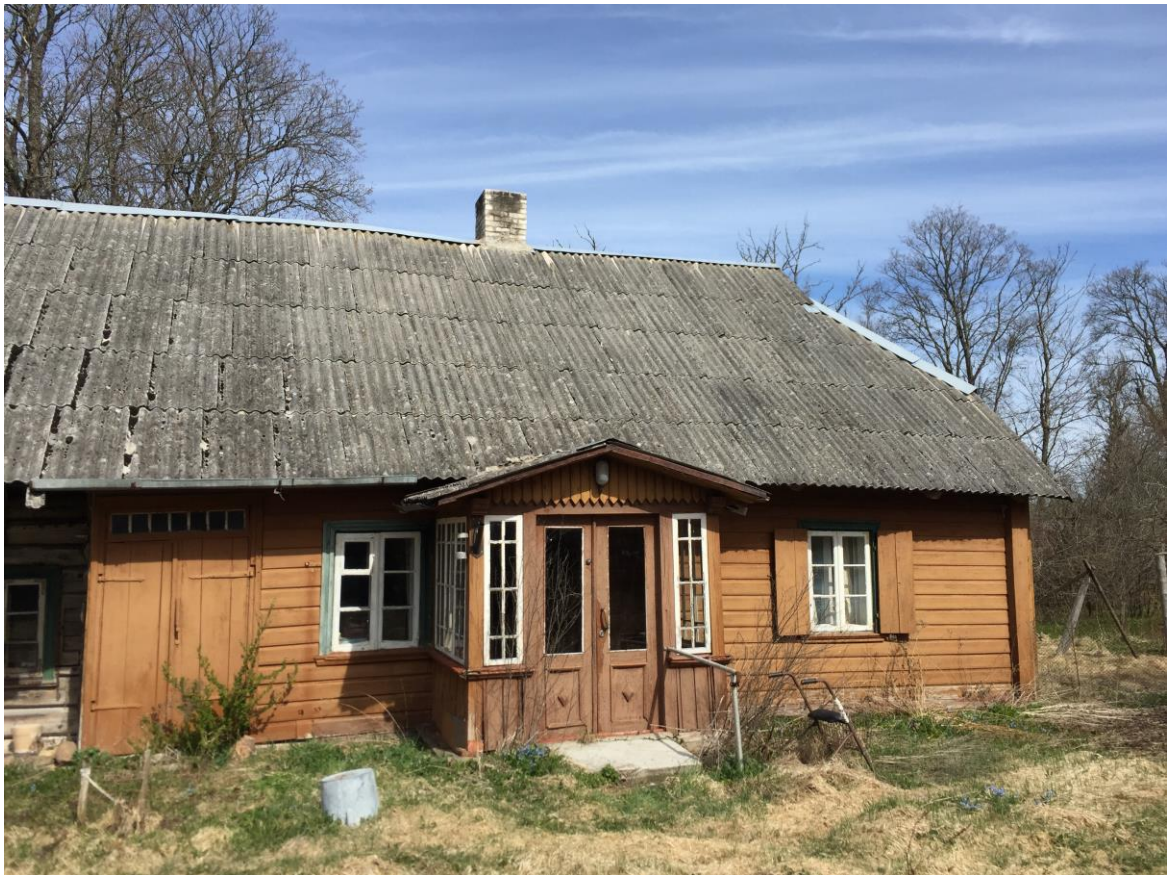
20. Vaade fassaadile lõunast
