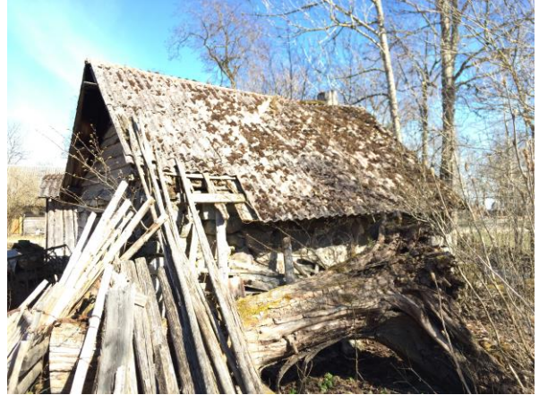
120. Murdunud puu väliköögi kõrval
