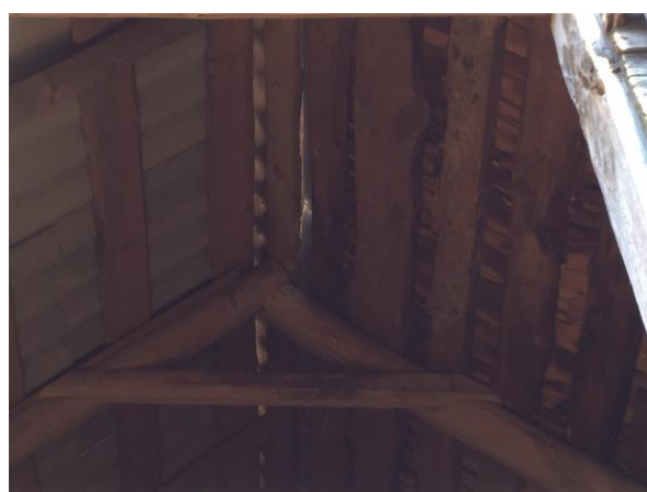
93. Vaade aida katusekonstruktsioonile
