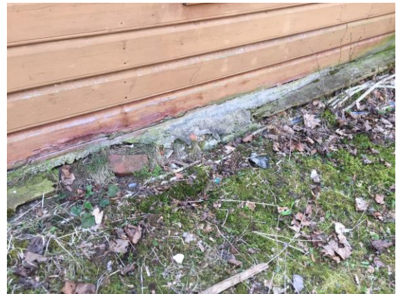
25. Tsementmördiga parandatud veeninalaud põhja küljel
