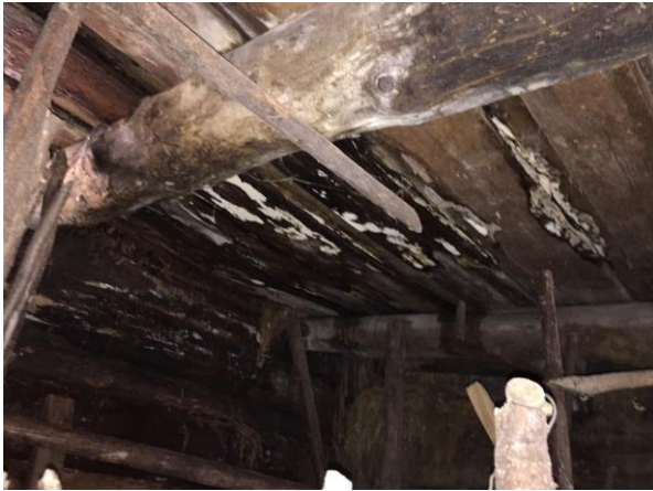
74.Lauda niiskuskahjustustega laekonstruktsioon
