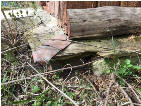
24. Plekiga paigutatud veeninalaud eeskoja fassaadil
