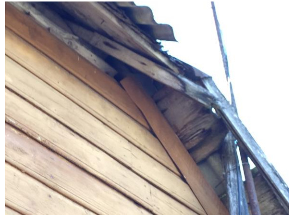
39. Tihendamist vajav antennimasti läbiviik katusest
