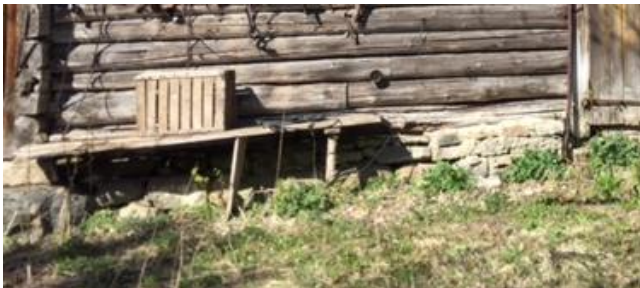
18. Väikese rehealuse vundament
