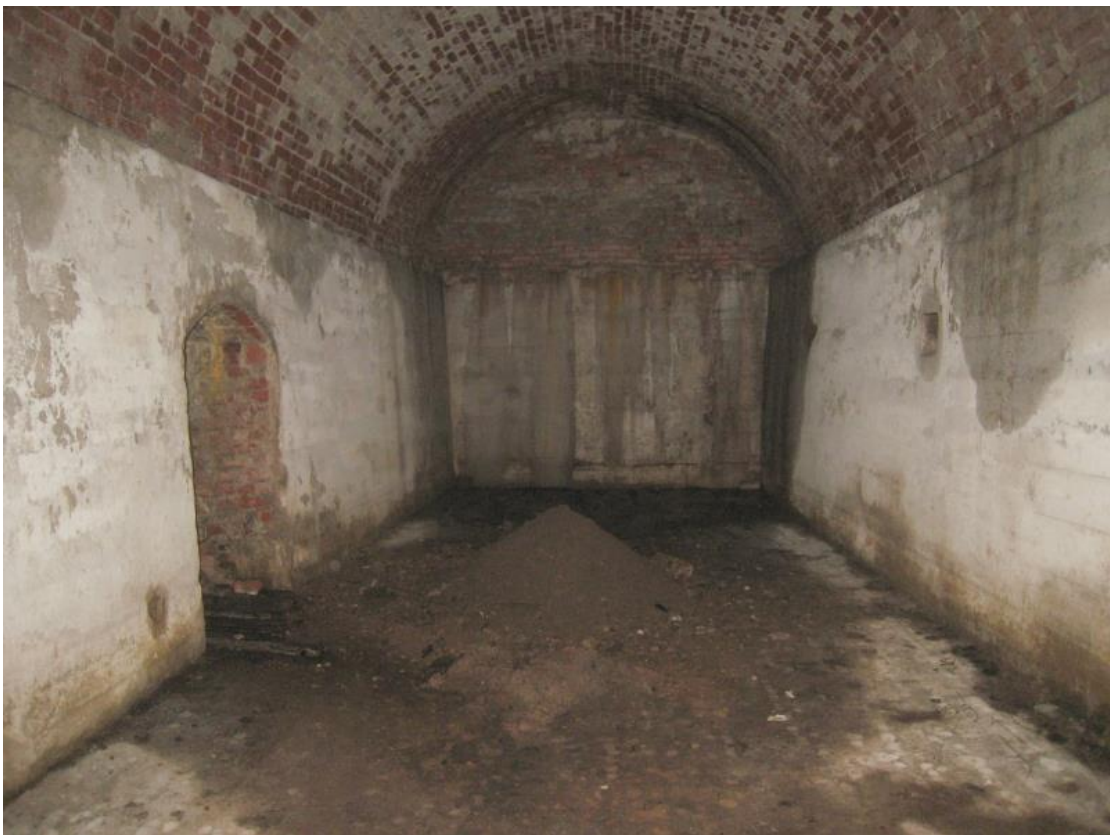
Foto nr. 14 Ruum nr.7, vaade põhja suunas
