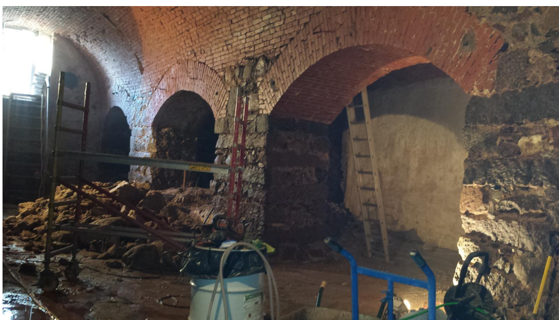
Foto nr. 2 Puhastatud maakividega kinnilaotud ava ruumide nr. 1, 2 ja 3 vahel
