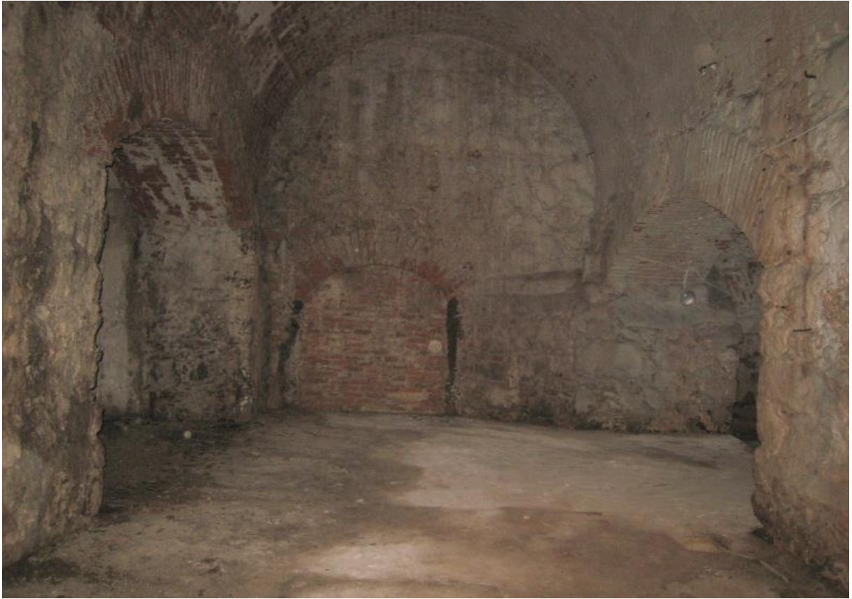
Foto nr.7 Ruum nr.1, tellistega kinni laotud ava kagupoolses otsaseinas.
