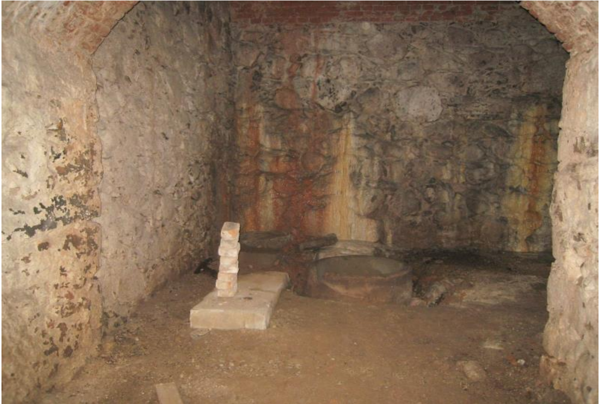
Foto 3. Vaade ruumist 1 ruumi 2. Pildil näha puhta vee kaevurake ja seinas stalaktiidid
