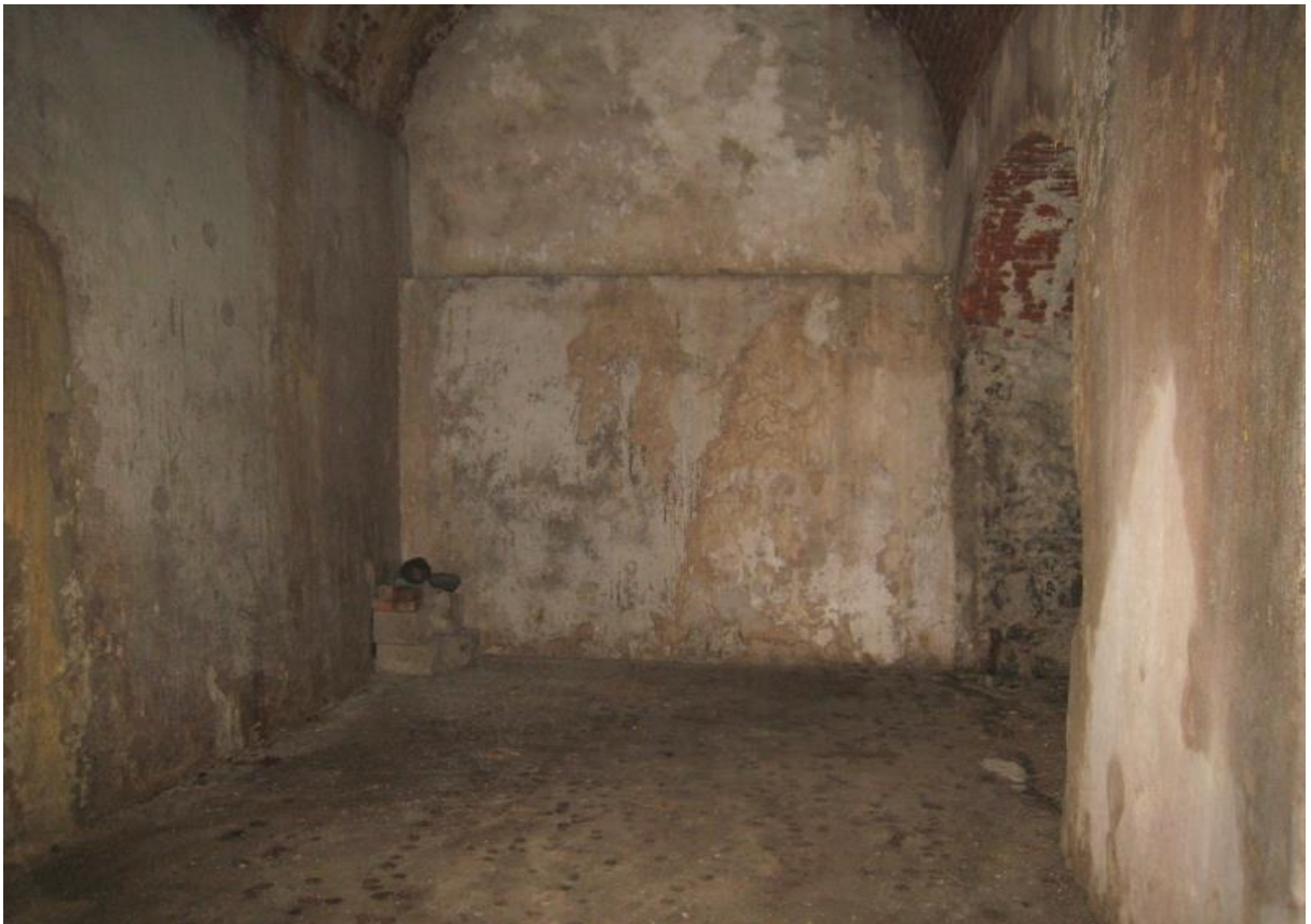
Foto nr. 8 Kagupoolne otsasein ruumis 3
