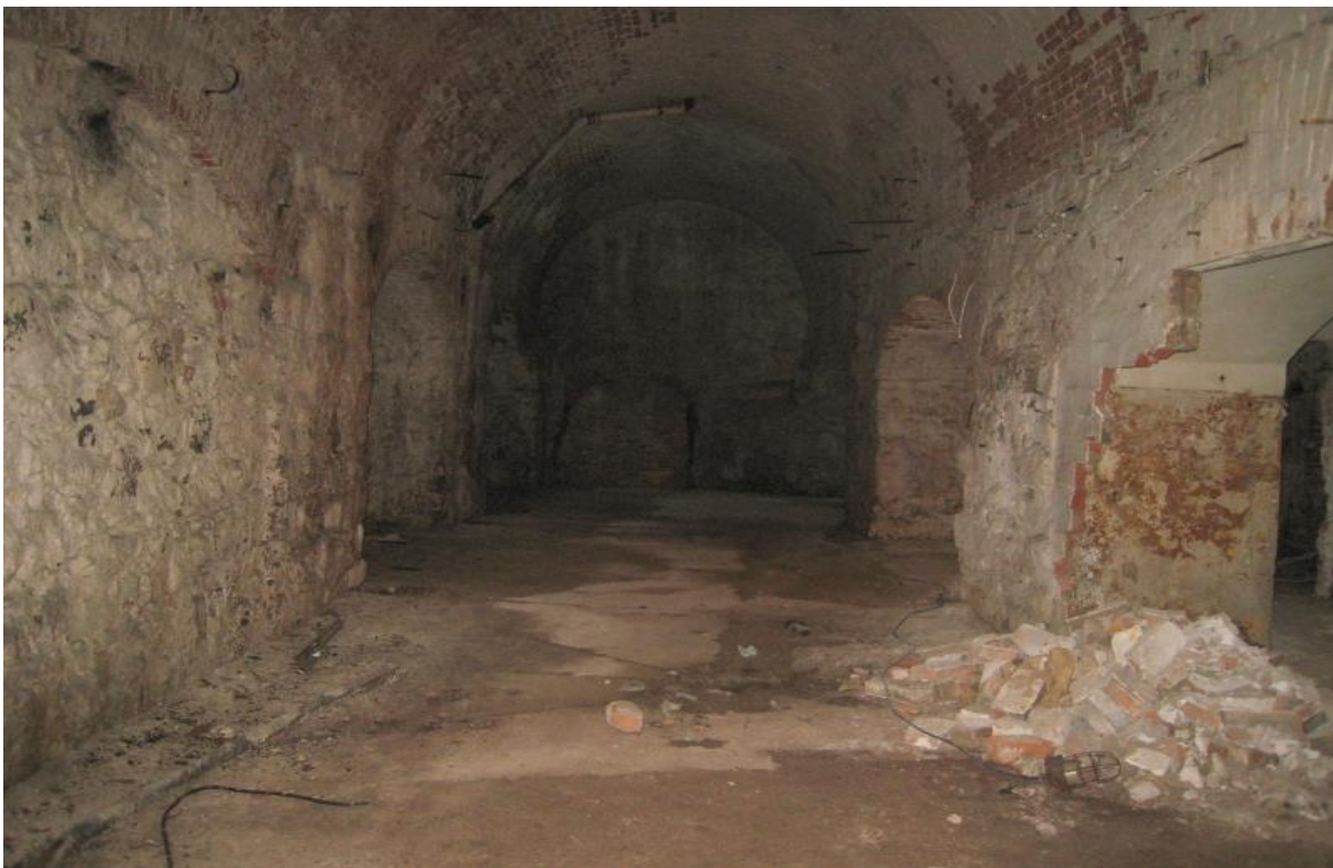
Foto 1 Vaade ruumi nr.1
