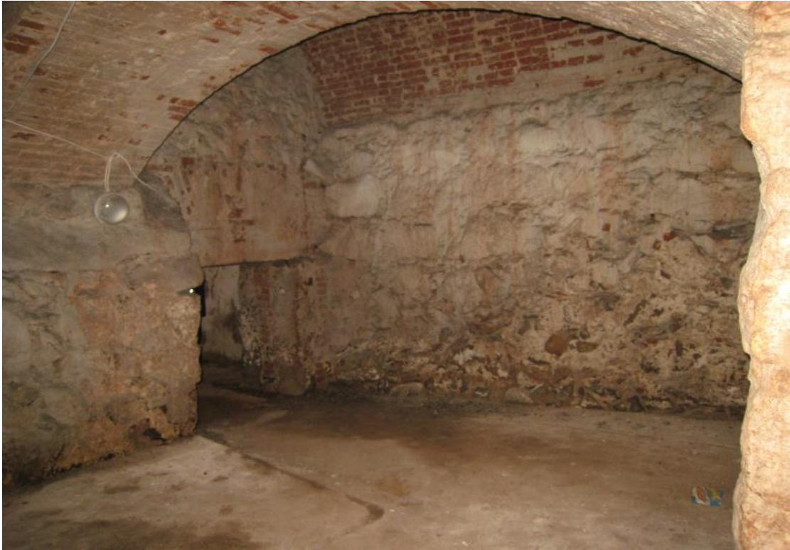
Foto nr.11 Vaade ruumist nr.1 ruum nr. 5 poole, näha graniidist sillusega ava ruumide 5 ja 6 vahel
