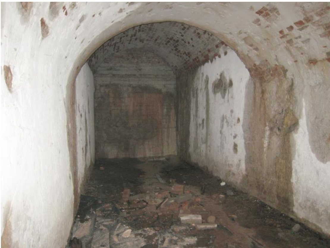
Foto nr. 16 Ruum nr. 8, vaade põhja suunas
