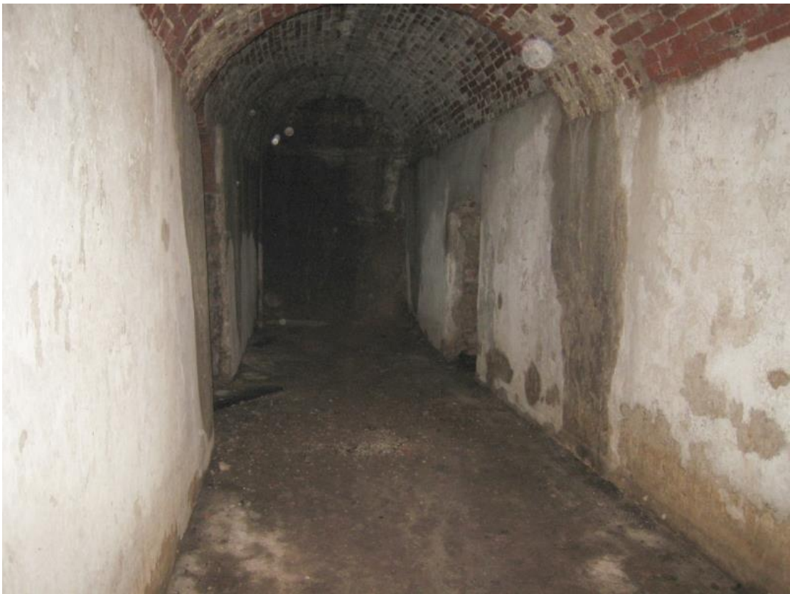
Foto nr.12 Ruum nr. 6, vaade põhja suunas.
