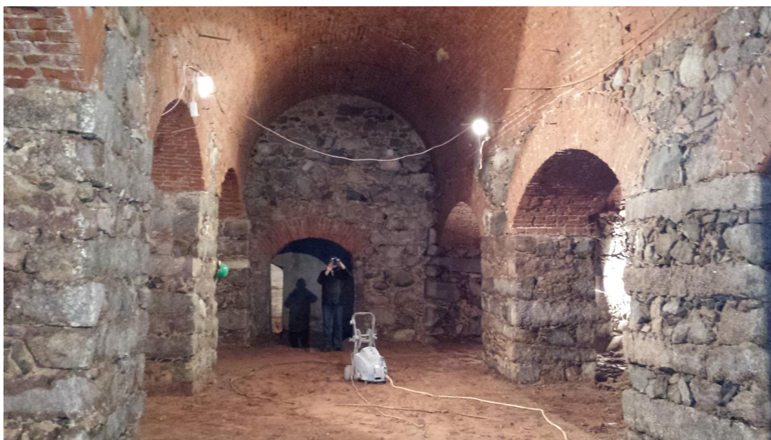
Foto nr. 1 Vaade ruumi nr. 1 Puhastatud seinad ja avatud kinnimüüritud uks. Laest on eemaldatud kanalisatsiooni toru.
