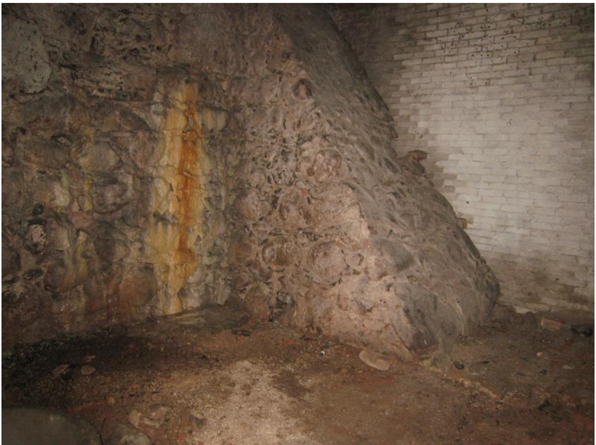
Foto nr.4. Ruum nr. 2, maakividest laotud kontraforss ja silikaattelistest vahesein.
