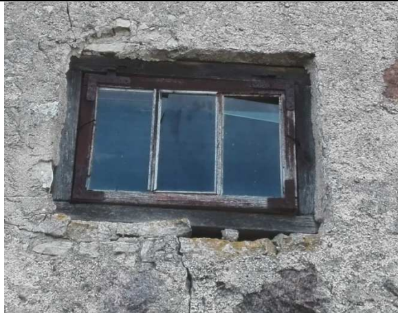
F 37: B-osa O-küljel II korruse aken: komplektne – ava, leng, raam, nurgikud/hinged.
