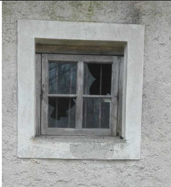
F 47: A1 N-küljel kuivatiruumi aken: krohviraaamistusega ava, leng, aknaraam. *Leng osaliselt hilisem, aknaraam tagurpidi ees, kuid võib olla ka algupärane.
