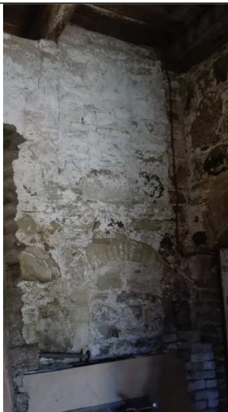
F 43: A2 N-küljel 2 kohati asuvat kinnimüüritud ava: välisküljel paiknevad trepi all; kinni müüritud varase ümberehituse käigus.
