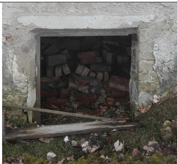
F 46: A1 N-küljel kütteruumi sissepääs: krohviraamistusega ava.
