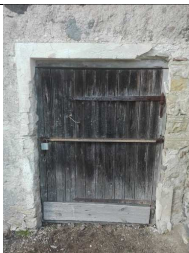
F 29: A2 S-küljel vahe ruumi uks: krohviraamistusega ava, leng, latthinged ja hingetapid. *Ukseleht hilisem
