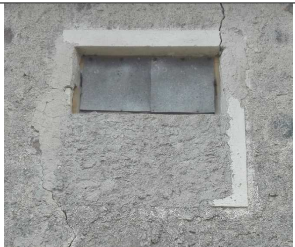
F 40: B-osa N-küljel osaliselt kinni müüritud aknaava: krohviraamistusega ava, leng.
