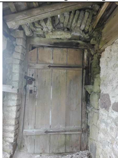
F 42: B-osa loodenurdas paiknev II korruse eluruumide uks: komplektne – ava, leng, ukseleht, latthinged koos hingetappidega + varikatus; algupärane viimistlus (ooker).
