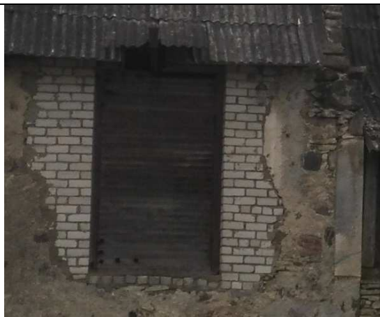
F 41: B-osa N-küljel hilisem ukseava: mingi väiksem ava on selles kohas ilmselt olnud (uksest paremal näha lõik krohviraamistust), kuid suur ukseava on sisse lõhutud nõuk.perioodil.
