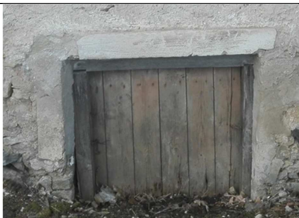
F 25: A1 S-küljel kütteruumi sissepääs: krohviraamistusega ava. *Luuk ja leng hilisemad
