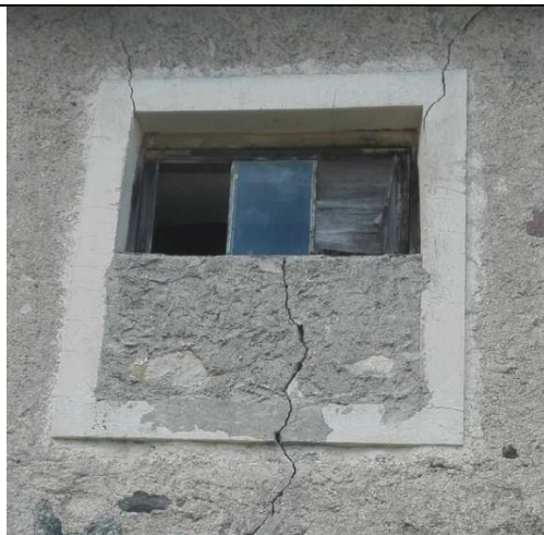
F 33: B-osa S-küljel osaliselt kinni müüritud aknaava: krohviraamistusega ava, leng
