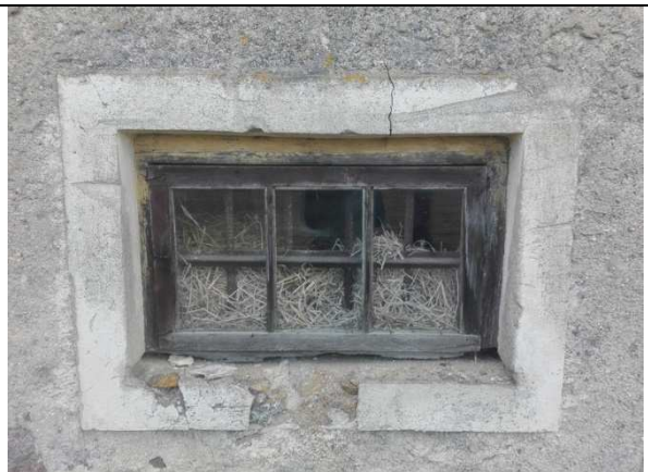
F 36: B-osa O-küljel I korruse aken: komplektne – krohviraamistusega ava, leng, raam, kantrauast trellid.
