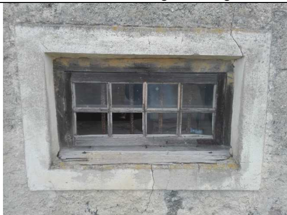
F 35: B-osa O-küljel I korruse aken: komplektne – krohviraamistusega ava, leng, raam, kantrauast trellid.
