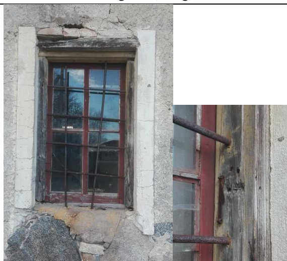
F 28: A2 S-küljel vahe ruumi aken: krohviraamistusega ava, leng, aknaraam, haak. *Ümarvardast trellid hilisemad.
