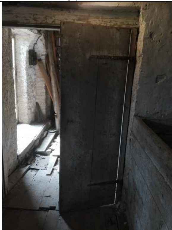
F 49: Aida ja vahe ruumi vaheline kahepoolne siseuks: lõunapoolne uks komplektne – leng, uksed, latthinged koos hingetappidega.
