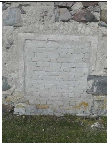
F 34: B-osa S-küljel kinni müüritud ukseava
