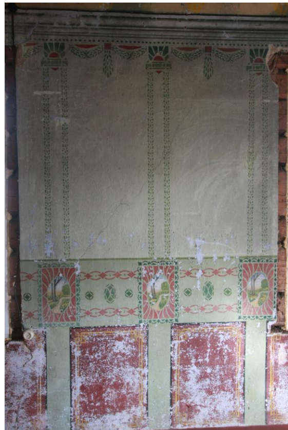
Illustr. 29 – maalinguga tahveldus kahe akna vahel. Akende vahetamise käigus on kaduma läinud akna ja krohvipinna vaheline puitlatt.
