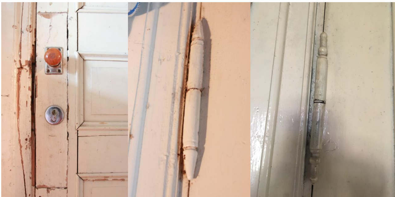
Illustr. 129 jõhkralt eemaldatud ukse lukk ja link, asendatud käepäraste vehanditega, vajalik uus korrektne puidu plommimine.
