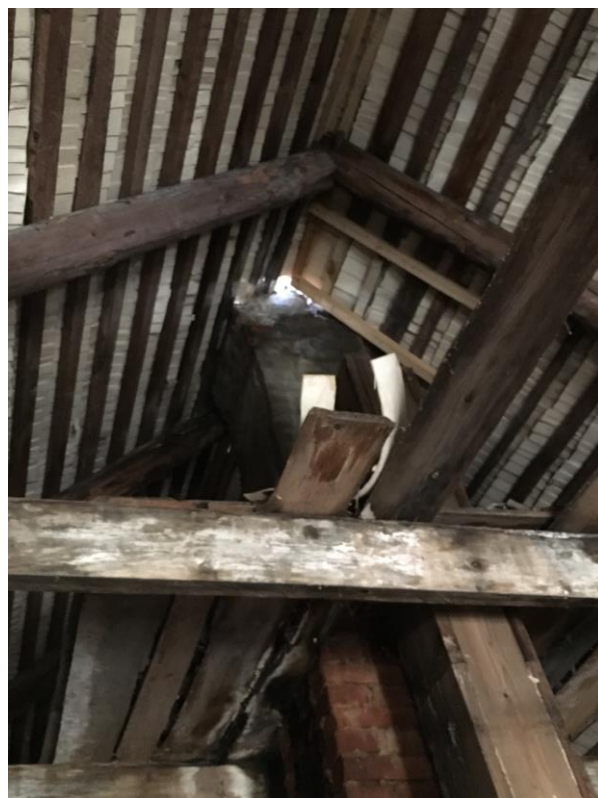
Illustr. 93 puitdetailidega fikseeritud vertikaalne korstnasammas.
