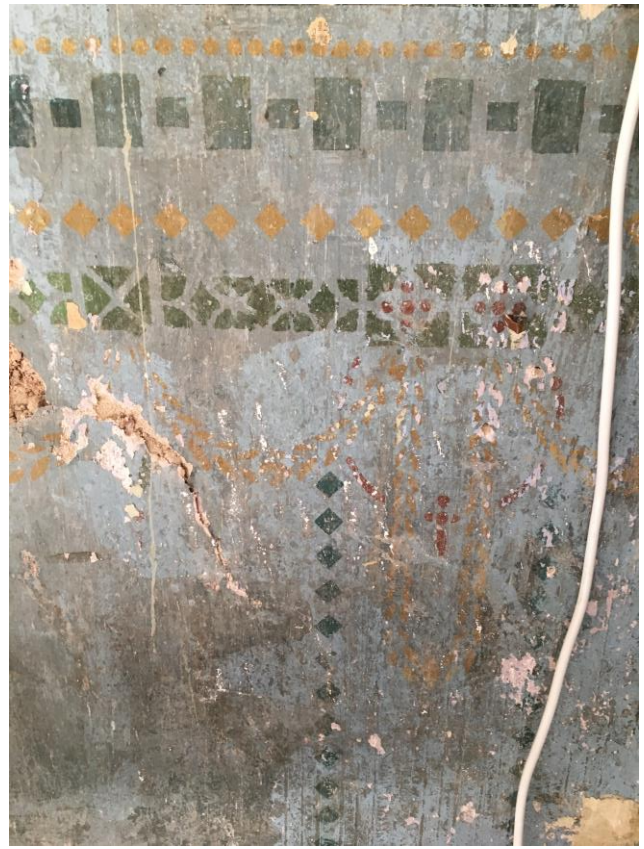
Illustr. 38 – mustuse ja tolmuja kaetud maalingu detail sokli osas.
