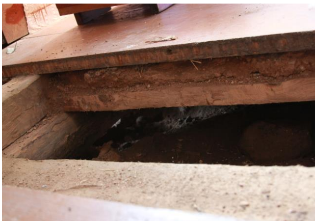
Illustr. 78 põrandakonstruktsioon. Illustr. 79 laudpõrand 320mm lai.
