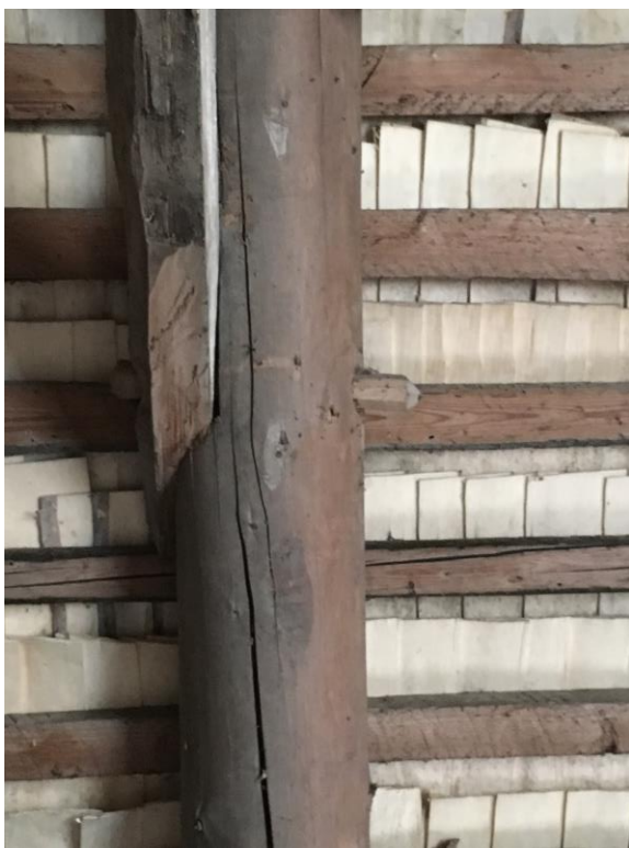
Illustr. 84 -katusekatte laast on kolmekordne, tihe roovituse samm. Sarikate sidumise detail pulkfikseerimise näol.
