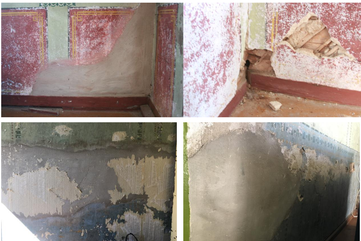
Illustr. 97 tsemantkrohviga parandatud pinnad saali seinas.
