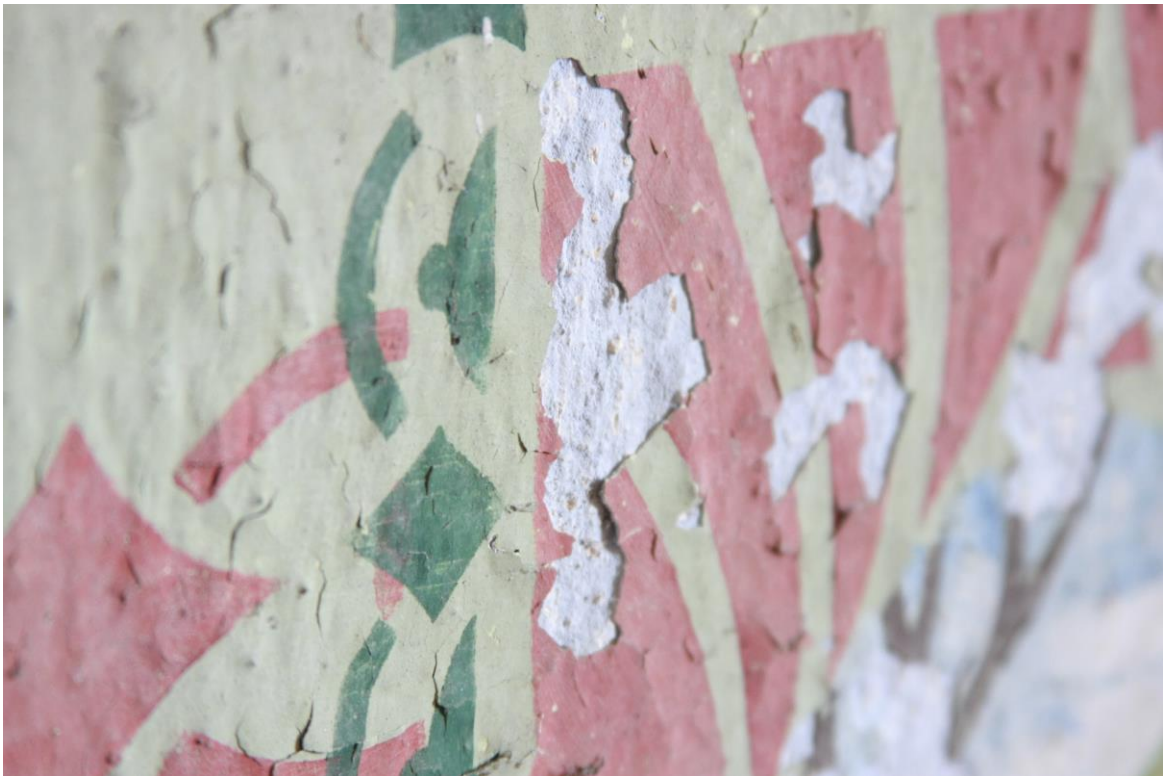
Illustr. 123- saali sokli osa lahtised pudenevad värvipinnad, mis tuleks paraloiditada 9 . Illustr. 124- krundipinnast irduv värvipind saalis, võimalik taastada süstimise meetodil.
