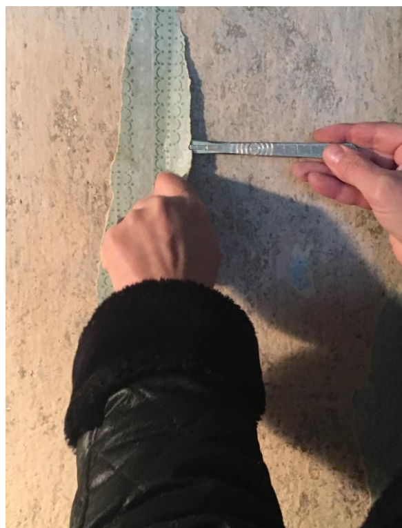
Illustr. 125; Illustr. 126- mag. Toa maalingutelt tapeedi eemaldamine. Illustr. 127–söögitoa maalingutelt tapeedi eemaldamine skalpelliga.
