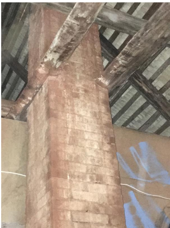
Illustr. 93 puitdetailidega fikseeritud vertikaalne korstnasammas.
