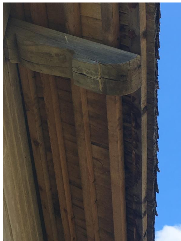
Illustr. 84 -katusekatte laast on kolmekordne, tihe roovituse samm. Sarikate sidumise detail pulkfikseerimise näol.
