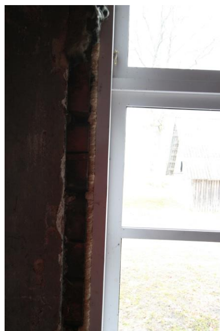
Illustr. 89 kuueruudulised aknad; Illustr. 90 kitsamad kolmeruudulise aknad; Illustr. 91 uued aknad seest; Illustr. 92 kaduma läinud aknaümbrise piirdeliist krohvi ja lengi vahel.
