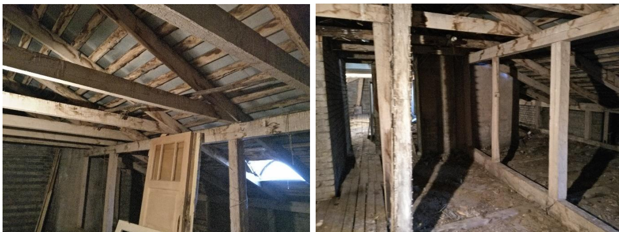
Illustr. 39, 40 – Olemasolevad katusekonstruktsioonid ja taamal uuk-aken
