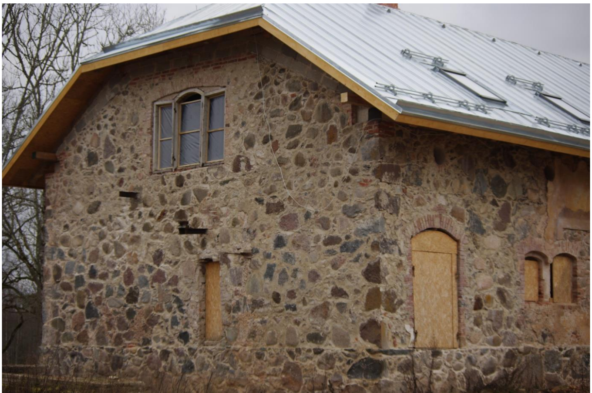
22. Meierei valtsplekk-katus uute katusakendega.
