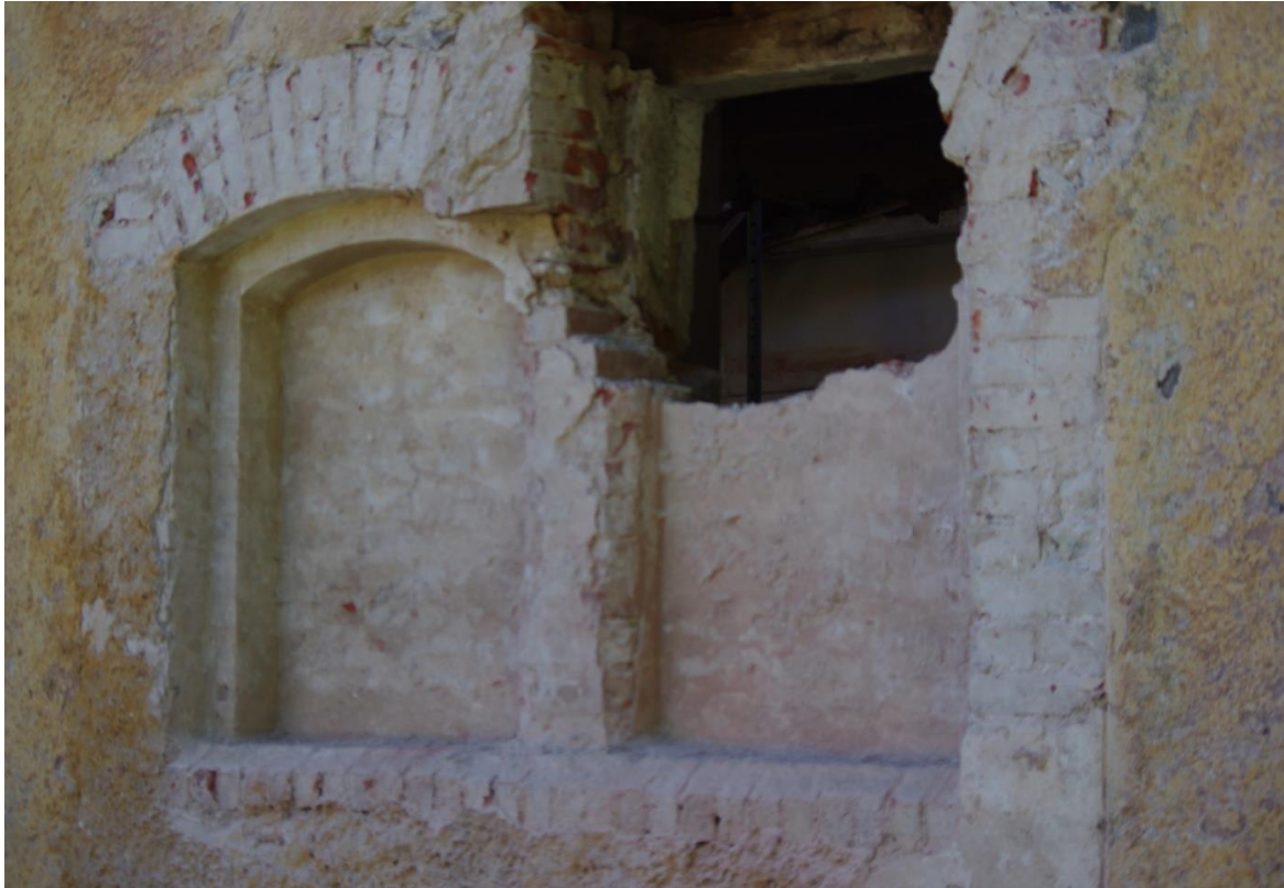
19. Meierei läänepoolne sein pärast krohvi ja telliste eemaldamist.
