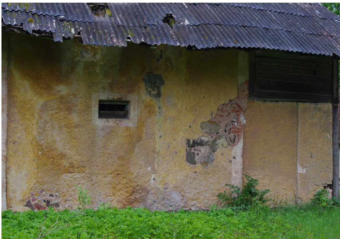
18. Meierei läänepoolne sein enne krohvi ja telliste eemaldamist.
