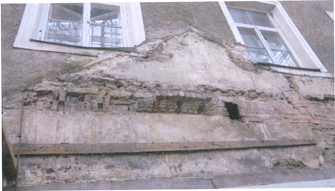
5. 2016.a mõisa lammutamisel leitud korruste vahelised katusekivide ja -karniisi fragmendid. Foto K.Raudla
