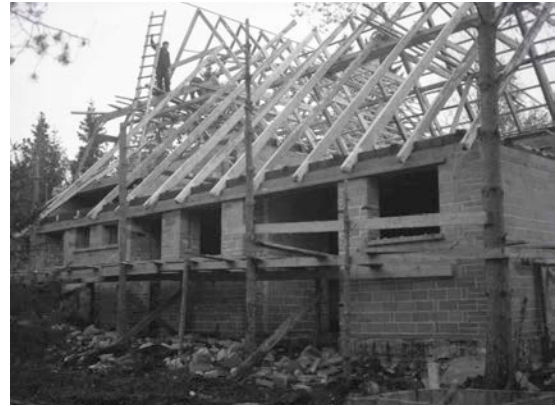
III 9. Sarikate püstitamine, elamu esivaade 1937. (Eesti Arhitektuurimuseum F22.N8.S8.6.1)
