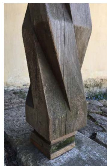
Ill. 51. Varikatuse tugiposti detail (autori foto)
