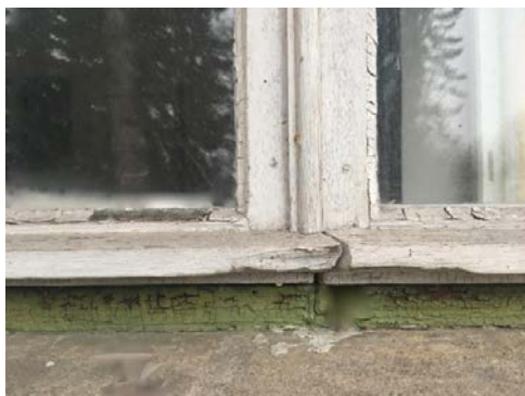
III 58. Akna detail (veelaud ja tuuleliist) (autori foto)
