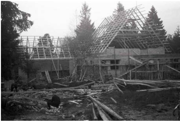
III 9. Sarikate püstitamine, elamu esivaade 1937. (Eesti Arhitektuurimuseum F22.N8.S8.6.1)
