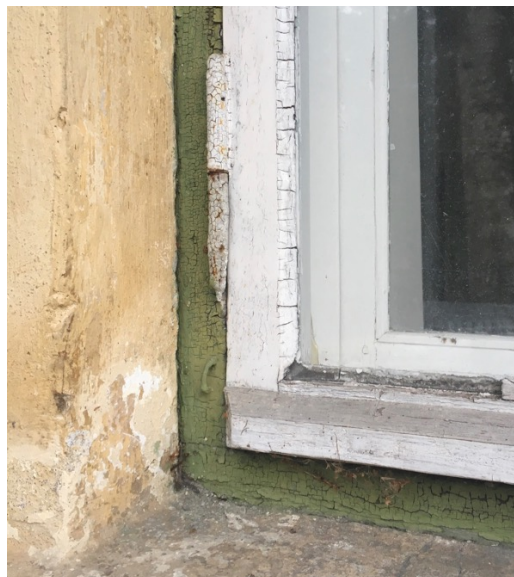
III 59. Akna detail (hing ja veelaud) (autori foto)
