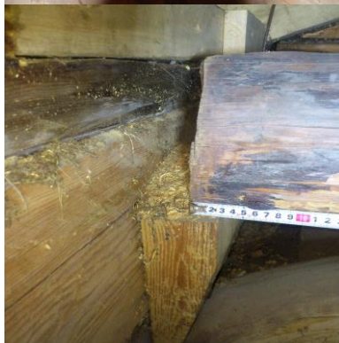
F.5/ 5.1 Aamtala tugiklots kahel sepis naelal, põhjaseina idapoolt esimene talaots. Nb! Olukord on vaja inseneril lahendada.
