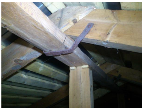
Algupärane katuse tarind koos uue katuseplekialuse hõre roovlaudisega. Vaade kirde- idasuunas.
