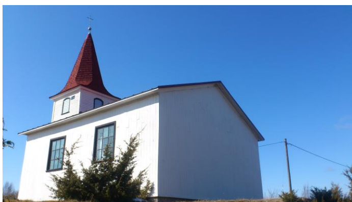
Vaade kagust, Lõunafassadil kaks keskmise suurusega, üheksa väikese ruudujaotusega akent. Punaseks tõrvatud tornikiiver.
