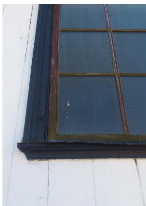
Kiriku saaliakent ümbritsev profileeritud ehisliist koos plekialuse karniisiga. Akna põskpuult irduv värvikiht ja sepistatud akna kinnitushaak.
