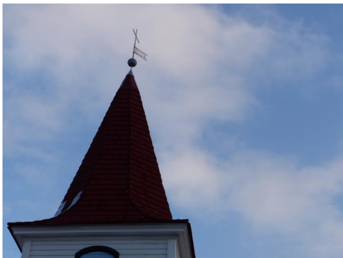
Värskelt restaureeritud kiriku tornikiivrit ilmestab punase pigmendi lisandiga tõrvatud puidust kimmkatus. Foto aprill 2017 (restaureeriti suvi)
