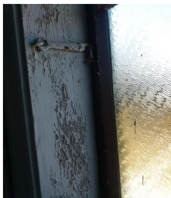
Kiriku saaliakent ümbritsev profileeritud ehisliist koos plekialuse karniisiga. Akna põskpuult irduv värvikiht ja sepistatud akna kinnitushaak.
