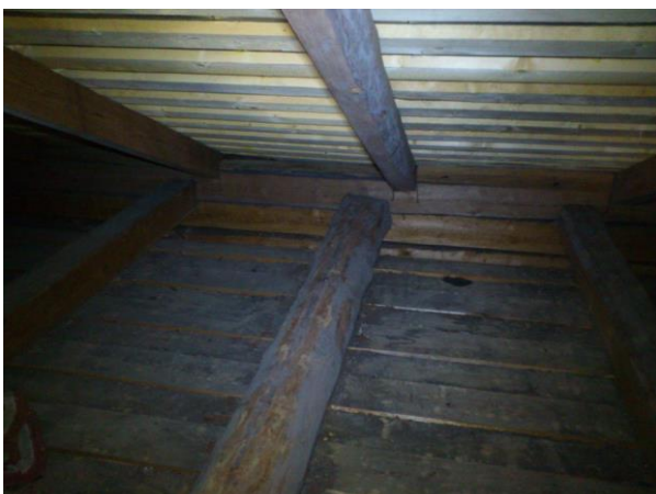
Kiriku ümarpalk- ja tahatud aamtalad ning katuse sarikad. Samuti asendatud uus katuseplekialune hõre roovlaudis. Vaade lõunasse.
