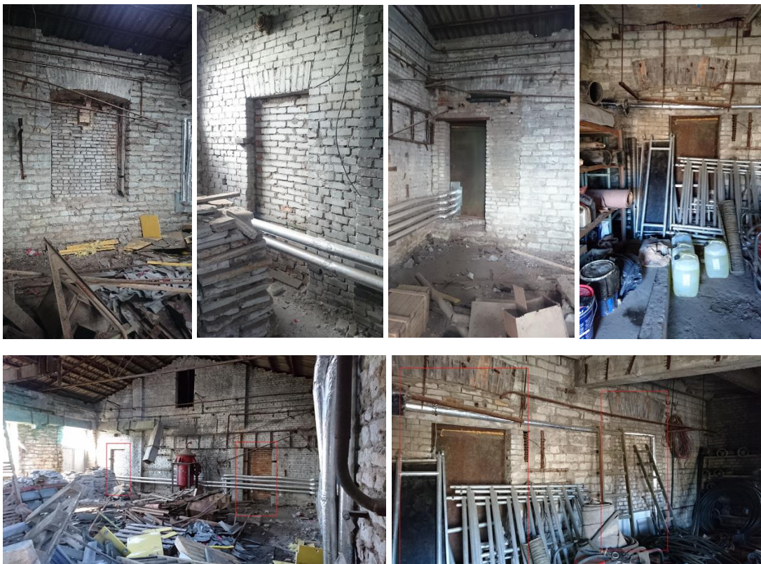
Fotod 35-40. Destillatsioonihooned sisemised vaheseinad (autor I. Sildma, 28.04.2017)
