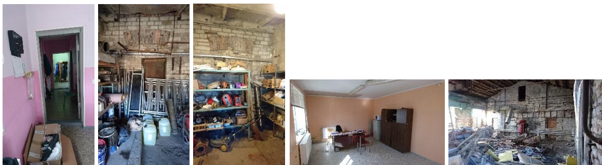
Fotod 68-72. Destillatsioonihooned pörandad (autor I. Sildma, 28.04.2017)
