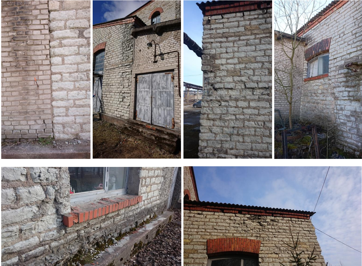
Fotod 29-34. Destillatsioonihooned välisseinad (autor I. Sildma, 10.03.2017)
