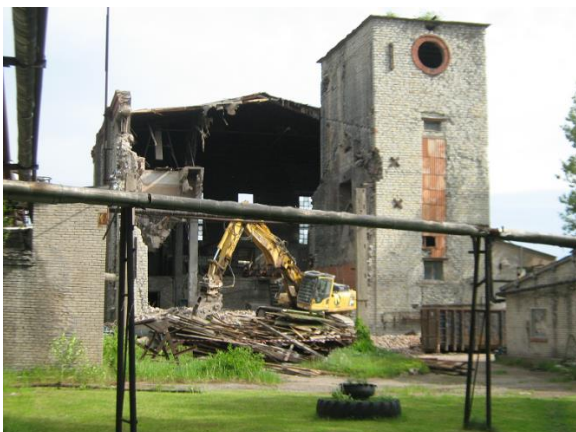
Foto 17. KKT vana katlamaja lammutustööd (foto autor Illar Sildma, 12.03.2013)
