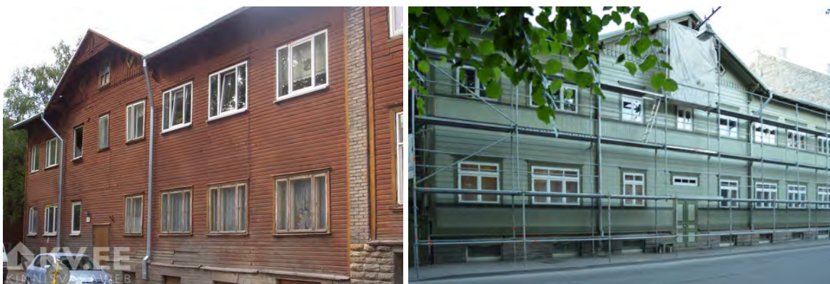
29–30. Niine 4 Kalamajas säilitas pärast majavalitsuse remonti oma algsest ilmest vaid frontooni puitpitsilise kujunduse esi- ja tagafassaadil. Tänapäeval on muudetud laudisemustrit ja paigaldatud framuugiga aknad, muutmata sealjuures nende nõukogudeaegseid gabariite. Uued aknad meenutavad rõhtsa masside jaotusega varast modernismi, ent raamide jagunemine framuugiks ja käiguraamideks tekitab siiski seose historitsismi ehk maja algse arhitektuurstiiliga. KV.EE kinnisvarablog/autori foto, juuli 2015.
