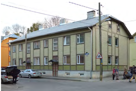
48–50. Graniidi 26 fassaadide renoveerimise projekt ning hoone ilme tänapäeval. TLPA/autori foto, mai 2016.
