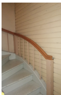
Katuse alla viiv puidust trepp (33)
