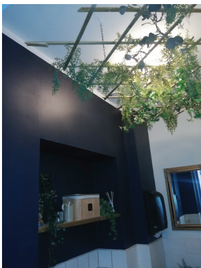
Allatoodud lagi I korruse WC-s (46)
