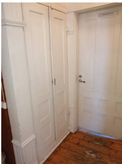
II korruse sisseehitatud kapi ukсед ja kabineti uks (23)
