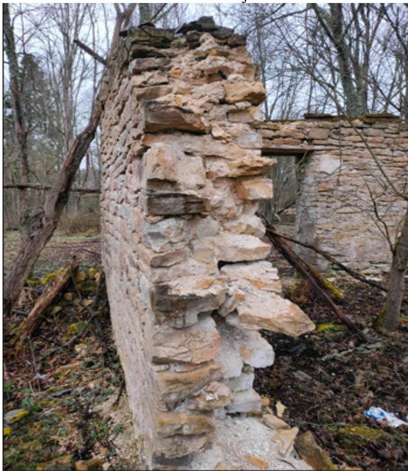
Pilt 19. Nii-öelda kahe kihiline müür ja vahe täidetud lubimördi ja väiksema kvisogaga
