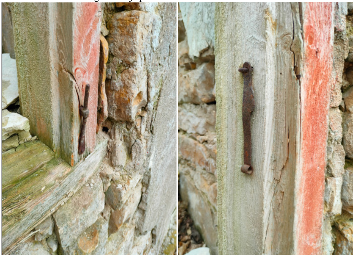
Pilt 14 säilinud aknahinge detail ja pilt 15. Aknahaak
