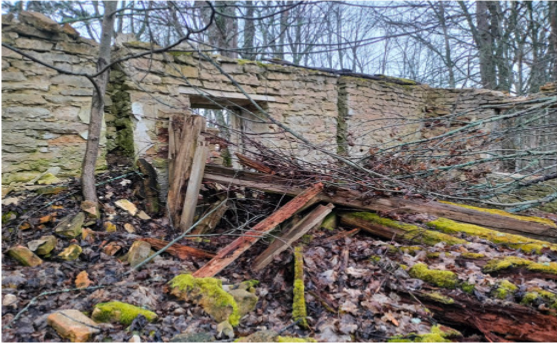
Pilt 11: välisseina siseküljel paiknevate vaheseinasoontega ja puitplangust aknasillus. Autori pilt
