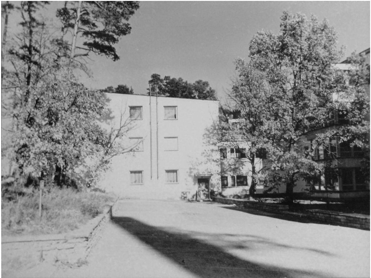
Ill 61. Basseini korpuse kül ning II korpuse fassaad. 55
