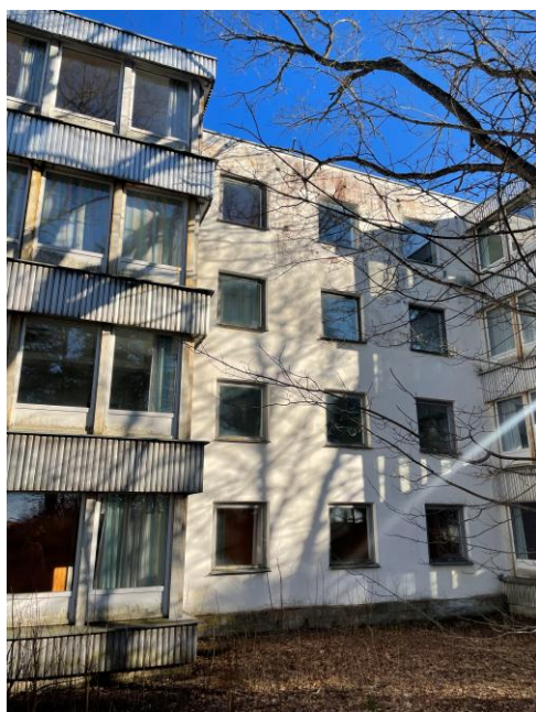
Ill 72. Vaade II korpusele mere suunast (IV.2025)
