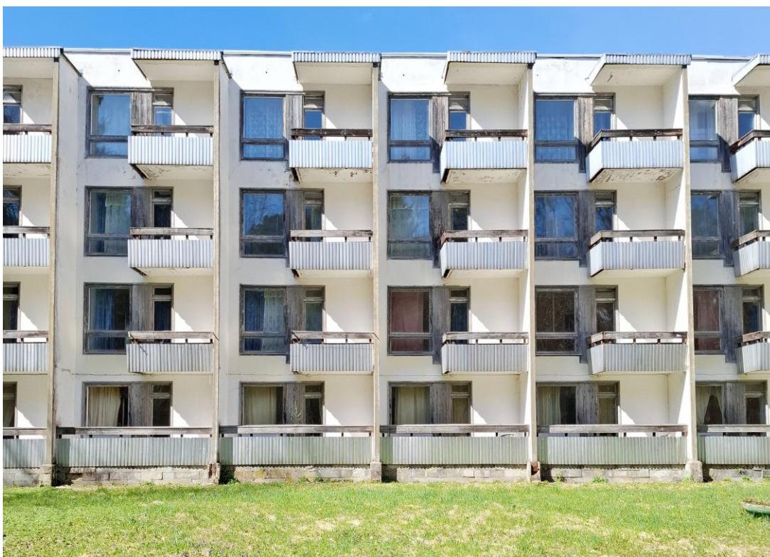
Ill 81. II korpuse sademesüsteem (pilt IV. 2025)
