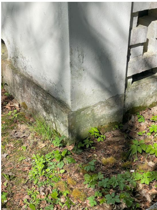
Ill 65. I korpuse vundament (pildistatud IV. 2025)
