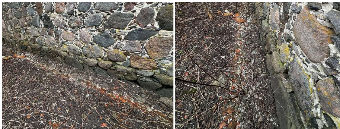
38. ja 39. Keldri vundament. Autori fotod 09.04.2025
