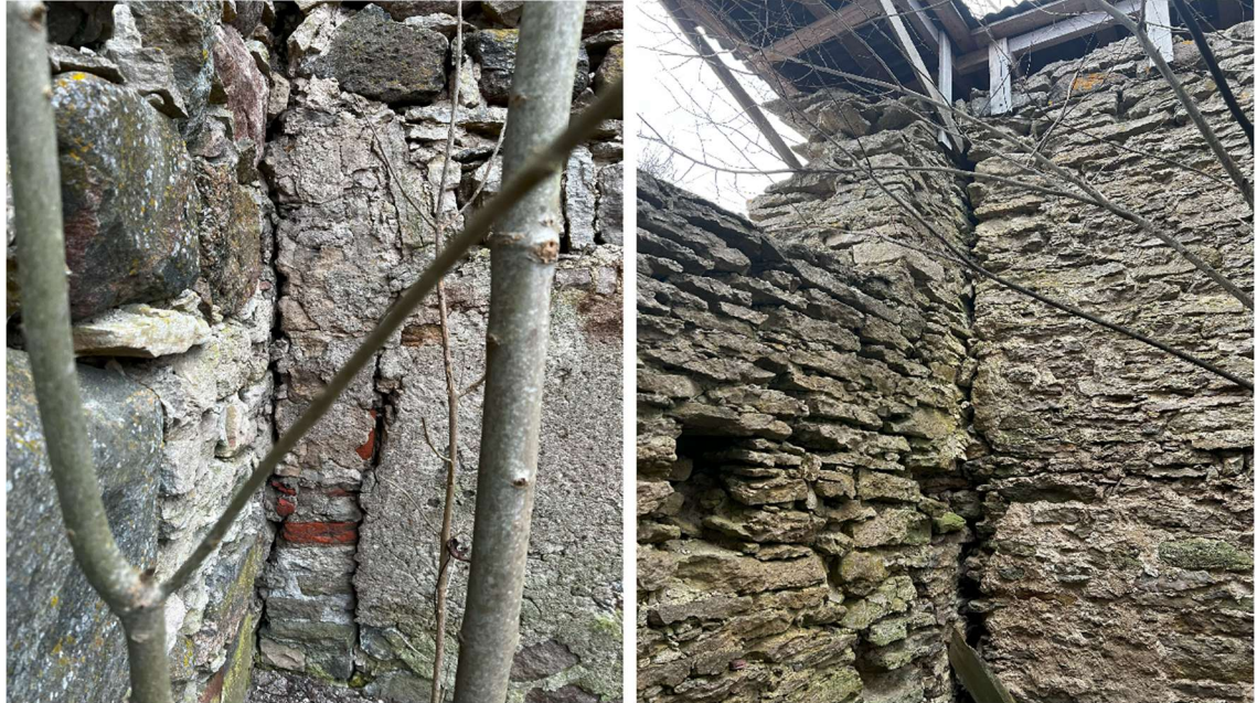
24. ja 25. vaheseinte liitumine välisseintega, autori fotod 09.04.2025
