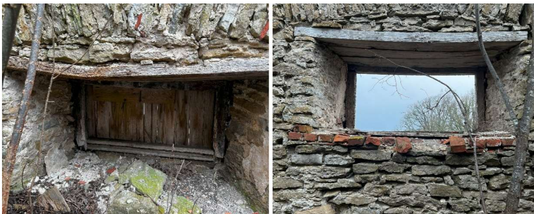
31. ja 32. põhja fassaadi avad. Autori fotod 17.04.2025
