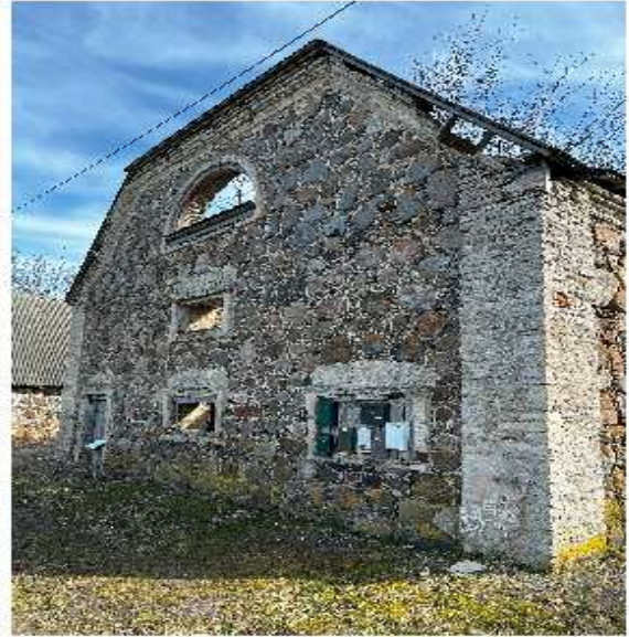
17. Vaade põhjast. Autori foto 09.04.2025
