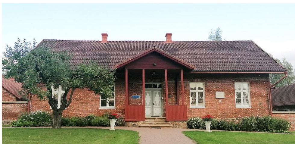
Foto 57. Varbuse postijaam 2023. Foto: S.Raidvere.
