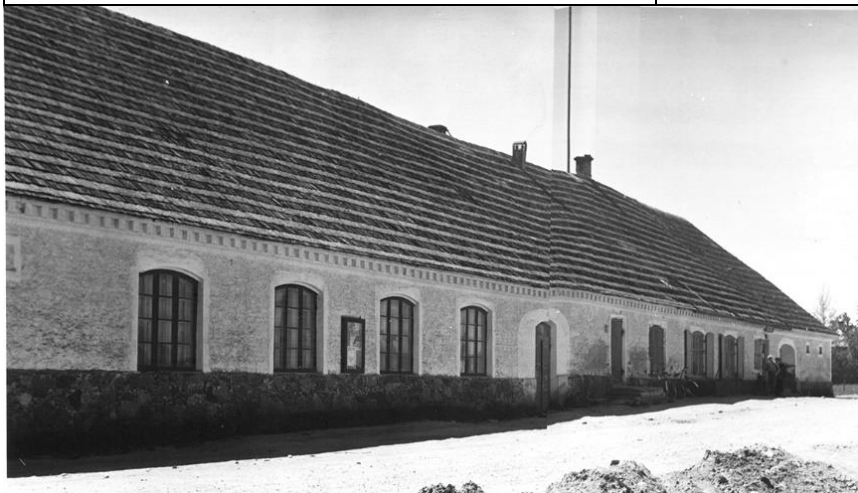
Foto 19. Hargla kõrts 1963. Foto: K.Aluve.
