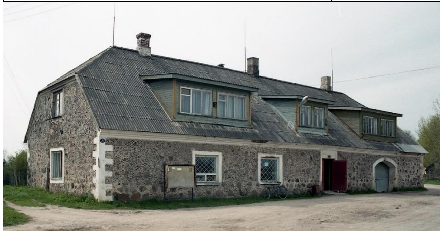
Foto 196. Voldi kõrts-postijaam 1997. Foto: J.Vali
