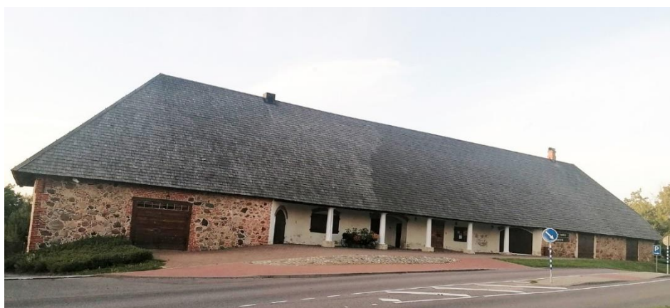
Foto 177. Vastseliina kõrts-postijaam 2023. Foto: S.Raidvere.
