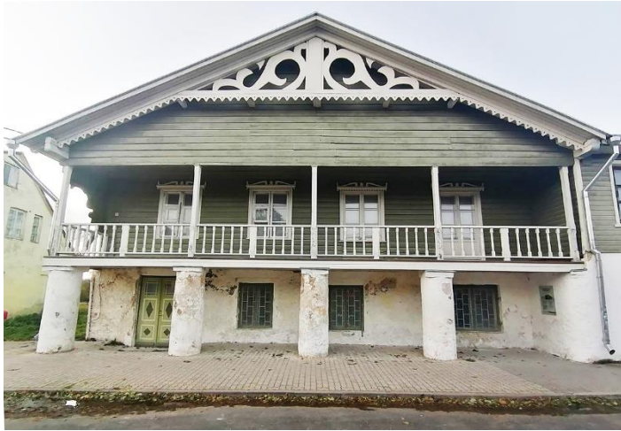
4. Lihula Jaani kõrtsi puidulõike ehisedetailid kui mittefunktsionaalsed ning sambad, kui funktsionaalsed detailid. Foto: S.Raidvere 2023.
