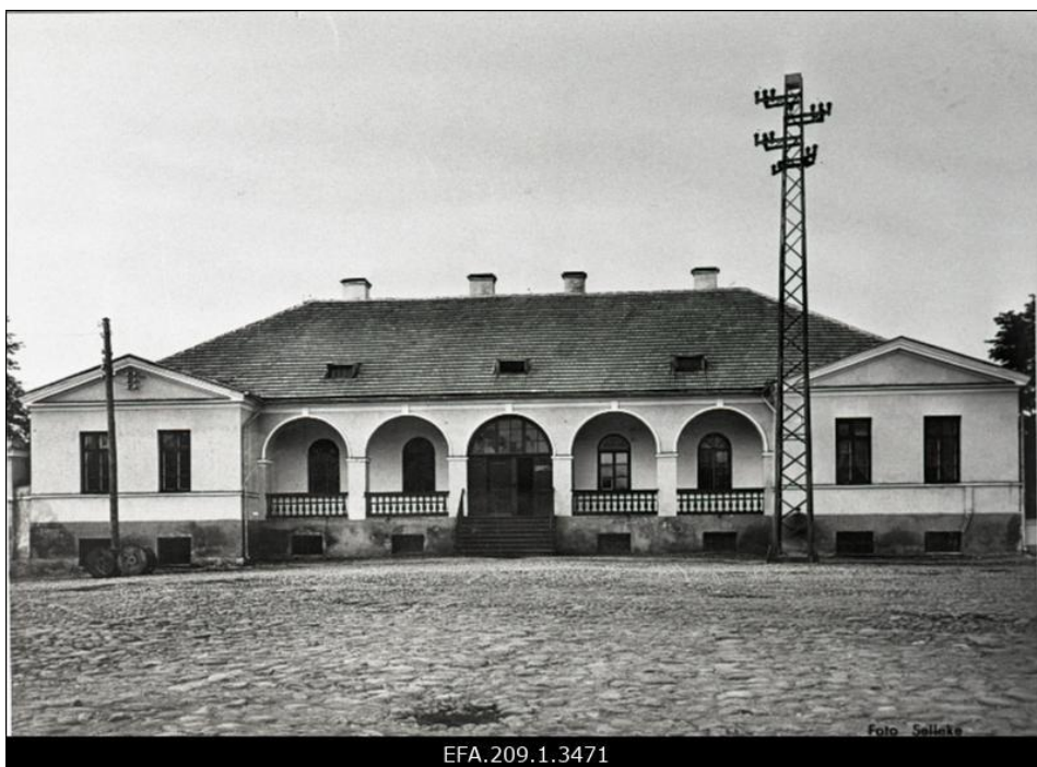
8. Tartu postijaama hoone enne lammutamist 1939. aastal. Foto: C.Sarap.
