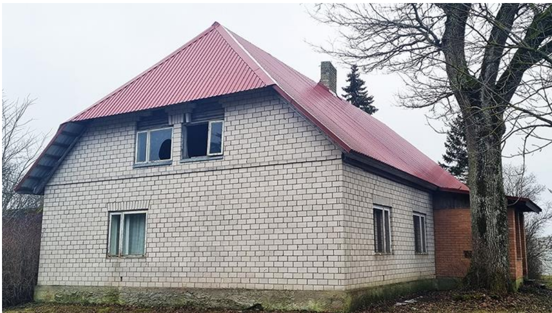
24. Turpla postijaam Läänemaal. Seinad kaetud silikaattellistega, avatäited ja veranda täielikult muudetud, ehisdetailid kadunud. Foto: T.A.Raidvere, 2024.
