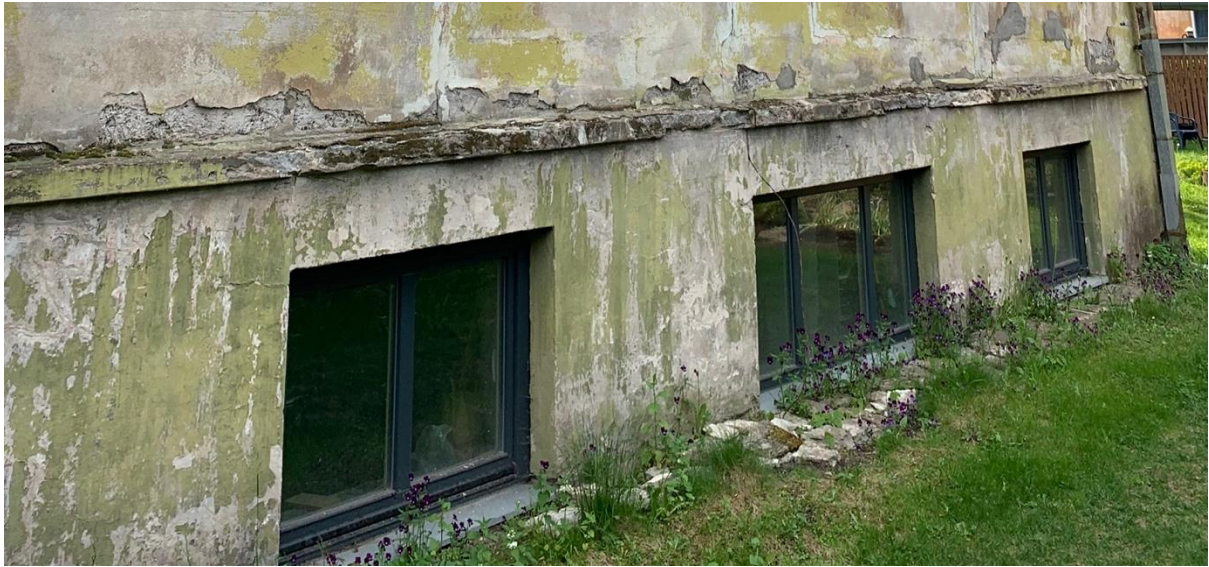
Foto 11. Sokkel ning soklivöö (Allikas: autor)
