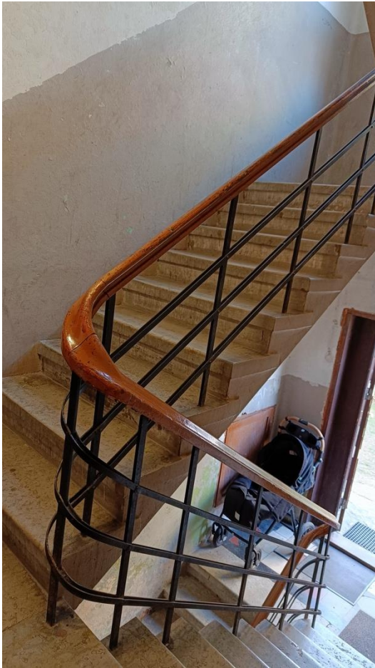
Fotod 31. Paekivist trepiastmed, metallist trepiire koos puidust käsipuuga (Allikas: autor)
