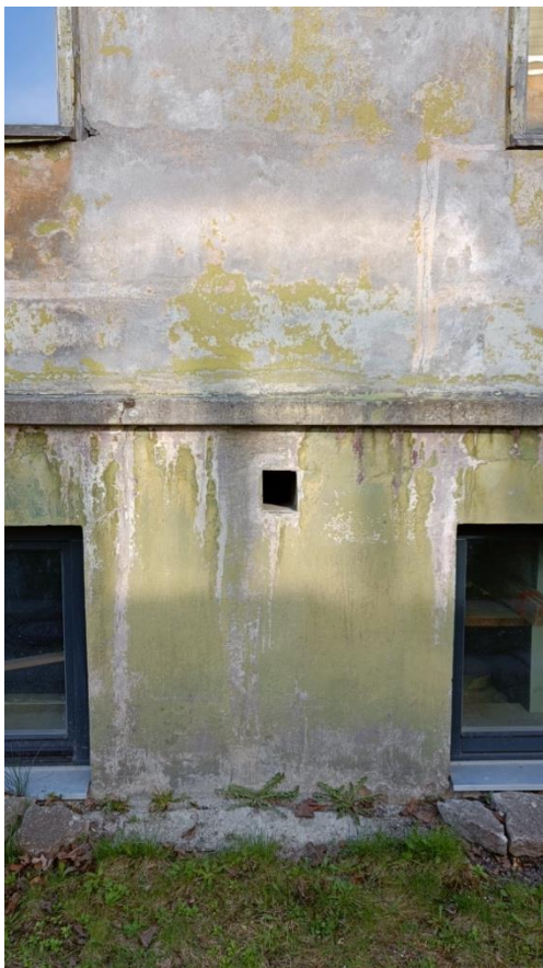
Foto 12. Ventilatsiooniavad soklis (Allikas: autor)
