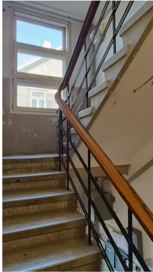
Fotod 31. Paekivist trepiastmed, metallist trepiire koos puidust käsipuuga (Allikas: autor)
