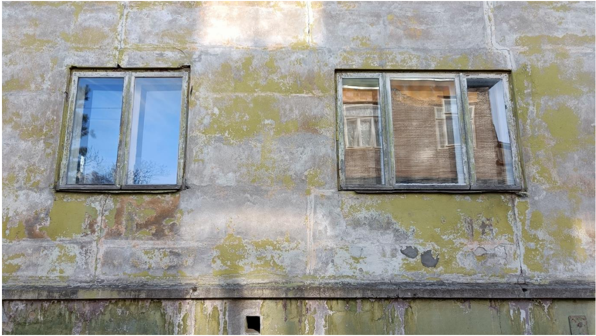
Foto 32. Vanad originaalsed puitaknad (Allikas: autor)
