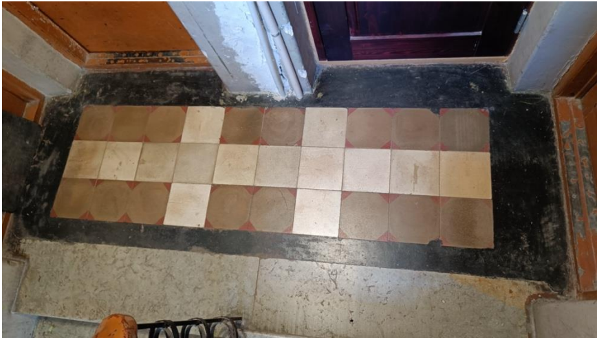
Foto 26. Kahhelplaadid 1. korruse trepimademel (Allikas: autor)
