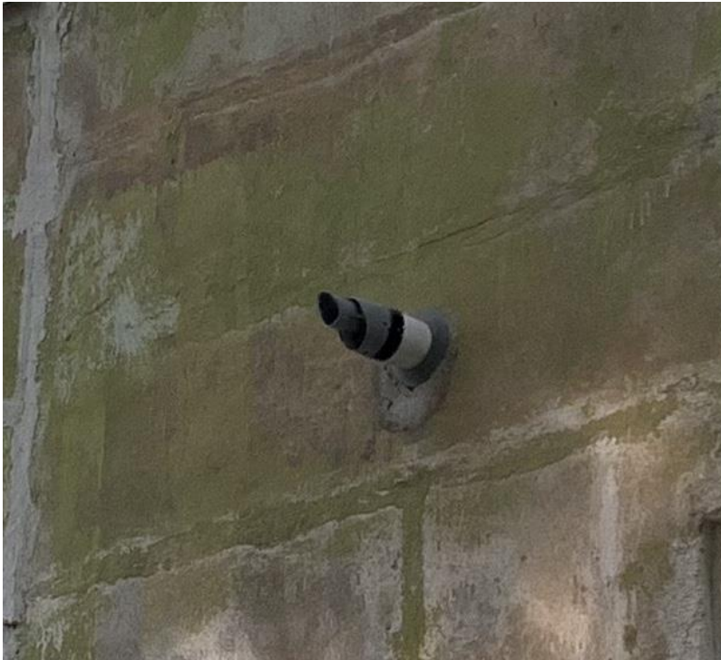
Foto 24. Gaasikatla turbokorstna läbiviik (Allikas: autor)
