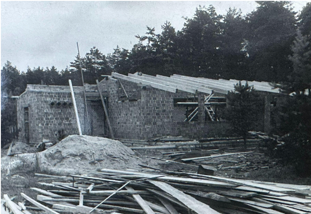
37. Ehitusaegne pilt seinakonstruktsioonidest
