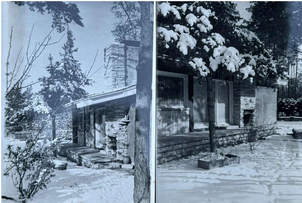
41. Talvine vaade terrassile paekivist kaminale. Vasakpoolsel fotol näha ka paekivi ladu kuni korstna tipuni. Foto tehtud ehitusjärgselt, aasta ei ole teada.
