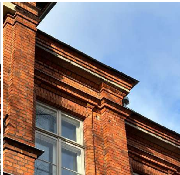
Foto 14. Tänavapinnalt vaadeldav katuseplekk ja räästas.
