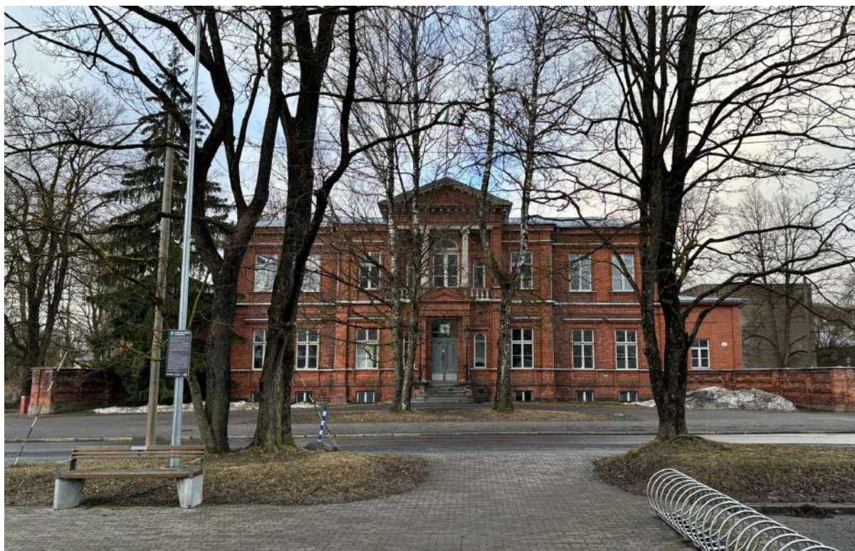
Foto 5. Konvendihoone esifassaad ja ettesõidutee müüritis Tähe tänavalt vaadates. Autori foto
