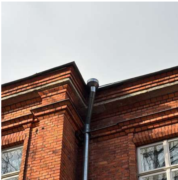
Foto 13. Tänavapinnalt vaadeldav sadeveesüsteem hoone esifassaadil.
