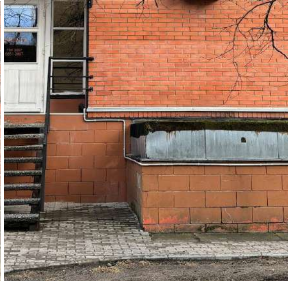
Foto 11. Juurdeehitatud mahu soklikorru. Esineb niiskuskahjustusi. Autori foto
