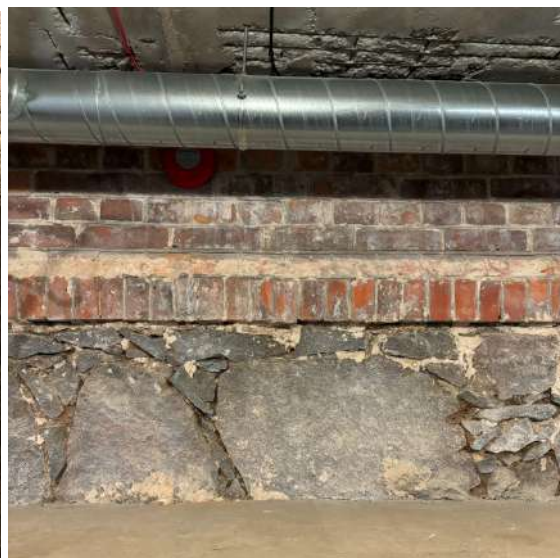
Foto 26. Keldrikorrusel kuvatavad vundamendi kihid. Autori foto
