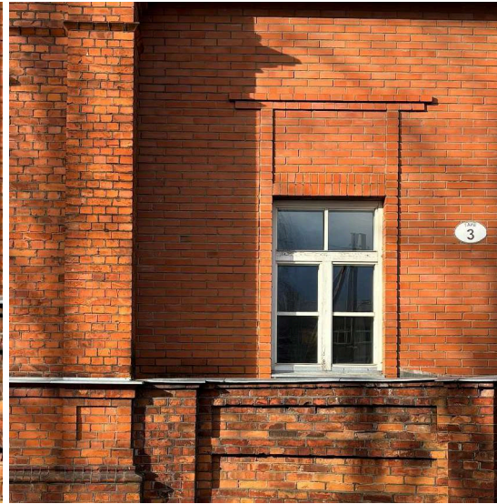
Foto 7. Juurdeehituse esifassaadi lihtsustatud aknakarniis. Külgfassaadid järgivad sama valemite. Autori foto
