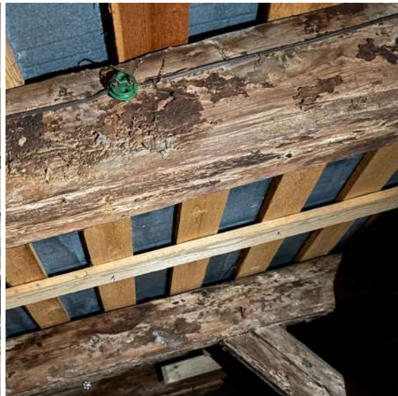
Foto 16. Katuse (pööningu) puitkonstruktsioonid. Autori foto
