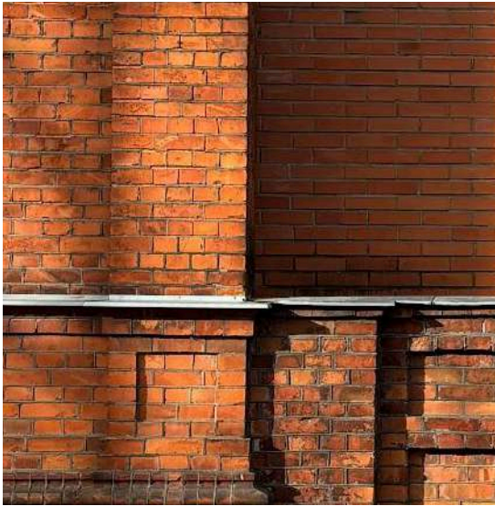
Foto 6. Esifassaadi originaalmahu (vasakpoolne eenduv pilaster), aiamüüri (alumine värvuselt tumedam müüritis) ja juurdeehituse kohtumisala. Autori foto
