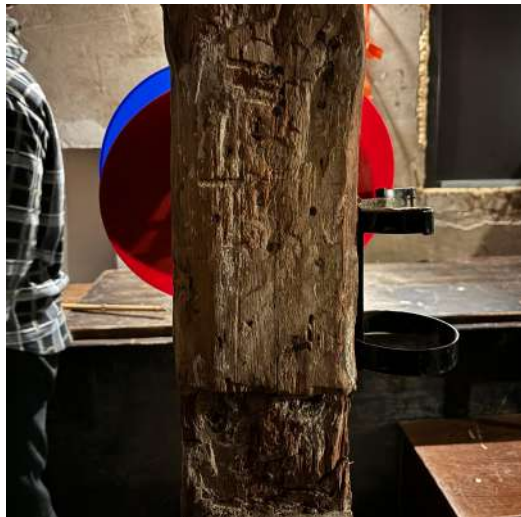
Foto 28. Pööningu puitkonstruktsiooni tala. Autori foto
