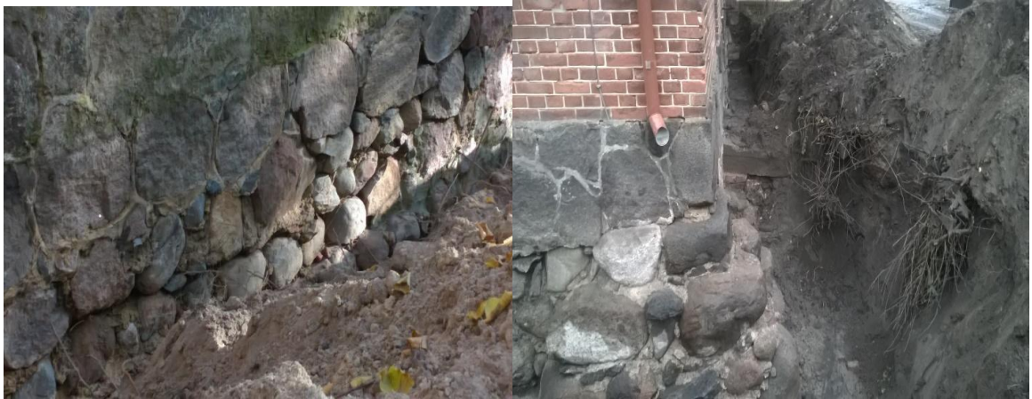
Foto 3. Nikolai 26 vundament. (Allikas: Autor)
