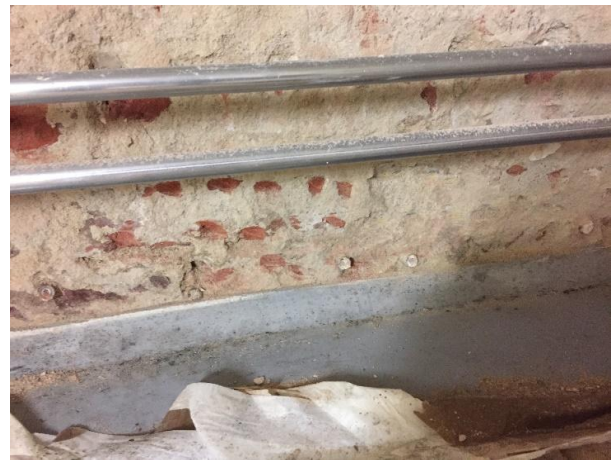
Foto 8. Vundament hoone sees (Allikas: Autor)
