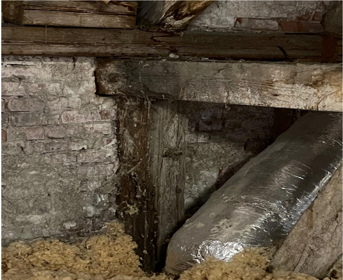
Foto 15. Nikolai 26 katusekonstruktsioon (Allikas: Autor)
