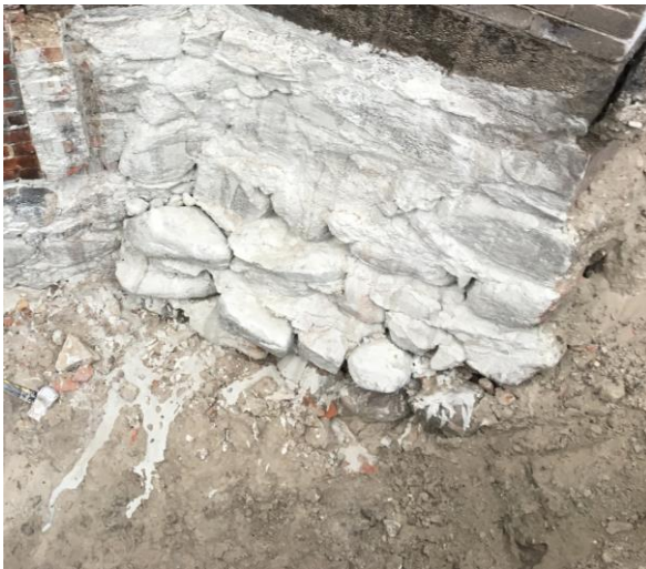
Foto 4. Nikolai 26 vundament (Allikas: Autor)
