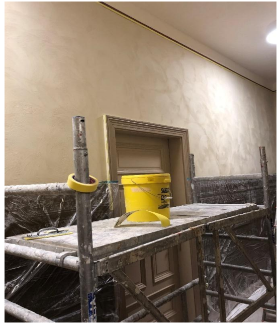
Foto 20. Maha kukkunud krohv (Allikas: Autor) Foto 21. Viimistletud sein (Allikas: Autor)
