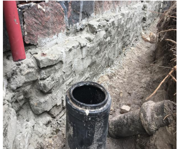
Foto 5. Nikolai 26 vundament (Allikas: Autor)
