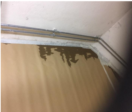
Foto 7. Vundament hoone sees (Allikas: Autor)
