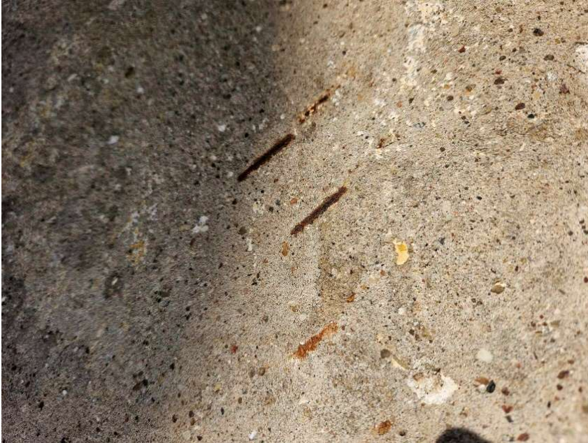
Betoonkrohv, mis on armeeritud raudvõrguga (ill 48)
