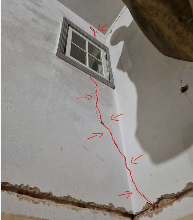
Pragu diafragmaseinas, mis on tingitud puudevast vundamendist (ill 20)
