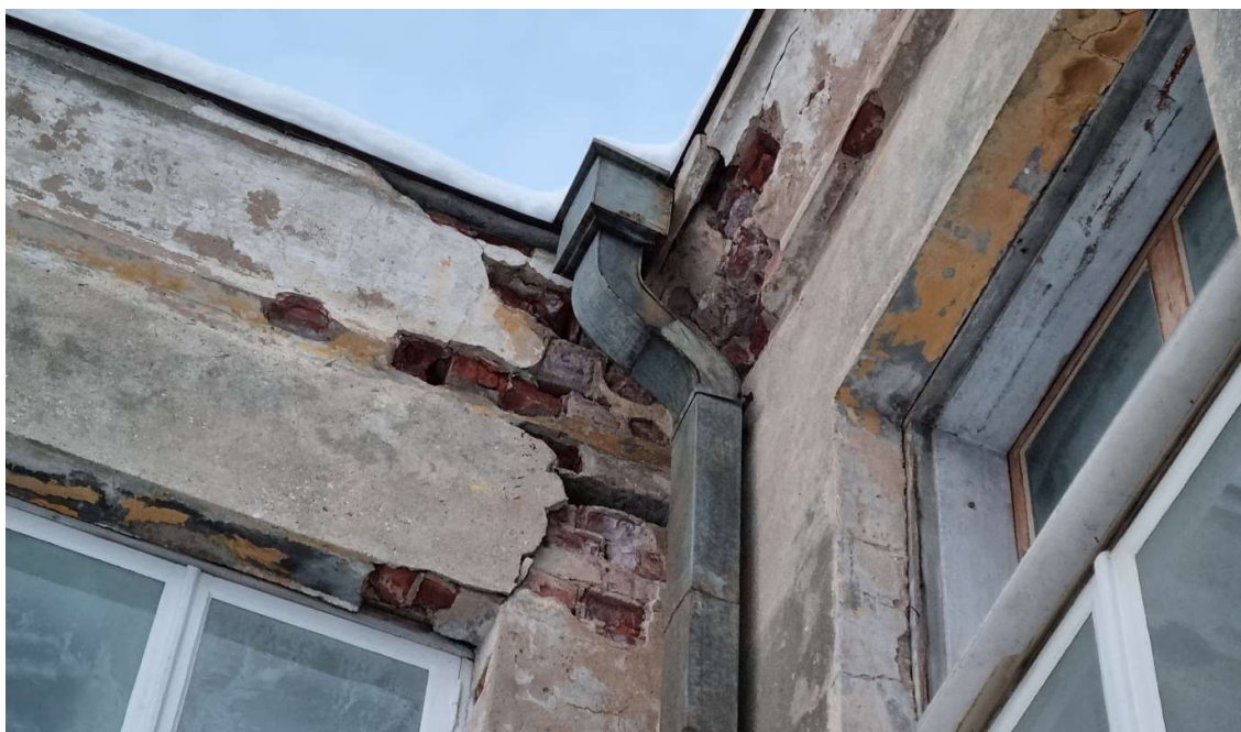
Hooldamata sadevetesüsteemist tekkinud kahjustus (ill 13)
