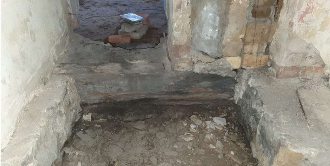
Paremal pool on korsten, mis toetud põrandatalale \frac{1}{4} ulatuses (ill 24)
