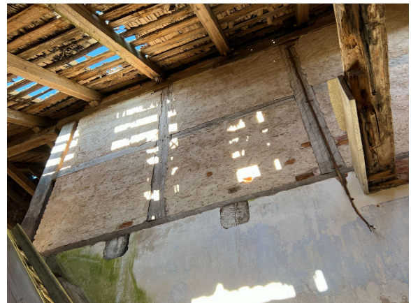
Joonis 29. lõunapoolsete kortertubade vahvärksein.
