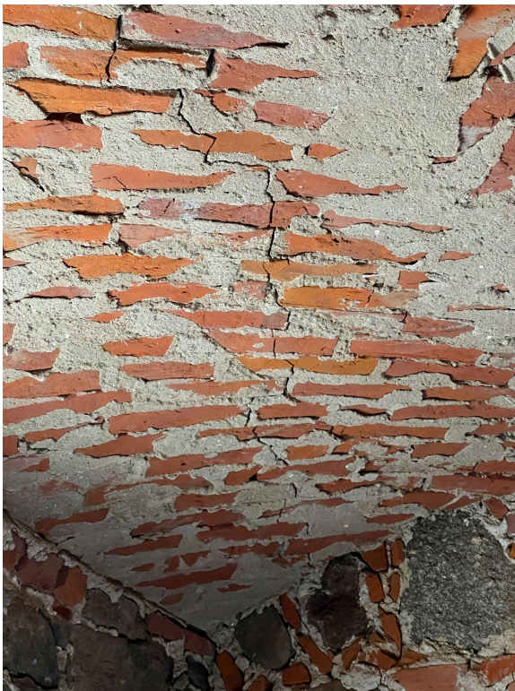
Joonis 34. Mõra keldri tänavapoolses võlvis.
