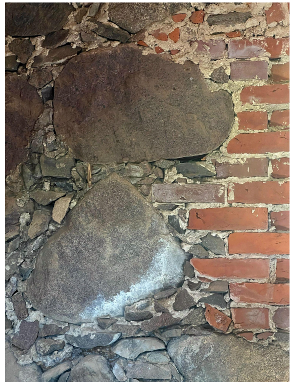
Joonis 35. Soolade ladestumine keldri läänepoolsel seinal.
