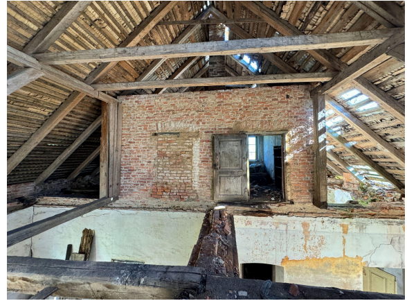
Joonis 49. Vaade kortertubadele jõe suunas. üleval toolvärgi pennid.
