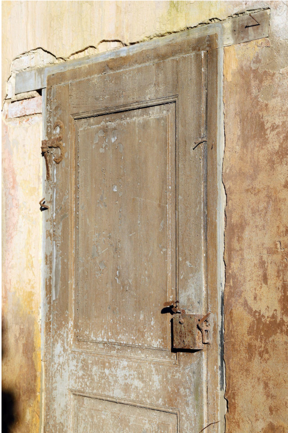
Joonis 62. Uks hoone lagunenu osas.
