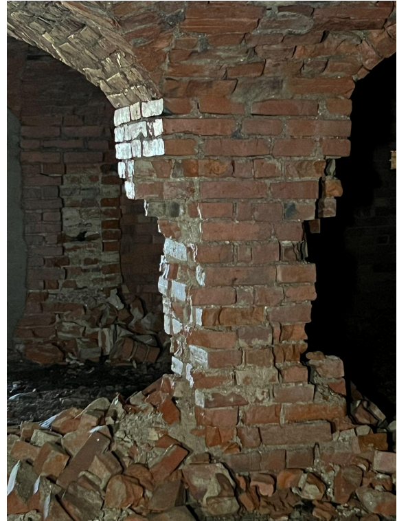
Joonis 105. Lagunev tugipost
