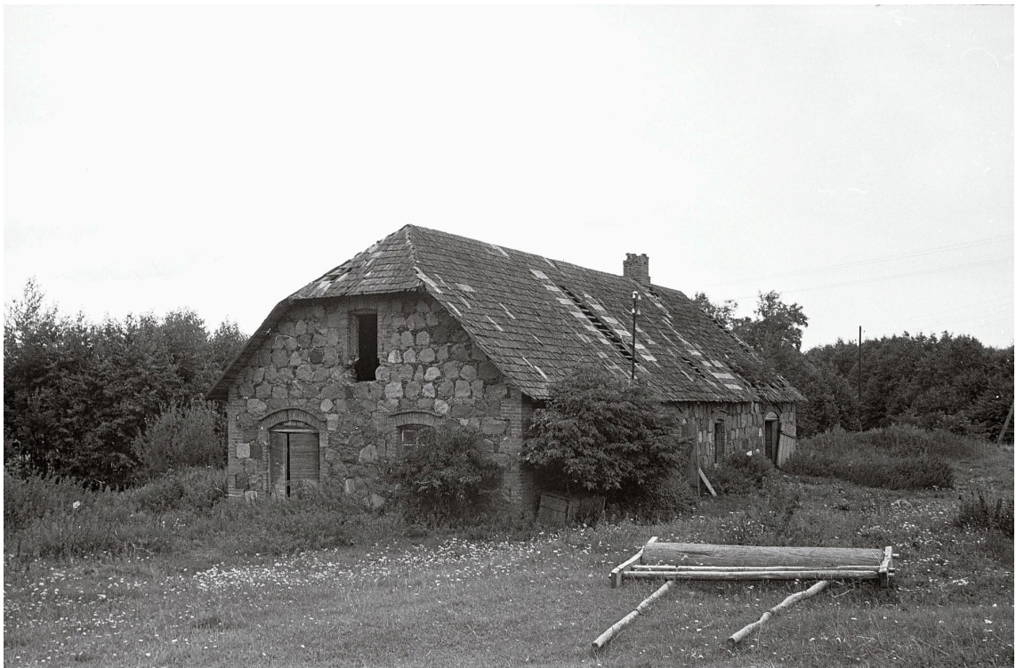
Joonis 124. Puutöökoda. Ehitusaeg vahemikus 1867-1890.
