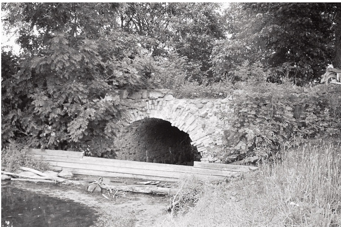
Joonis 127. Laotud truubiga sild ja pais
