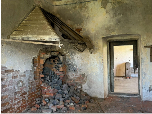
Joonis 70. Kõetava esiku nurgas on olnud pliitahi.
