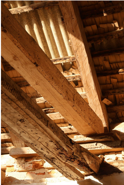
Joonis 50. Alumine kirvejälgedega tala on varasem., Ülemine uuem.
