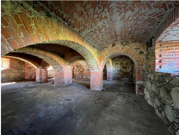
Joonis 32. Silindervõlvidega kelder.
