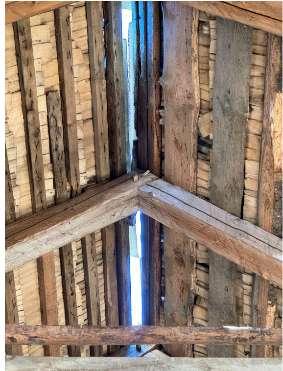
Joonis 51. Katusehari, roovitis, sarikate ühendus ja eterniitkatte alla jäätud pilpad.
