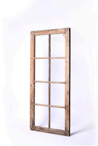
Joonis 53. Sanitaarruumi aken.
