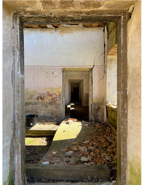
Joonis 27. Anfilaad ja välja vajuv sein.
