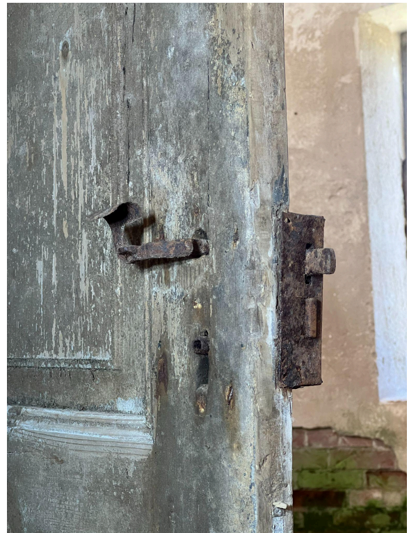
Joonis 61. Karplukk trepialuse panipaiga uktsel,
