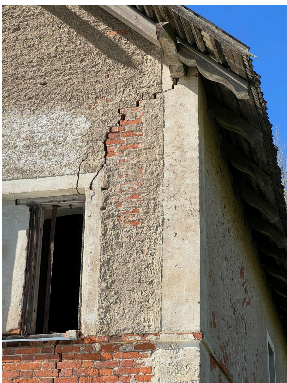
Joonis 44. Korruseid läbiv möra.
