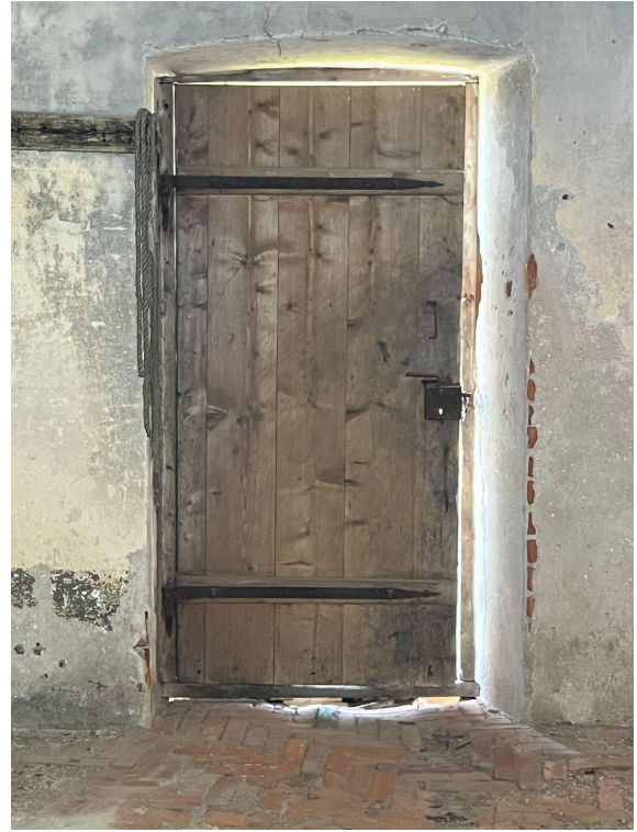
Joonis 59. Kõetava esiku plankuks.
