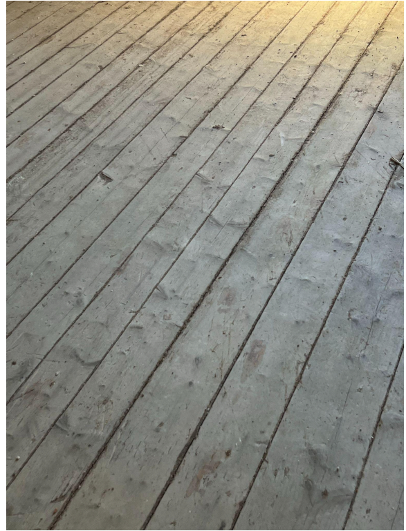
Joonis 40. Uuemad kitsad põrandalauad köögis.
