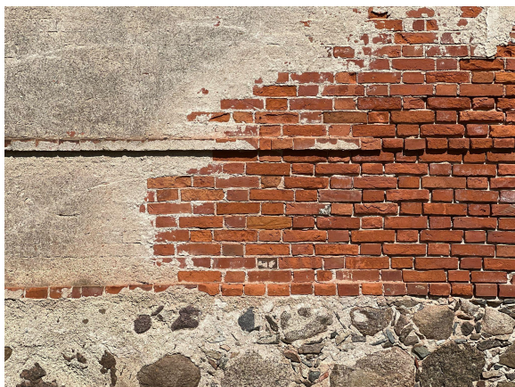
Joonis 42. Maakivivundament, tellismüüritis ja lubikrohvate.
