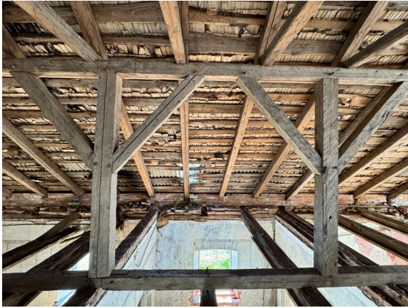
Joonis 48. Toolvark pärliini ja pärliinipostidega.
