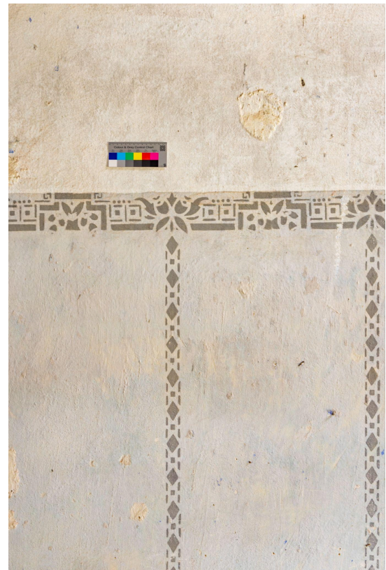
Joonis 79. Tuba nr. 9 trafarettmaalning.
