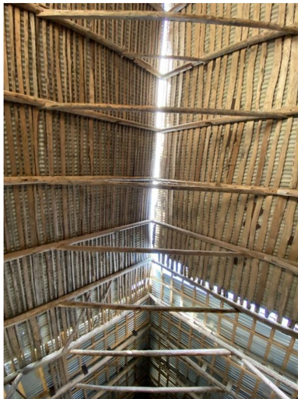
Pilt 31 Hoone kagupoolse osa algsed katusekonstruktsioonid
