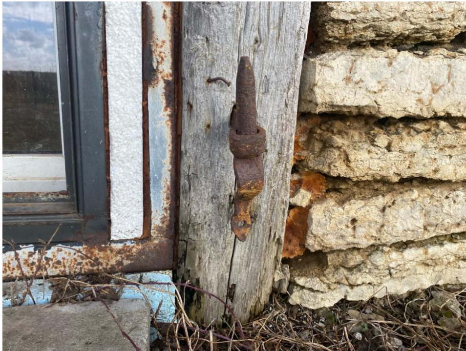
Pilt 22 Edelapoolse vanima ukseava tenderpost ja alumine hingekonks
