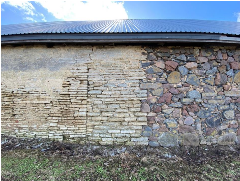
Pilt 13 Kirdeküljel asuv hoone algse edelapoolse nurga ja juurdeehitatus liitekoht otsevaates
