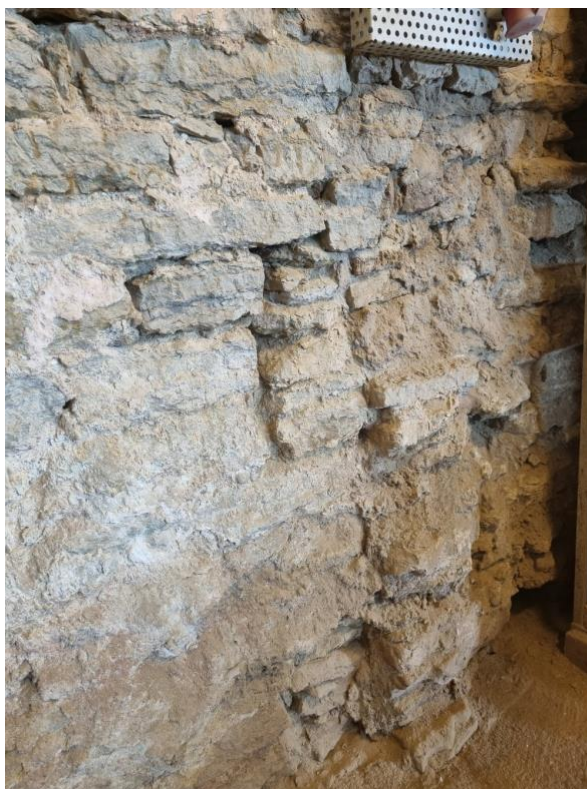
Pilt 42 Hoone vanima osa lammutatud sein nurk
