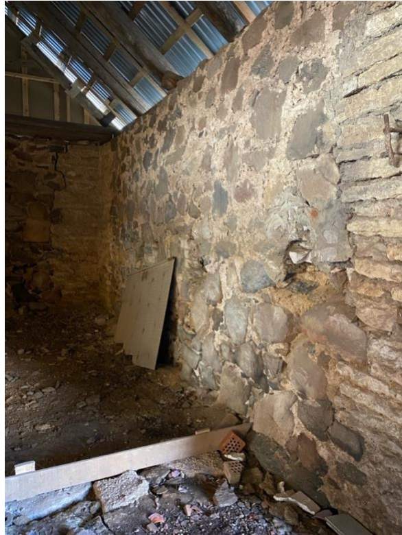
Pilt 35 Hoone loodepoolse osa sisemine pool, kirdes asuva vanima ukseava kõrval asetsev paekivi ääristus
