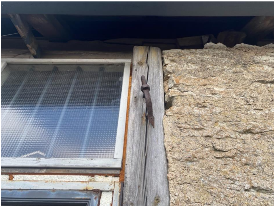
Pilt 21 Edelapoolse vanima ukseava tenderpost ja ülemine hingekonks
