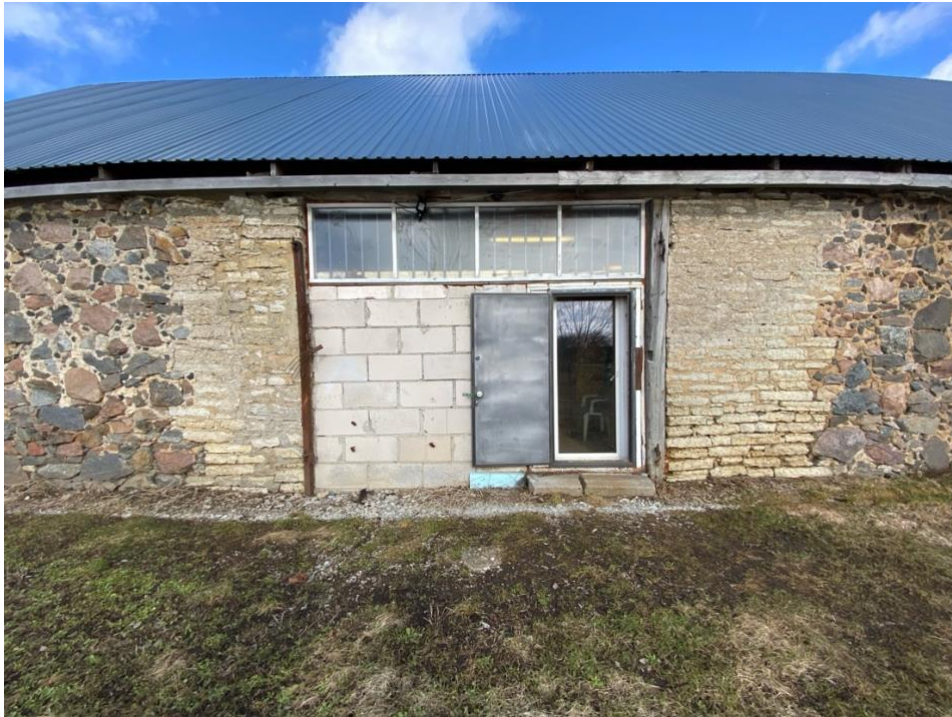
Pilt 11 Edelapoolne paekivi ääristusega ukseava
