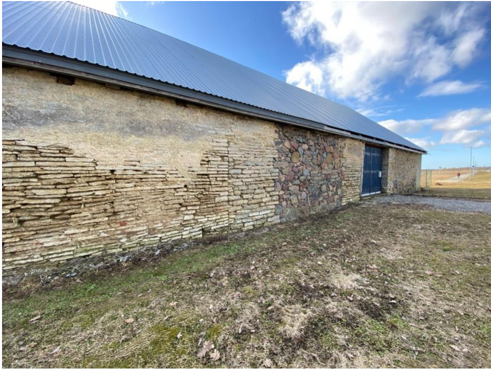
Pilt 14 Kirdeküljel asuv hoone algse edelapoolse nurga ja juurdeehitatus liitekoht kagupoolt vaates
