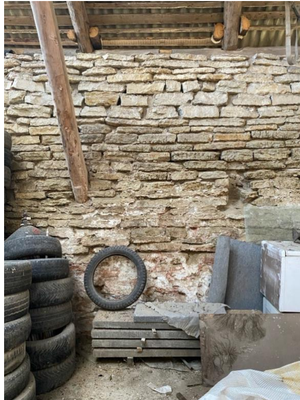
Pilt 33 Paekivist müür seestpoolt, säilinud algne katust toestav tala
