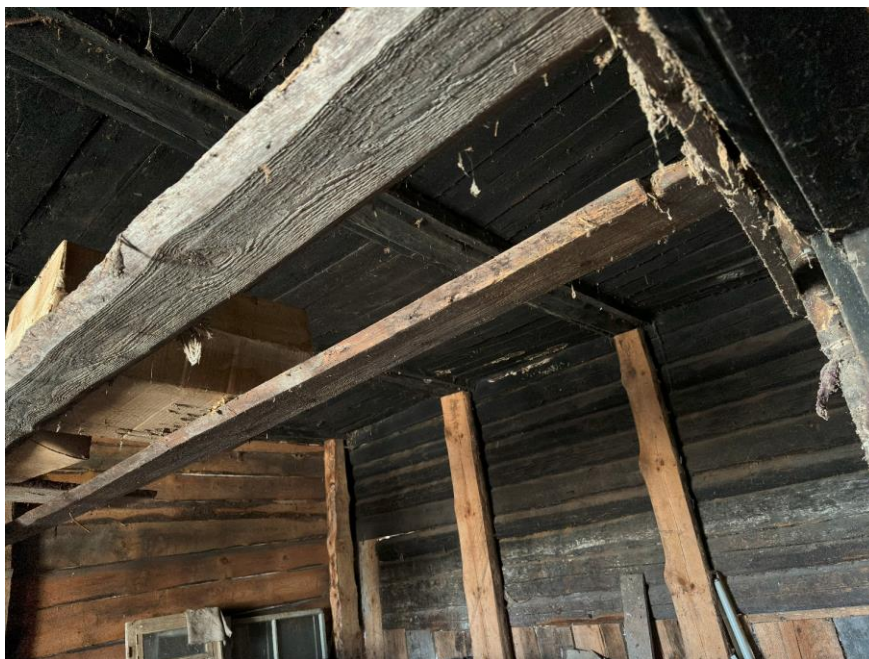
26 Rehetoa põhjapoolne sein toetatud püstpalkidega, alumised palgid eemaldatud. (Autori foto)
