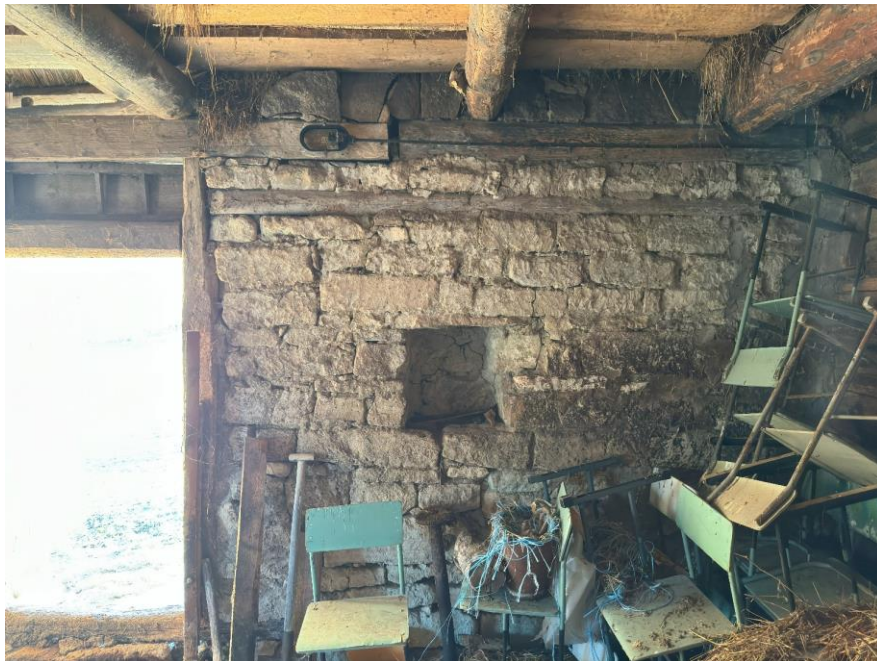
15 Esifassaadi paekivisein ja seinas olev varasem aknaava. (Autori foto)
