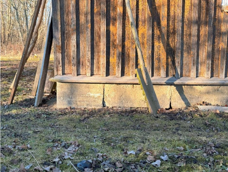
13 Sokliosas tahatud dolokiviplokkid. (Autori foto)
