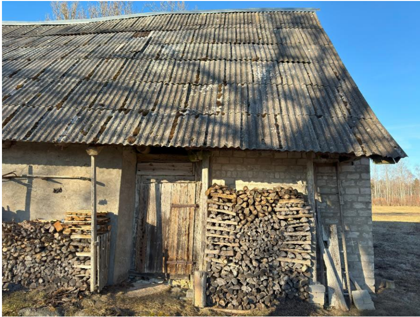
14 Esifassaadis krohvitud paekivisein, laudauks ja silikaatmüüritis. (Autori foto)
