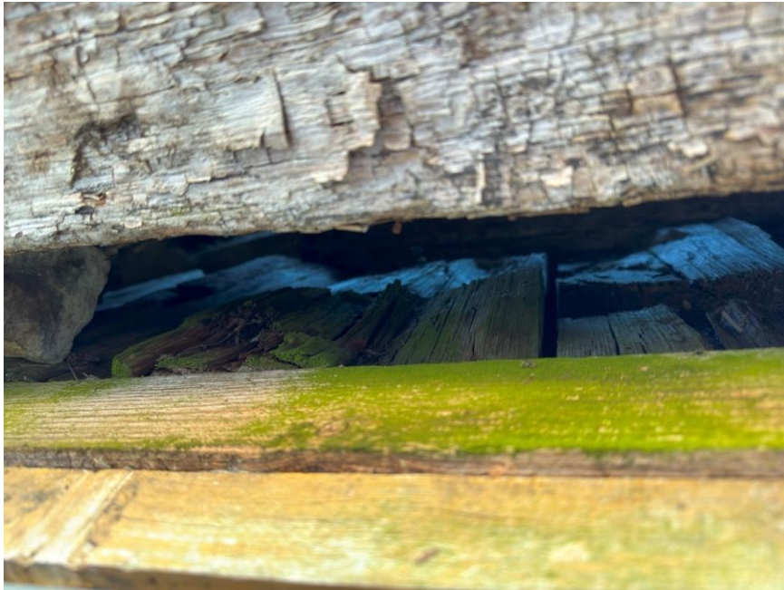
23 Vaade otsaakna kohalt üles silikaatvoodri vahele, paistab püstpalksein. (Autori foto)
