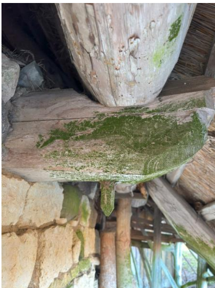
38 Räästatala väljavajumine. (Autori foto) 39 Murdunud räästatala ja ühenduskoht. (Autori foto)
