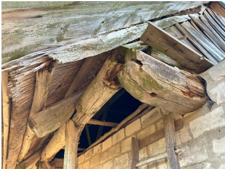
38 Räästatala väljavajumine. (Autori foto) 39 Murdunud räästatala ja ühenduskoht. (Autori foto)
