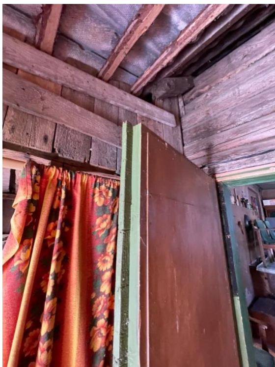
31 ja 32 Koja ja köögi vaheline uks on kaetud hiljem väljast laudvoodri ja seest vineerplaadiga (Fotod: Karmo Tõra 2024)
