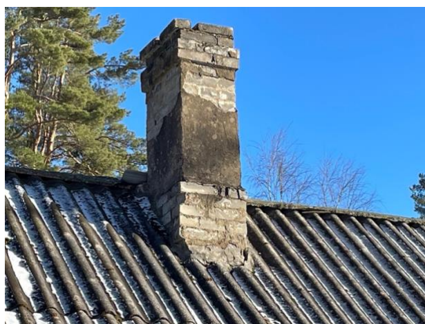
28. Korstnapits on laotud silikaattelistest ning krohvitud (Foto: Karmo Tõra 2024)
