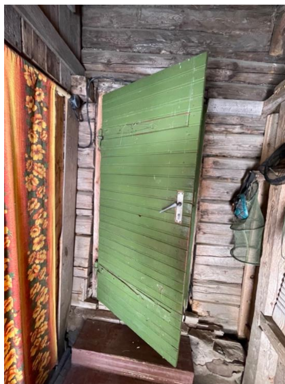
31 ja 32 Koja ja köögi vaheline uks on kaetud hiljem väljast laudvoodri ja seest vineerplaadiga (Fotod: Karmo Tõra 2024)
