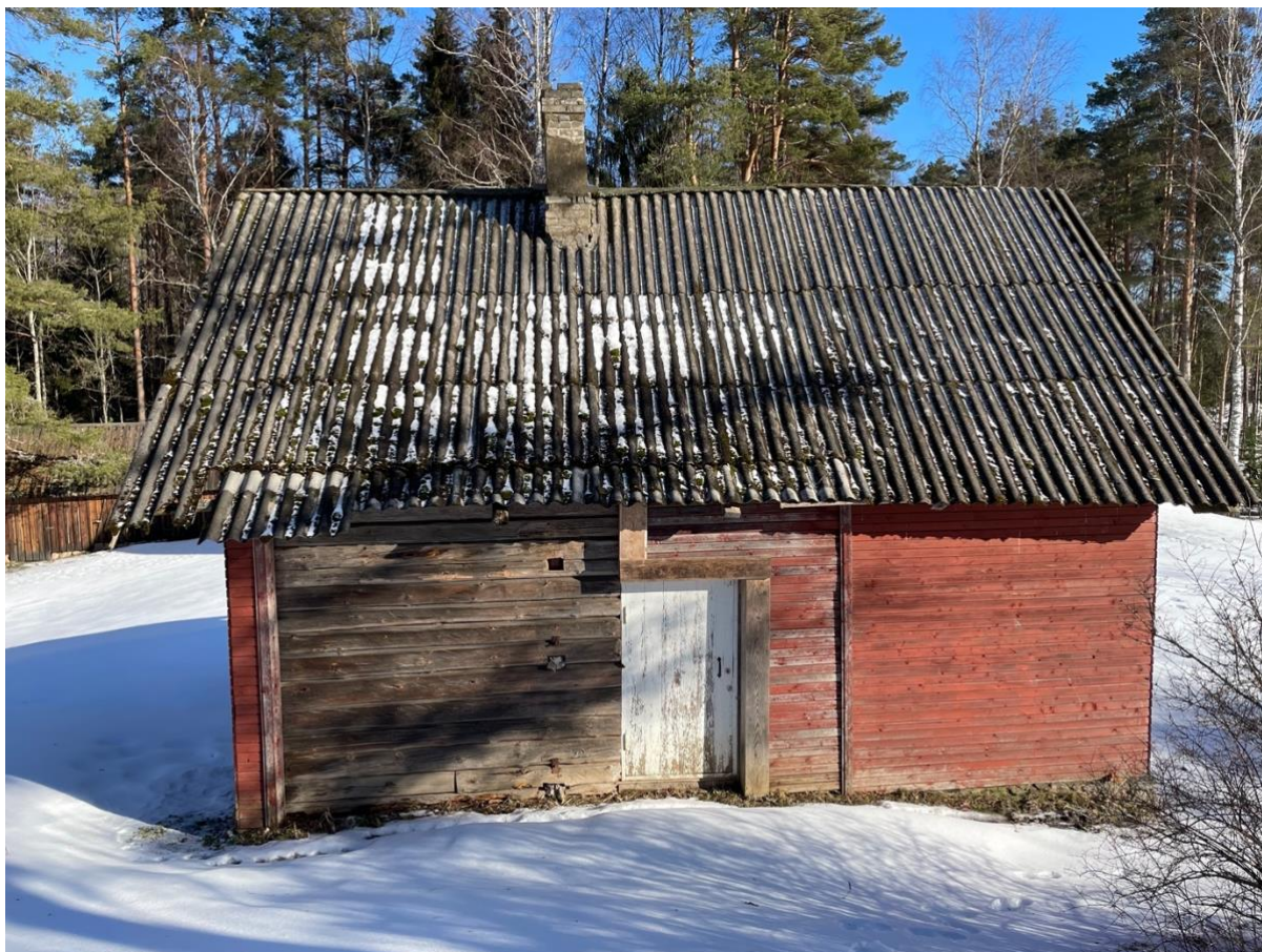
21. Nõlvapoolses küljes on maapind tõusnud alumise palgireani (Foto: Karmo Tõra 2024)
