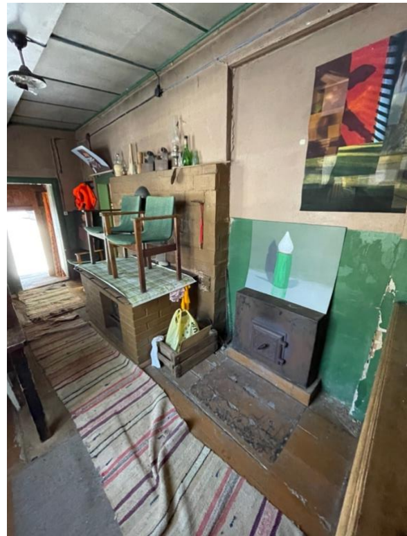
30. Ahi on köetav köögist. Tellistest pliit ja soemüür on hilisemalt ülevärvitud.
