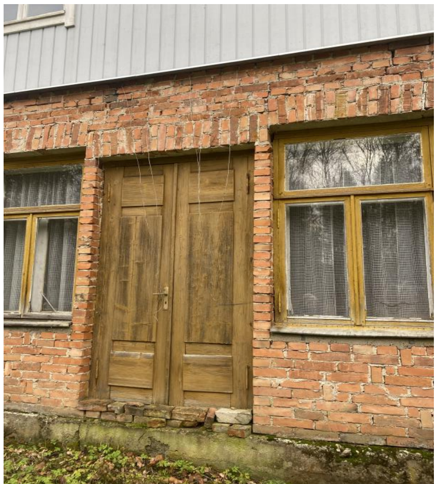
XVII Tellisseinad. Tähele tasub panna ukse ja akendeava erilist tehnilist lahendust seinas. Vabrikutöölise kirje toorele tellisele- "Elu on võitlus, tunnete mäng, Tormide heitlus ja murede mäng", Pildidil põletatud põrandaplaadid. Fotod 2023 K.Pärtelpoeg
