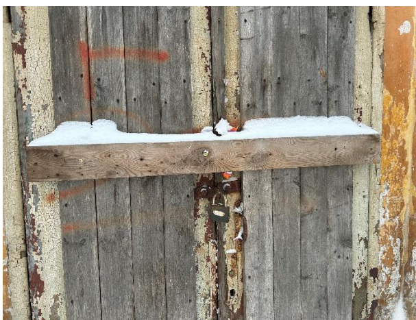
27. Ukse välislaudis ja lukustuseks kasutatav puitpruss.
