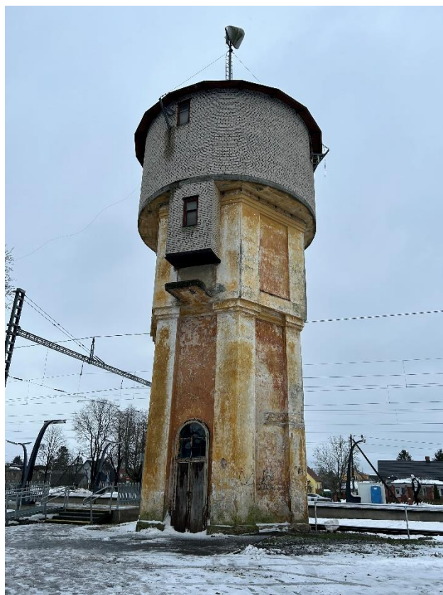
17. Veetorni kolmas korrus järgib vahelae kuju (2024). Autori foto
