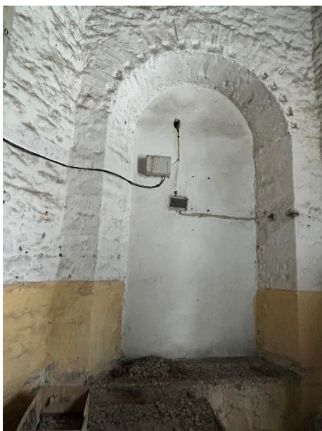
28. Kinnimüüritud esimese korruse akna nišš interjööris
