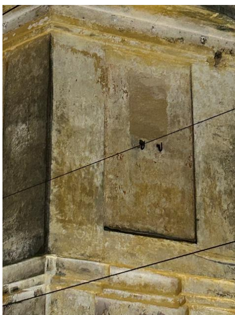
18. Petikaken ja korrustevahelised Astmikkarniisid (2024). Autori foto
