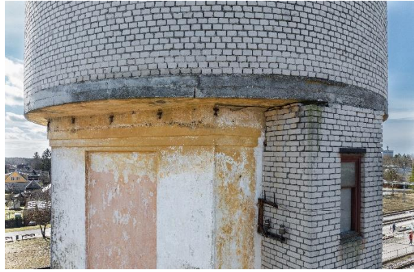
34. Paljandunud metallankrud teise ja kolmanda korruse vahel (2024). Foto Alari Tammsalu
