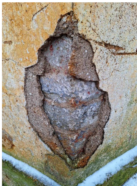
19. Fassaadi krohvikihid esimesel korrusel (2024). Autori foto
