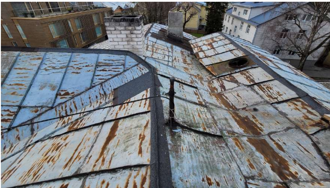
Foto 32. Vaade katusele Tiina tänava poole (Autori foto, 2023)
