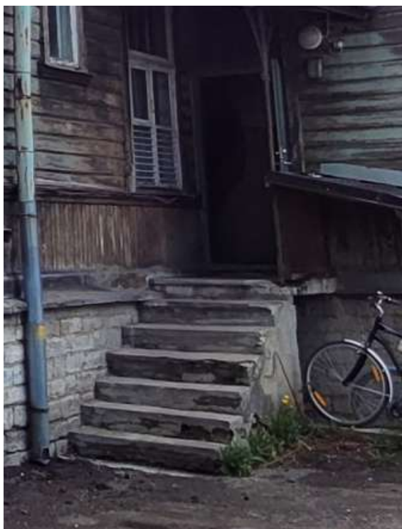
Foto 58. Sisehoovi betoonitrepp (Autori foto, 2023)
