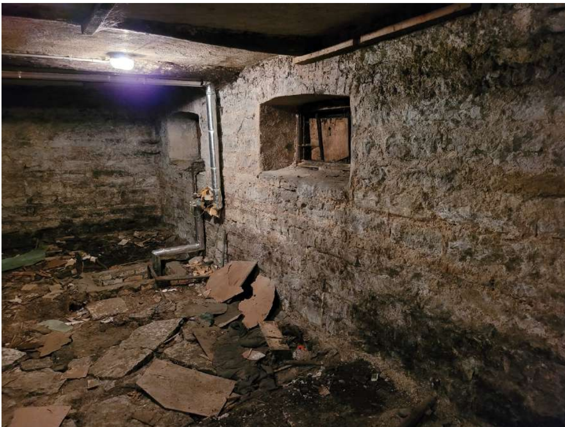
Foto 16. Keldrikorruse ruumi vaade (Autori foto, 2023)
