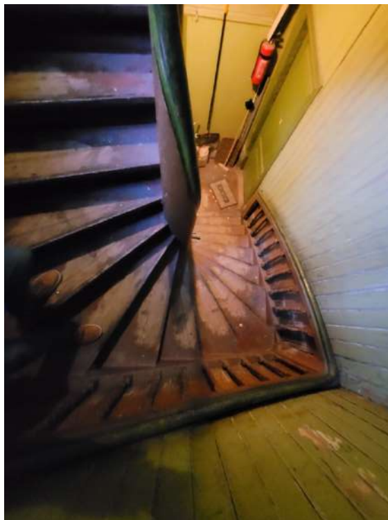
Foto 65. Hoovipoolne trepp (Autori foto, 2023)
