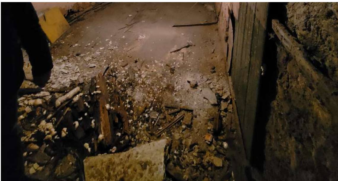
Foto 19. Lagunenud keldrikorruse betoonpõrand (Autori foto, 2023)
