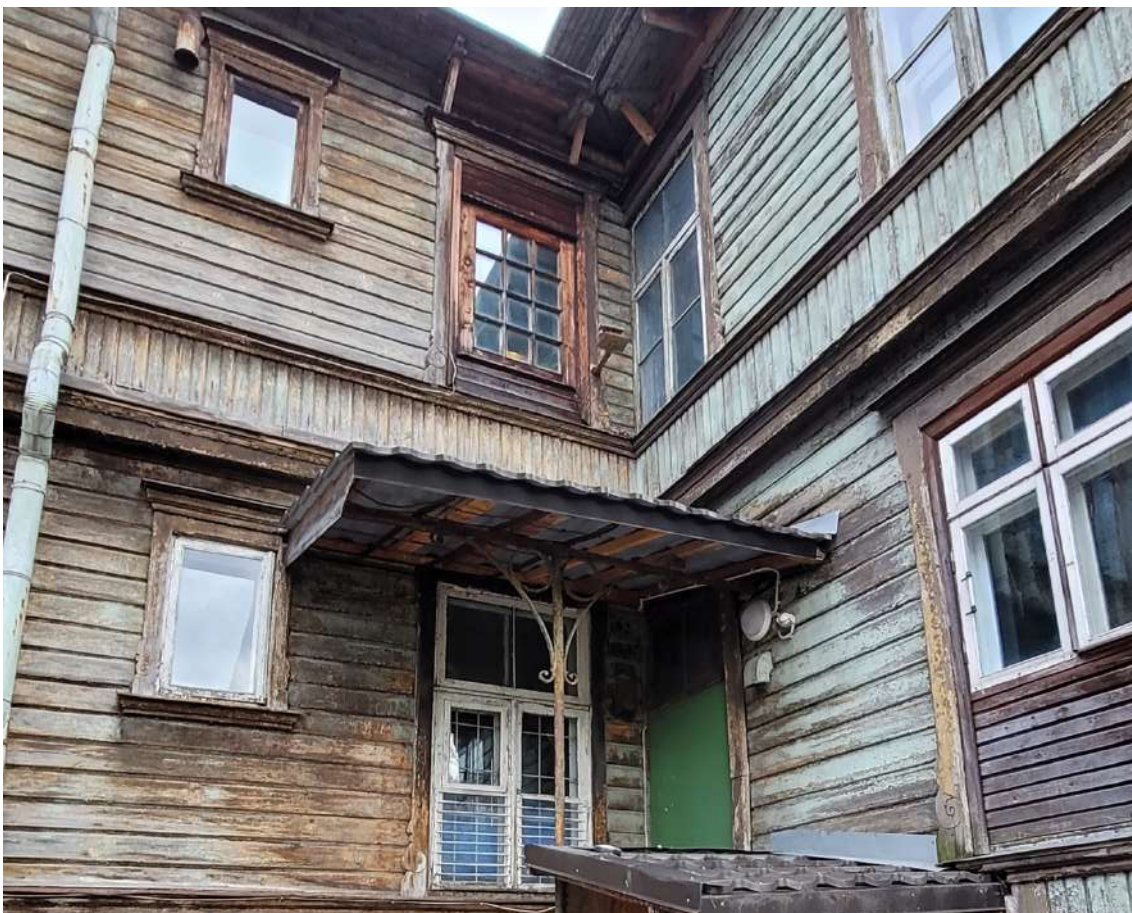
Foto 48. Säilinud WC ruumide aknad / ümberehitatud korruste aknad (Autori foto, 2023)
