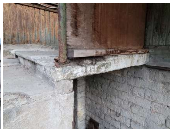
Foto 15. Lagunenud veranda betoonplaat (Autori foto, 2023)
