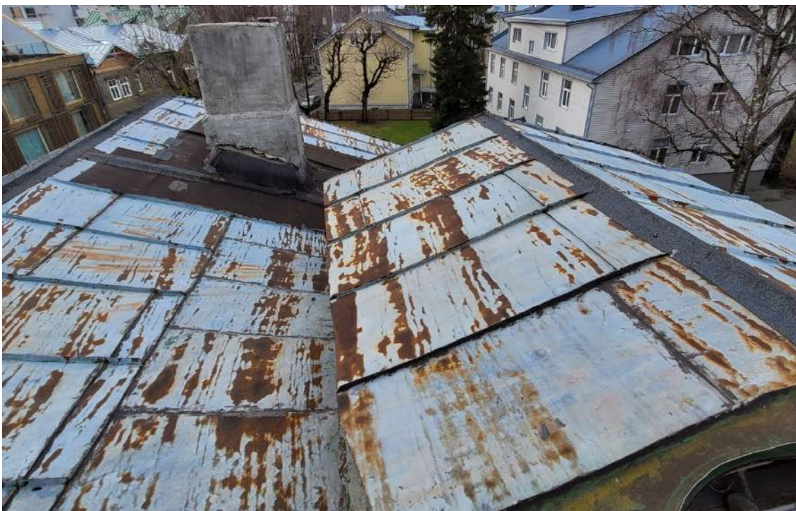
Foto 31. Vaade katusele Tiina tänava poole (Autori foto, 2023)
