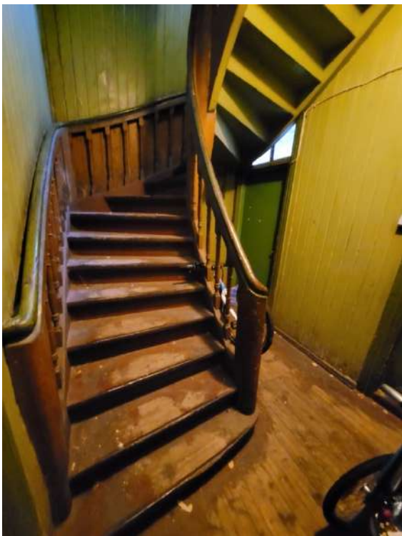
Foto 64. Hoovipoolne trepp (Autori foto, 2023)
