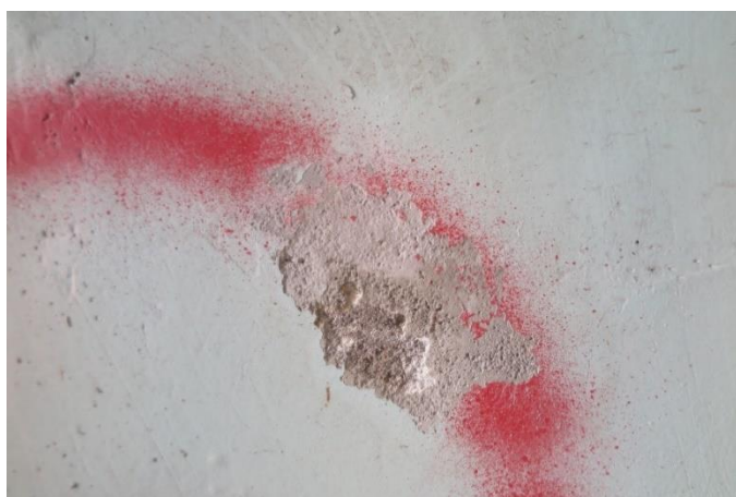
48. Jääpritsi nõrgima seadistuse korral oli võimalik eemaldada pealne tugevakelmeline värvikiht nii, et selle all olev pahtlikiht kaitses aluspinda.
