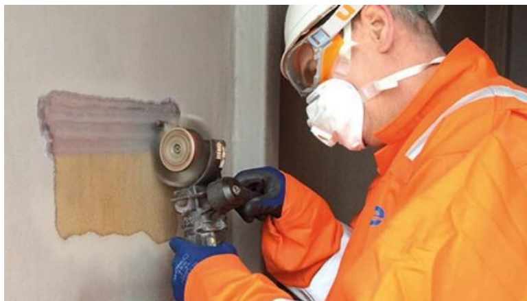
24. Metallharjastega harju on saadaval nii elektrilisena, suruõhul töötavana kui akutööriistana. 314
