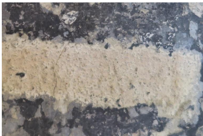
46. Jääpritsiga töödeldud ala, tugevaim seadistus. Liivaterad krohvis on endiselt lubjakirmega laetud.
