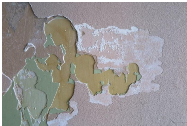
51. Fuajee seinu katsid mitmed tugeva koheosiooniga värvikihid, mis omavahel olid nakkunud ebahühtlaselt. Fotol on näha varem ühtlane värvipind pärast jääpritsiga töötlemist – alumine kollakasbeež värvikiht on säilitatav originaalkiht, mida püüti mitte kahjustada.
