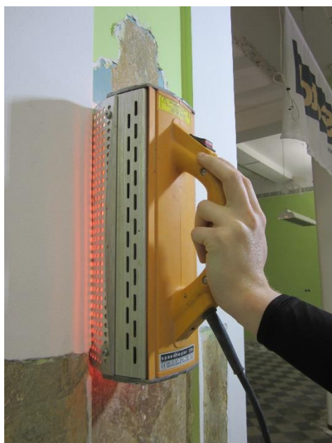
27. Soojuskiirgur Speedheater Standard, 1100W, mis moodustub kahest 550 W infrapunalambist, töötemperatuur on 100-175°C. Konkreetne mudel "Standard" on mõeldud suurte pindade värvist puhastamiseks (uksed, põrandad, seinad, fassaadid).
