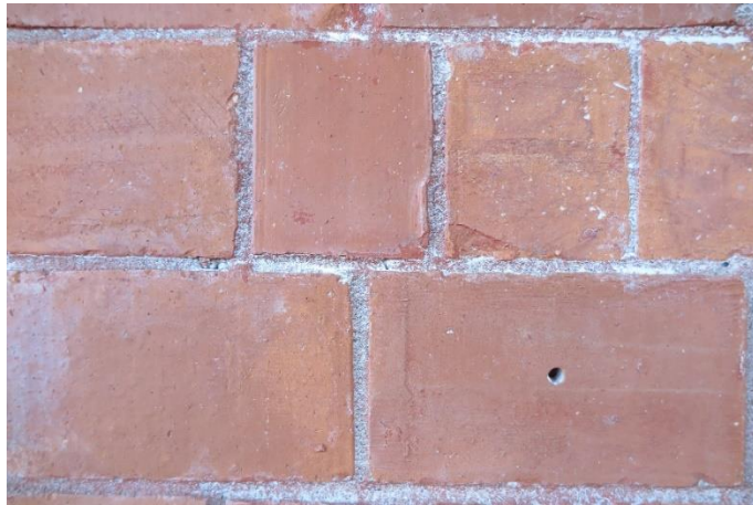
33. Tellismüüritise vuukide konarustesse on ladestunud puhastamiseks kasutatud sooda (valge), mis vajab omakorda puhastamist. Kividel on näha heledamad laigud, mis on pinnakahjustus – välitingimuses selline kivi katmata enam vastu ei pea.
