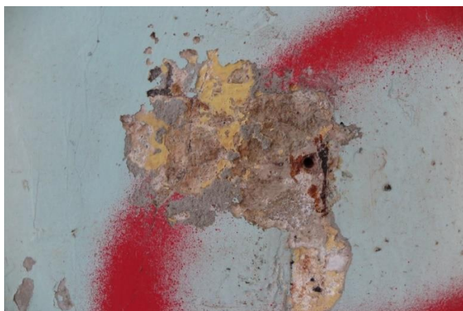
47. Jääpritsi tugevaima seadistuse korral tekkisid viimistlusse augud, kui krohvist hakkasid irduma suuremad liivaterad.
