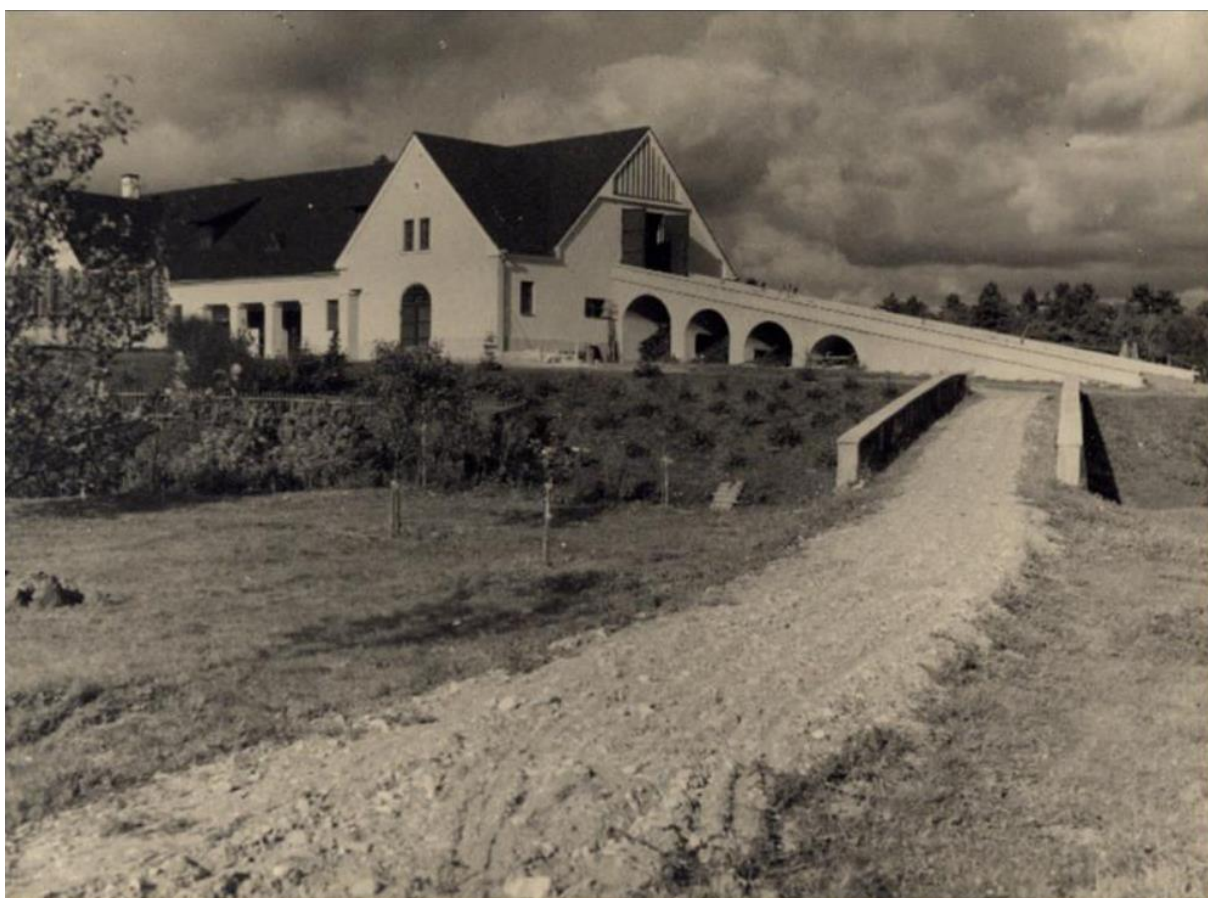
25. Vaade lõunast. Esiplaanil kaldtee kaaristu (RA, ERA.1278, n 1, s 314.28p.1).
