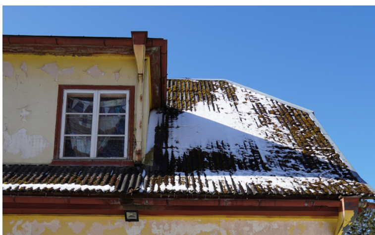
30. Hoone katus ja puidust räästakarniis aprillis 2023. aastal. Fotod: Piia Tammpuu.
