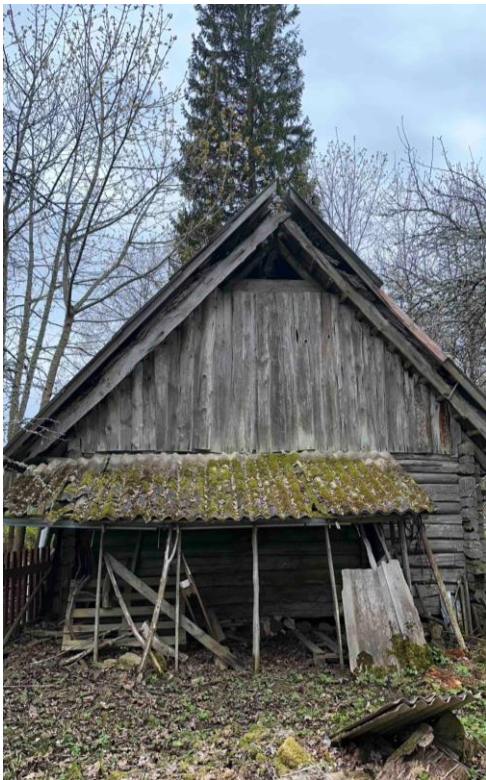
Joonis 34. Ebakorrapärased väljalõiked palkides ning pehkinud palkide otsad 34
