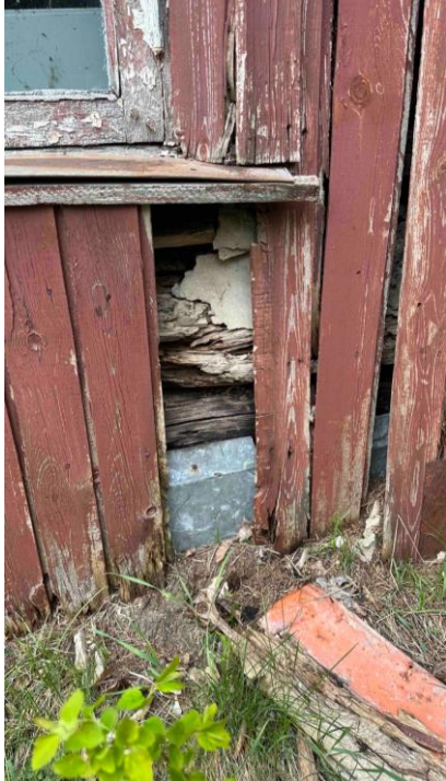
Joonis 22. Pehkinud rõhtpalk 22
