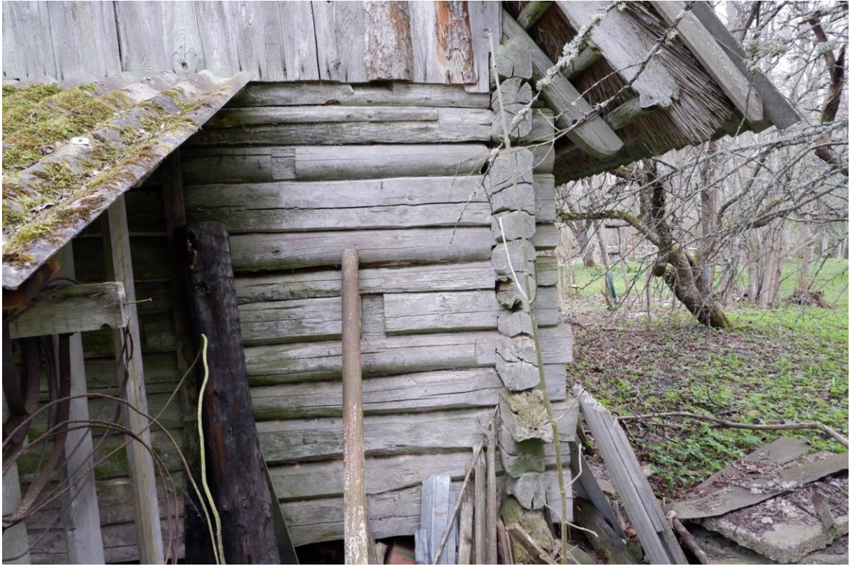
Joonis 34. Ebakorrapärased väljalõiked palkides ning pehkinud palkide otsad 34
