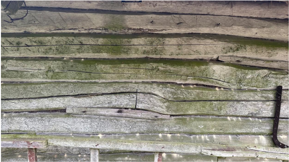
Joonis 35. Ebakorrapärase kujuga palgid 35
