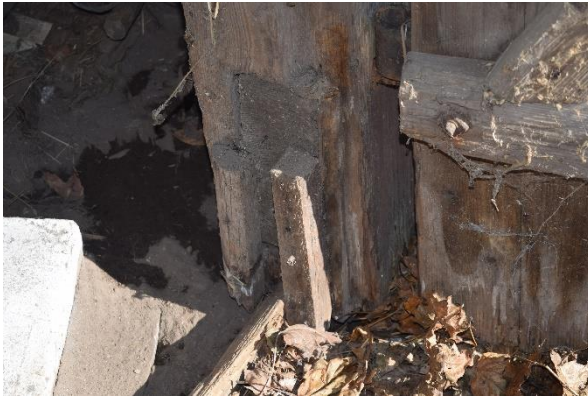
Illustratsioon XXXIII. Puidust siinid reealuse väravate alumises osas.
