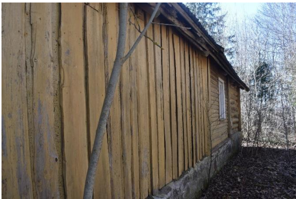
Illustratsioon XXIII. Rehielamu põhjapoolne sein. Esiplaanil saelaudadega kaetud tõrvapapp, keskel laudis, taga värvitud palksein.
