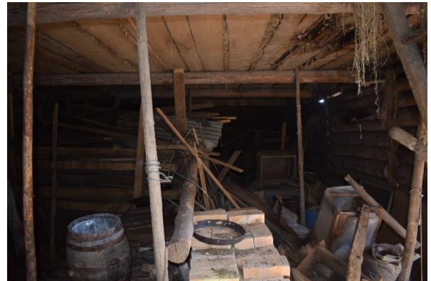
Illustratsioon XLVI. Rehealuse lagi on laudadest. Kohtades, kus katuses on läbijooksud, on lagi kahjustunud.
