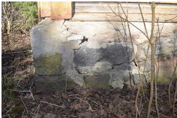
Illustratsioon XIX. Hoone lääneküljel on vundamendis näha pragusid.
