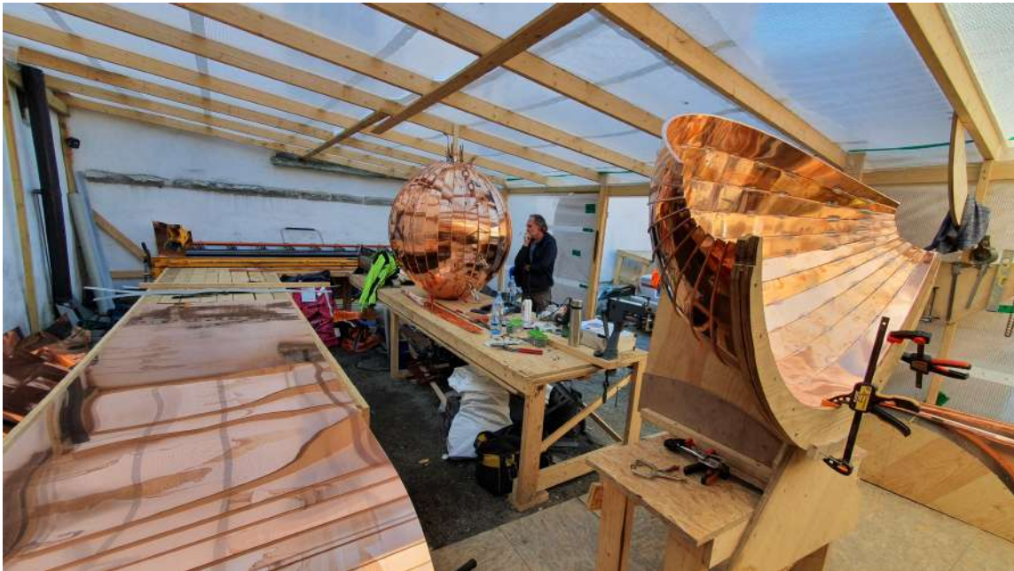
Foto 9 Ülemise galerii kuulide valmistamine kirku õuel (Bristol, 2022)
