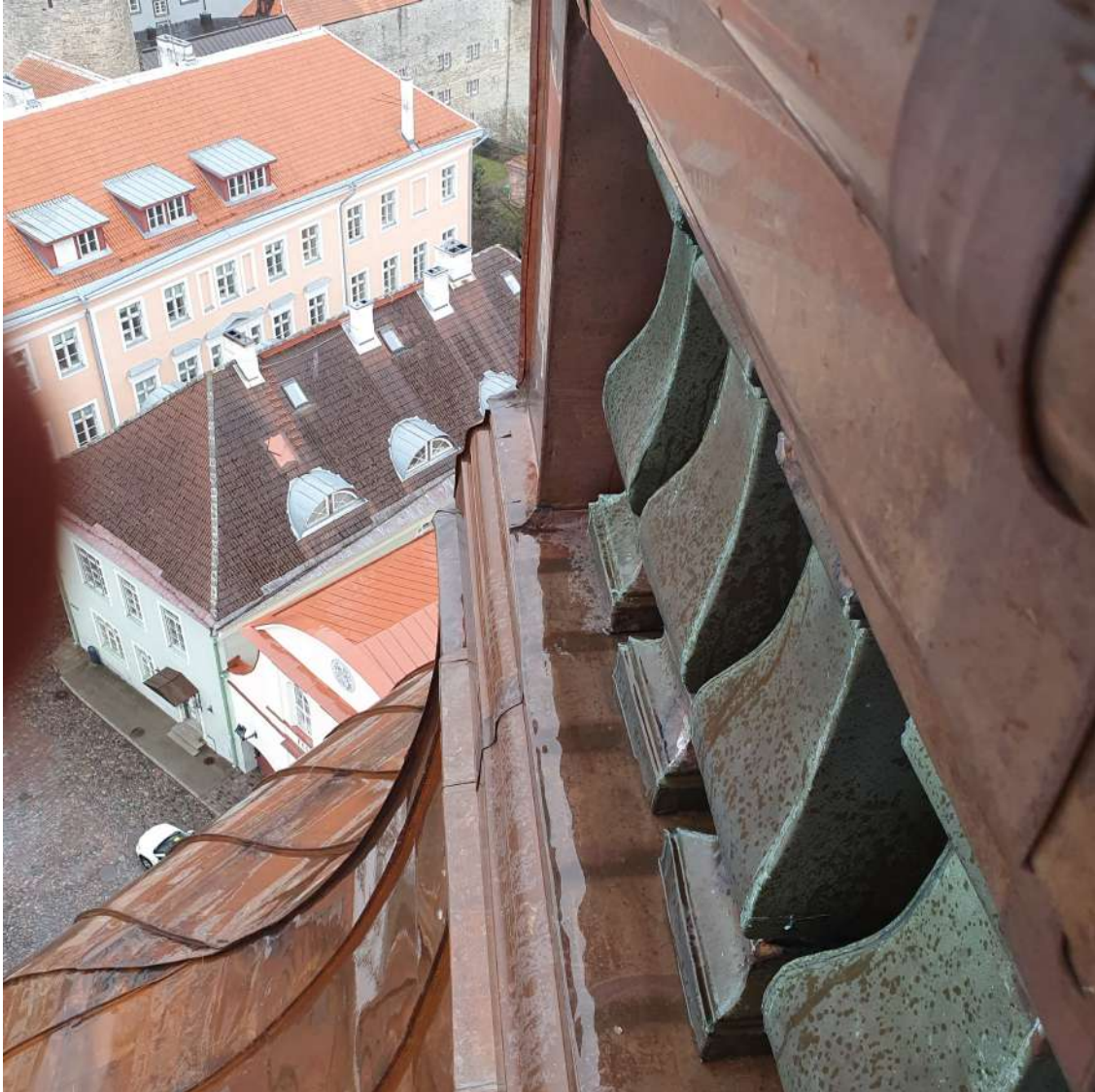
Foto 10 Alumise galerii vaskkatttega balustraad (Bristol, 2023)
