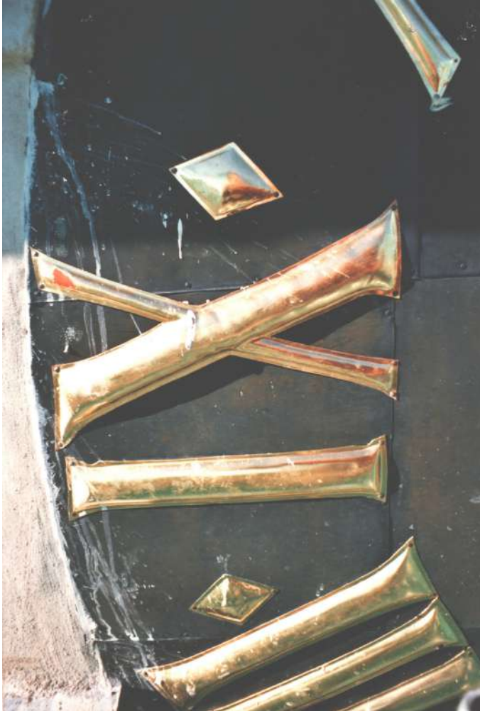
Foto 14 Kullatis sai vahetult pärast numbrilaudade valmimist krohvimistöde käigus tugevasti viga. Näide põhjaküljelt (Bristol, 2002)
