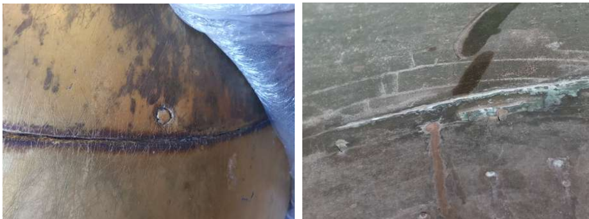
Foto 6 Vasakpoolsel pildil näha kuuli pinnal selle osi liitev neet (Bristol, 2022)
