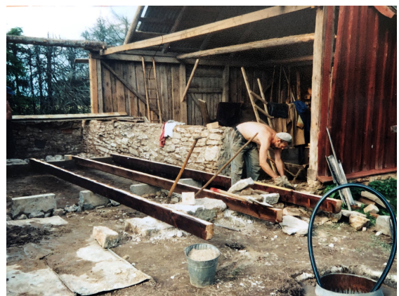
Ill. 14. Talliosa on lammutatud, paigaldatakse põrandatalasid 1994. Foto erakogu.
