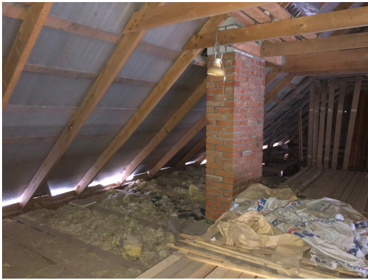
Ill. 27. Hoone uue osa katusekonstruktsioon. Foto V. Allorg 2023.
