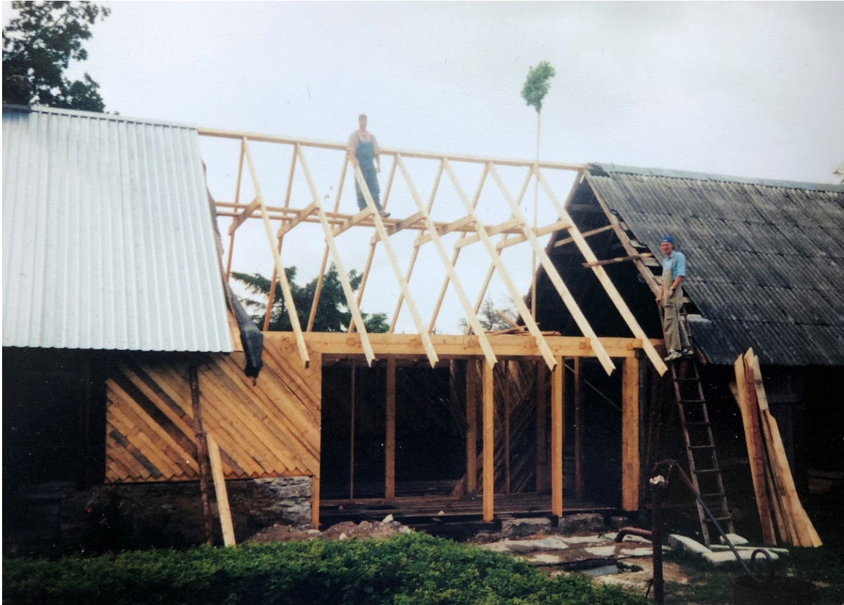
Ill 15. Sarikad on paigaldatud 1994. Foto erakogu.
