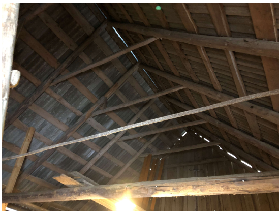
Ill. 29. Küüni katusekonstruktsioon. Foto V. Allorg 2023.
