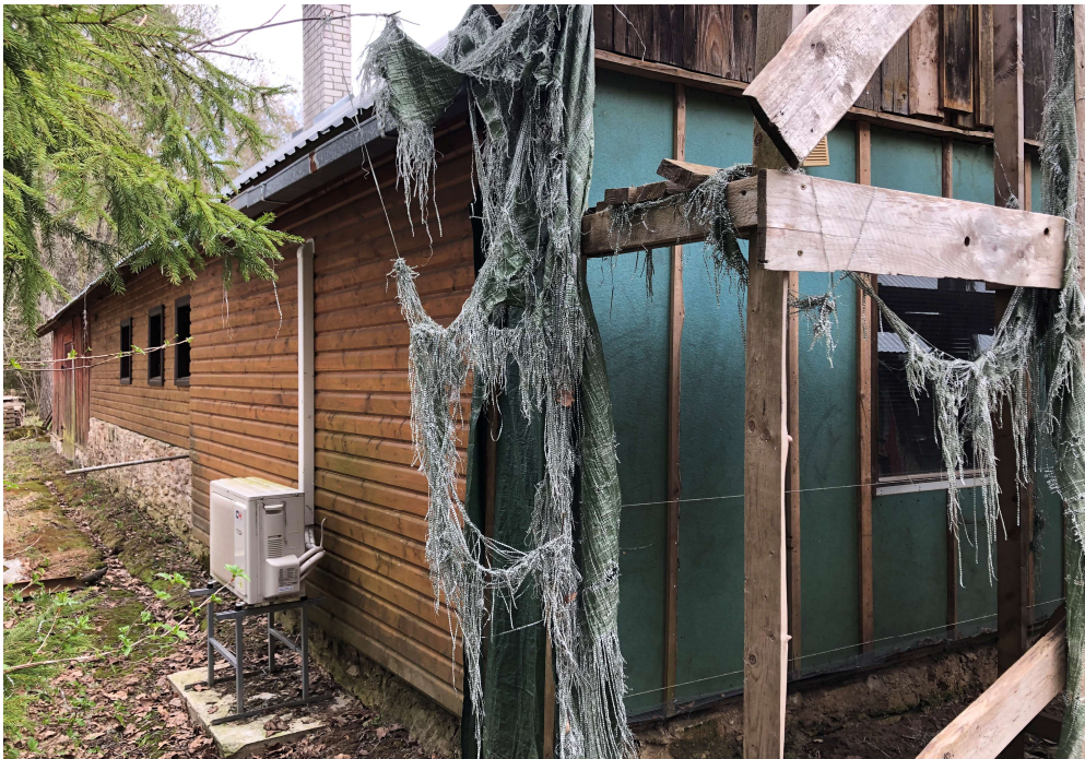
Ill. 22. Hoone tagafassaad ja läänepoolne külgein, vaade loodest. Foto V. Allorg 2023.
