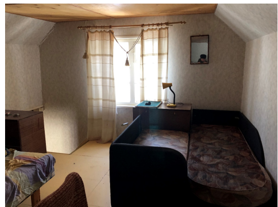
Ill. 48. Pööningukorruse seintele on kinnitatud kipsplaat, mis on kaetud tapeediga. Foto V. Allorg 2023.
