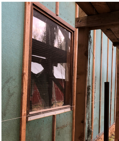
Ill. 35. Säilinud originaalakna siseraam. Foto V. Allorg 2023.
