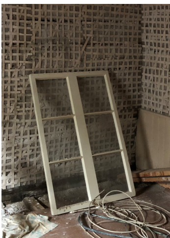
Ill. 35. Säilinud originaalakna siseraam. Foto V. Allorg 2023.
