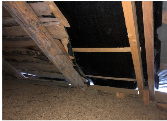
Ill. 28. Eluhoone ja uue osa katusekonstruktsiooni ühenduskoht. Foto V. Allorg 2023.
