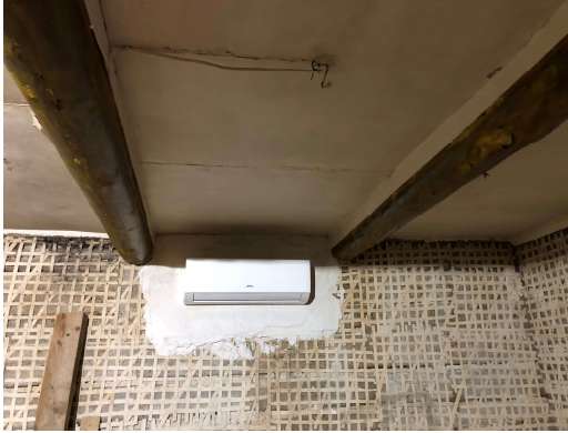
Ill. 45. Elutoa lagi on kaetud pingupapiga, seintel on laastumatt. Foto V. Allorg 2023.
