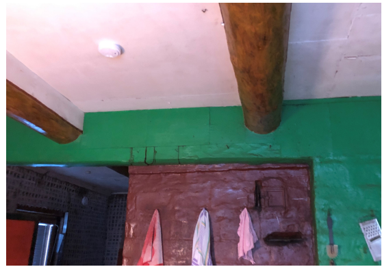
Ill. 45. Elutoa lagi on kaetud pingupapiga, seintel on laastumatt. Foto V. Allorg 2023.
