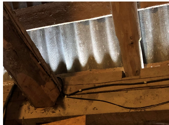
Ill. 28. Eluhoone ja uue osa katusekonstruktsiooni ühenduskoht. Foto V. Allorg 2023.
