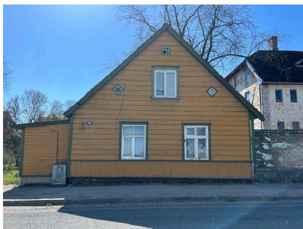
Foto 12. Algupärane lai rõhtlaudis ning hilisem kitsas vertikaalne laudis
