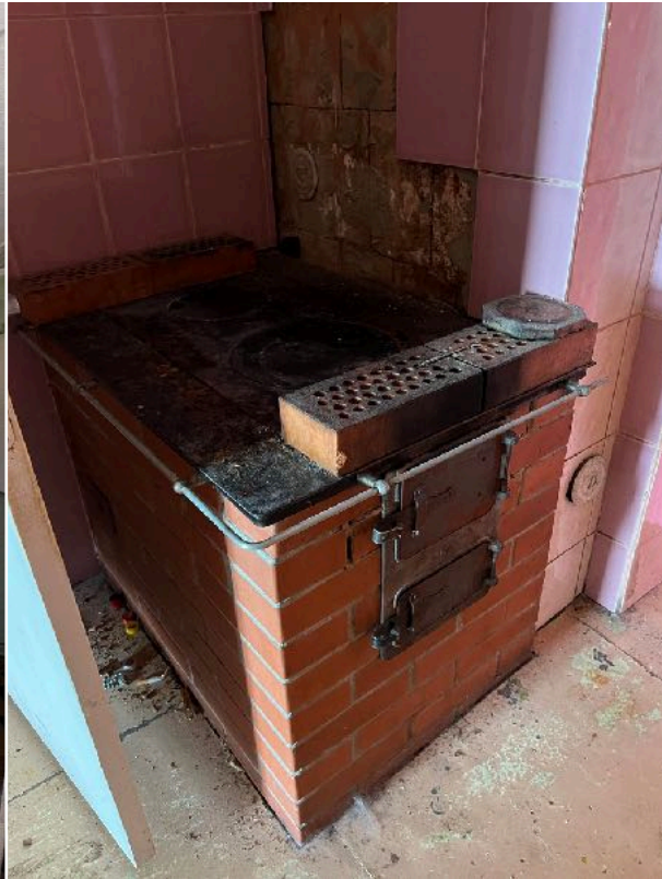
Foto 30. Amortiseerunud tellistest soemüüriaga pliit
