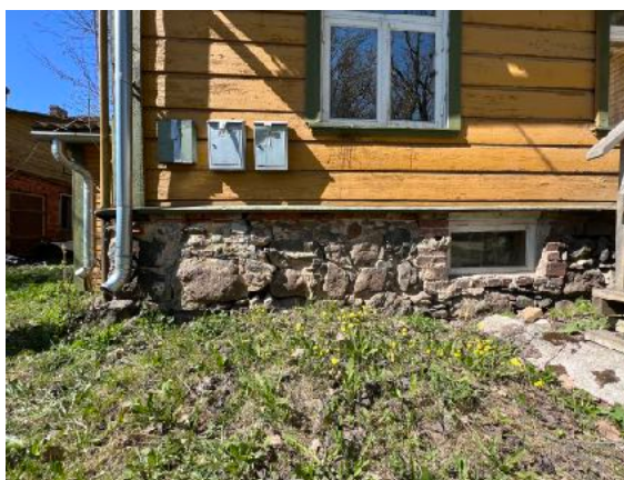
Foto 7. Algupärane puhasvuuk maakivivundament
