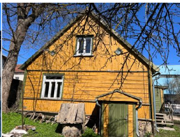
Foto 13. Algupärane lai rõhtlaudis ning hilisemad vertikaalsed laudised
