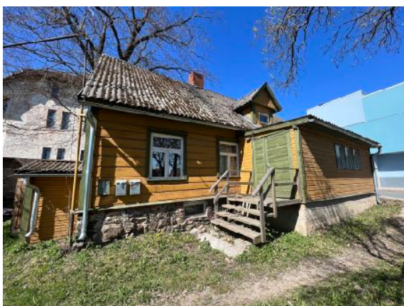
Foto 6. Juurdeehitatud eeskoja betoonsokkel
