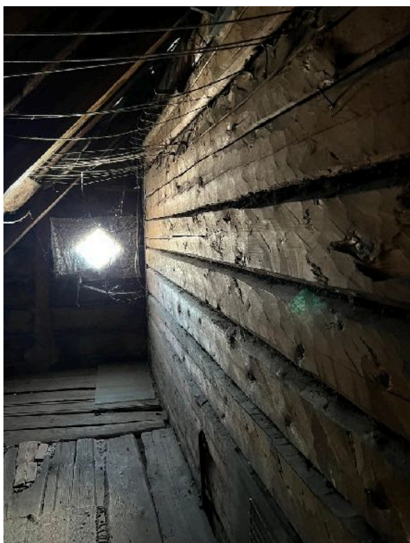
Foto 10. Kästitsi tahutud palgist seinakonstruktsioon, varade vahe tihendatud linavildiga
