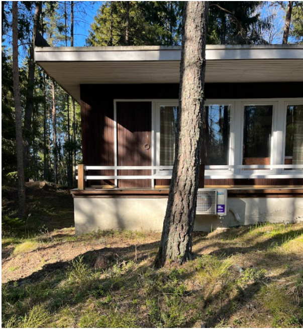
Il 36. Lõunafassaad koos õhksoojuspumbaga.
