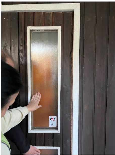
Il 33. Hoone välisüks. Aknaklaasid vahetatud 1990tel peale korduvaid sisseburldmisi ja algsete klaaside lõhkumisi.
