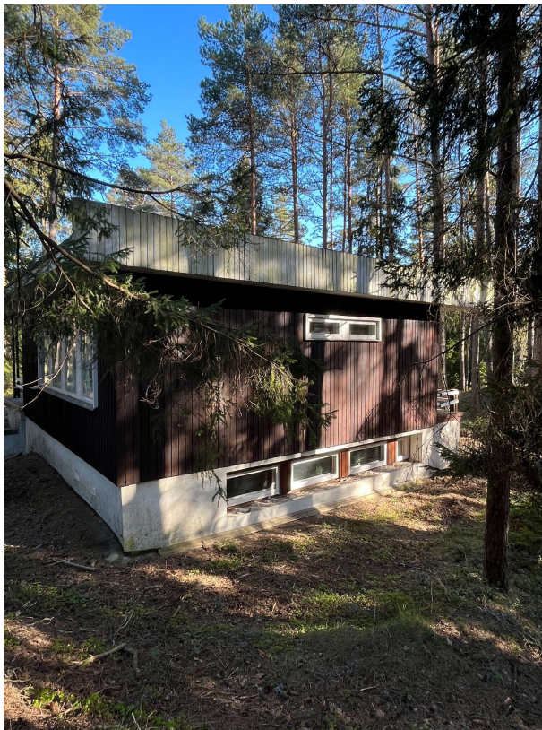
Hoone läänekül. Alumised aknad sauna
