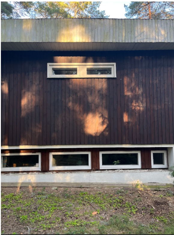
II 31. Idafassaadi aknad. Alumine aknarida eristub ülejäänutest akendest tumepruunide akna postide ja puuduva aknapleki/veelaua poolest.
