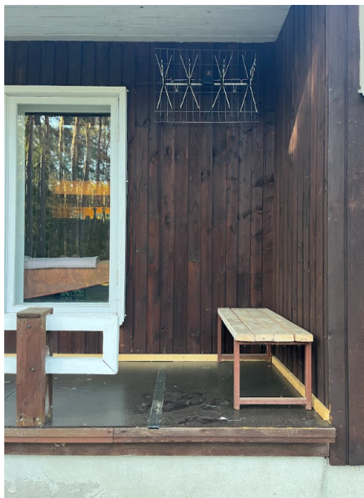
Il 26. Lõunaterassi uus veekindlast vineerist põrand. Näha katteliistud ja teip
