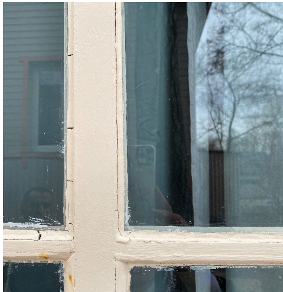
Joonis 31. Akna klaas osaliselt kititud, osaliselt puitliistuga kinnitatud. Foto: Katerina Laansoo, 2023
