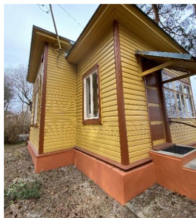
Joonis 17. Veelaud ei kata vundamenti. Soklilt krohv pudeneb maha. Foto: Katerina Laansoo, 2023
