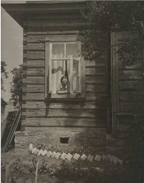
Joonis 19. Algupärane rõhk-palkvälissein. Foto: Varkki pere arhiivist, 1958
