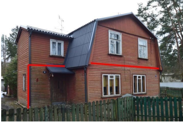
III 25. Punasest joonest üleval pool olev laiem (vana) fassaadilaudis. Puudub esimesel korrusel vertikaallaudis. Kõrval joonise väljavõte (1947 a)
