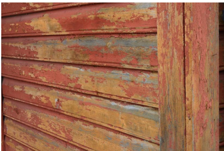
III 29. Algne laudis, mille ristlõike kuju saab fassaadi renoveerimisel kasutada.
