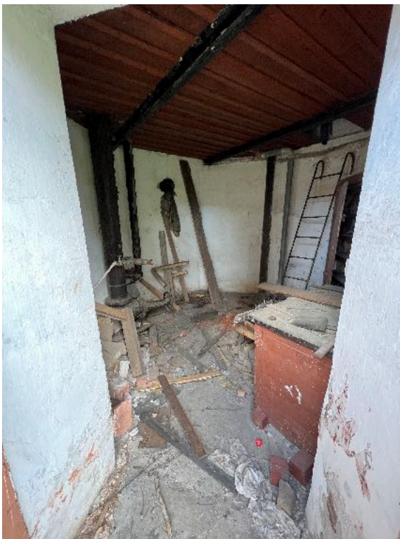
Foto nr. 23 esimese korruse põrand Foto nr. 24 teise korruse põrandat kandvad laetalad
