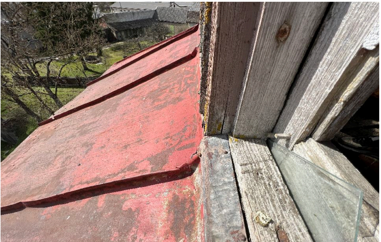
Foto nr. 15 katusepleki serv painutatud aknalengile
