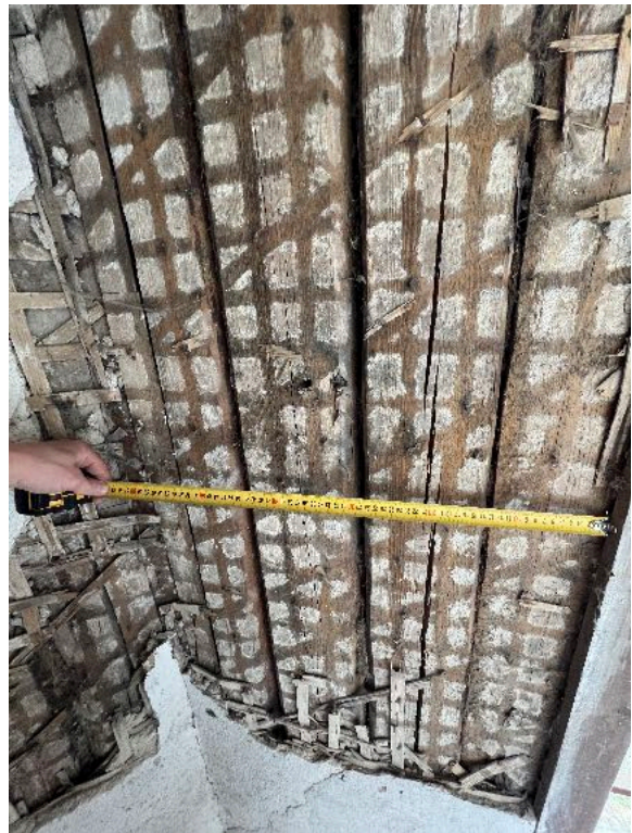
Foto nr. 12 paljandunud püstpalgist sein
