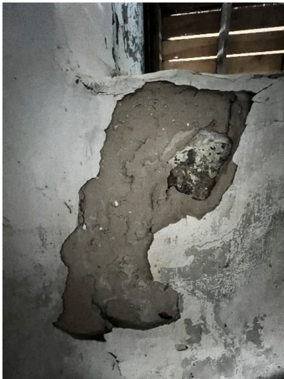
Foto nr. 27 teise korruse seinast langenud krohv
