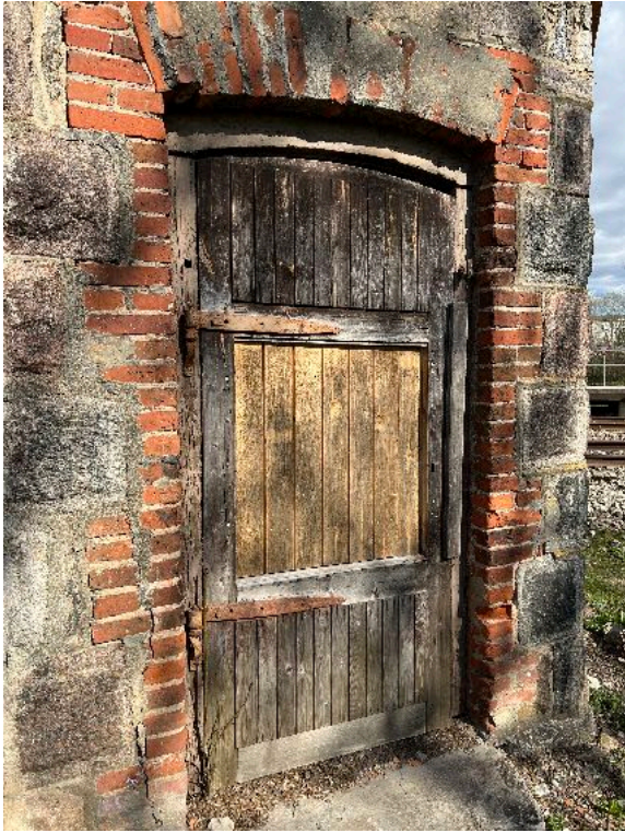
Foto nr. 16 esimese korruse välisuks
