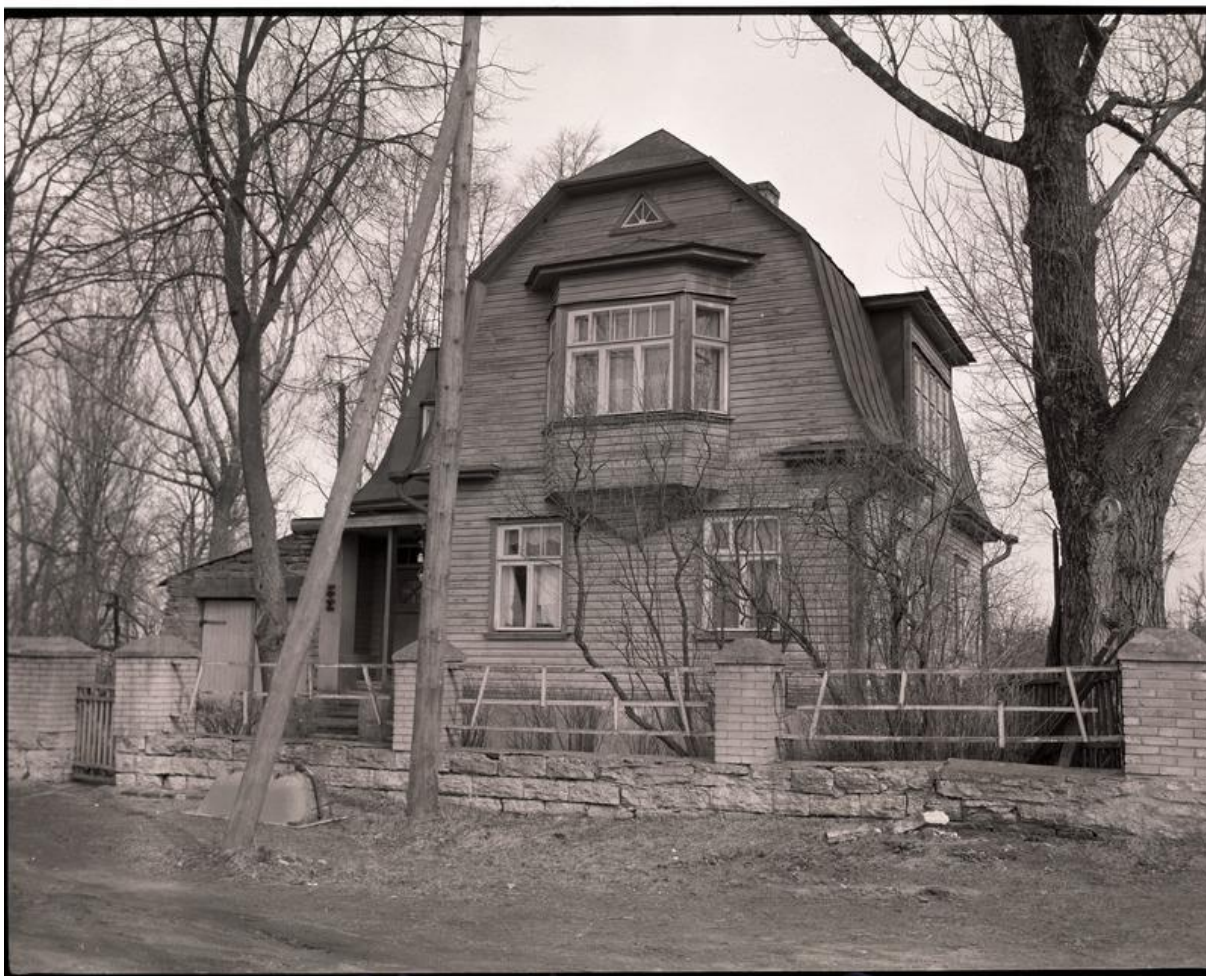
Tallinn. Võidujooksu tn 3a mansardkorrusega vana puitelamu, fotonegatiivi autor Viivi Ahonen, mai 1997.a., Tallinna Linnamuseum, number: TLM Fn 10004:103
