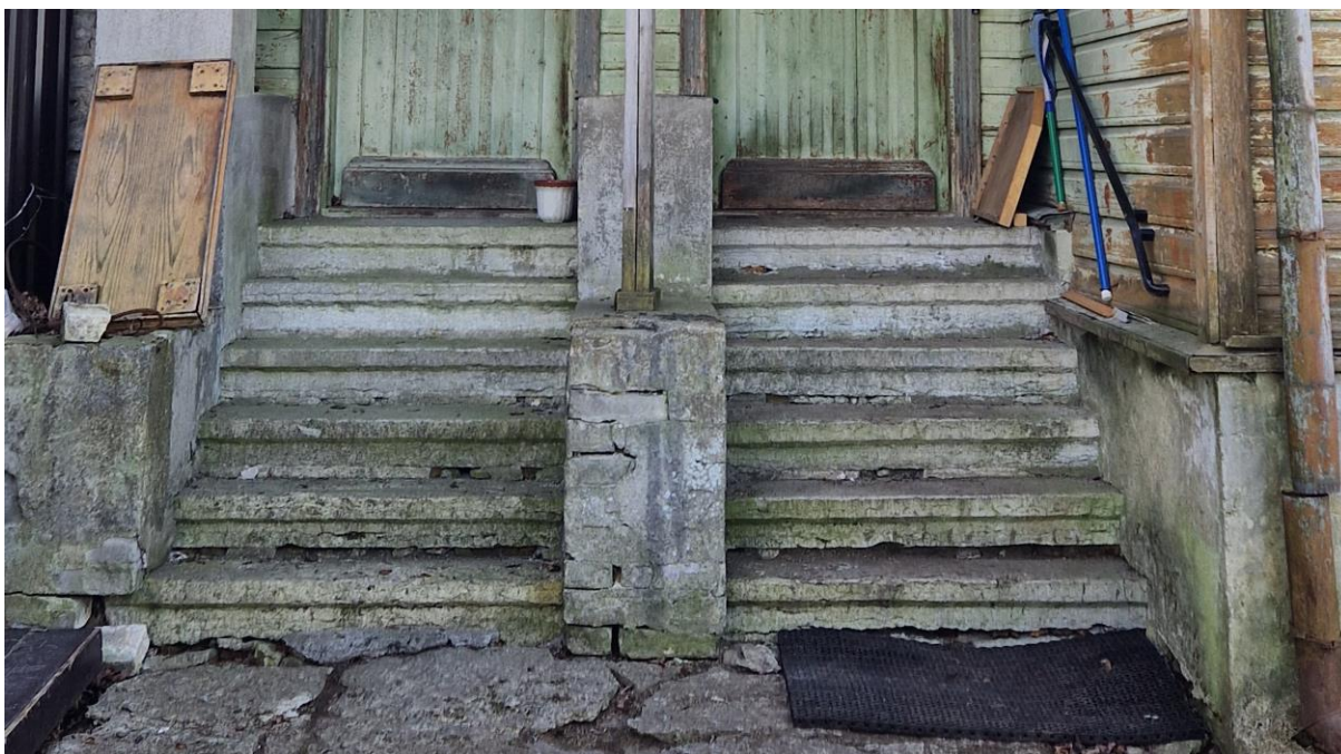
Illustratsioon 23. Peasissepääsu trepp, autori foto, 16.04.2023
