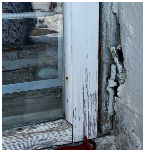
48. Säilinud aknapiit. Allikas: autori foto
