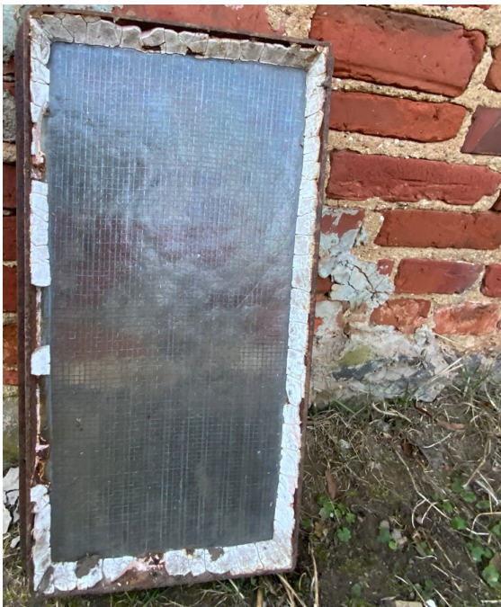
56. Armeeritud klaasaken metallraamis. Allikas: autori foto
