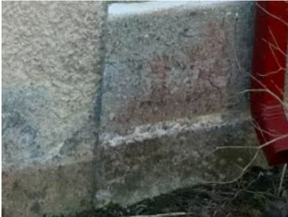
17. Elamu krohviga kaetud sokkel-sein. Allikas: autori foto
