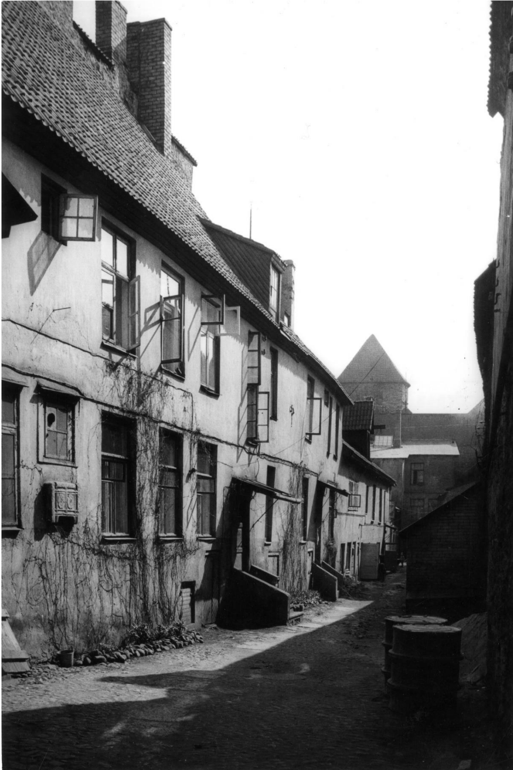
L9 Vene 10 hoovivaade Müürivahe tänava poole, 1971 Vasakult tahapoole on reas hooned B, C, D ja E. Hoovi lõpus paistab hoone F kõrge korstna ja valgmikuga katusel, Müürivahe 31 hoone tagumine fassaad ning Hellemani torn. Paremalt Vene 8 müür ja praeguseks lammutatud silikaattellistest kuurid.
