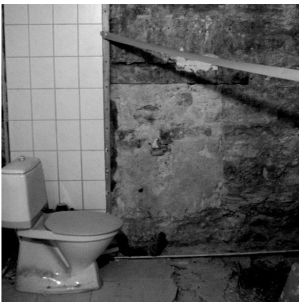
23 Kinni laotud aknaorv, puidust ja paekivist sillusega enne avamist 2006. aastal.
