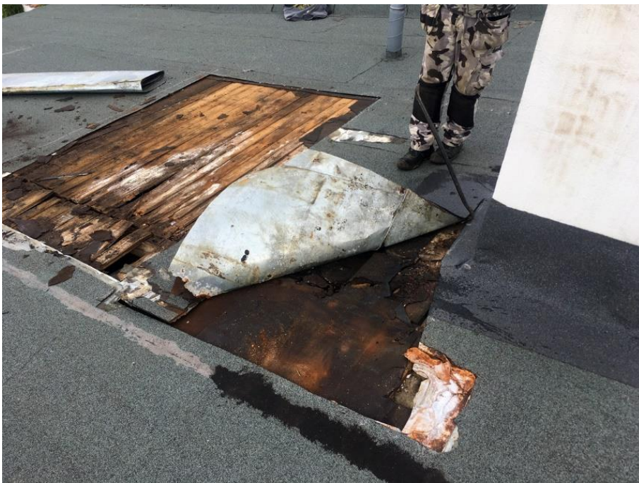
12 Katuse avariiremondi käigus selgusid olemasoleva katuse kihid. Sarikatele on paigaldatud 25 mm laudis, tõrvapapp, valtsitud tsingitud terasesplekk ning kõige peal rullkattematerjal.
