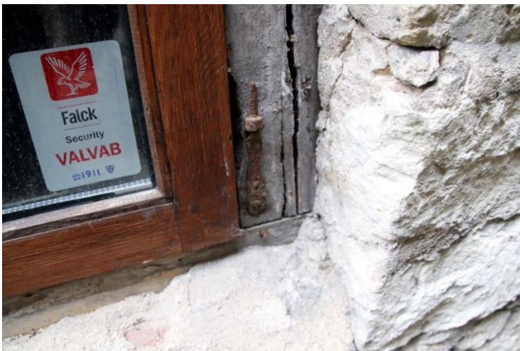
18 Säilinud aknahing hoone 1. korrusel. Vaade väljast.
