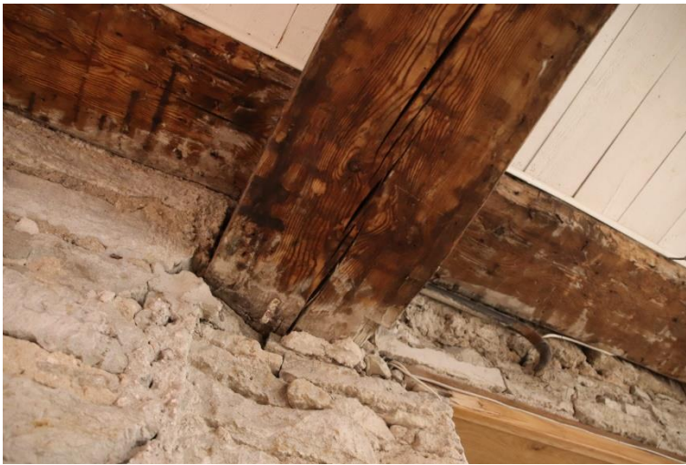
19 Ematala liitumine seinaga hoone 1. korrusel.
