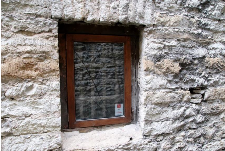
17 Aknalengid sepistatud trellidega, aknaorvad sillusetaladega hoone 1. korrusel. Vaade väljast.
