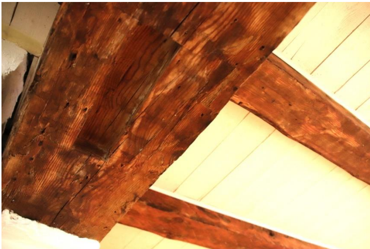
20 Posti tapi auk ematalas hoone 1. korrusel.
