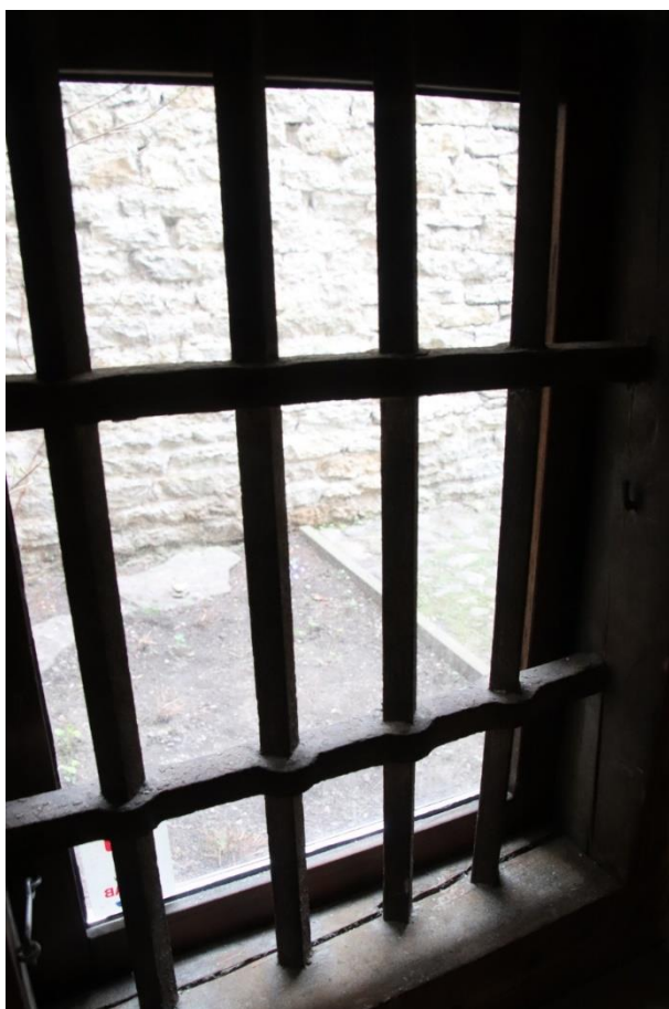
16 Aknalengid sepistatud trellidega, aknaorvad sillusetaladega hoone 1. korrusel. Vaade seest.
