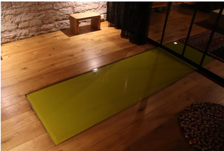
22 Klaasiga kaetud autotranšee 1. korruse põrandas.
