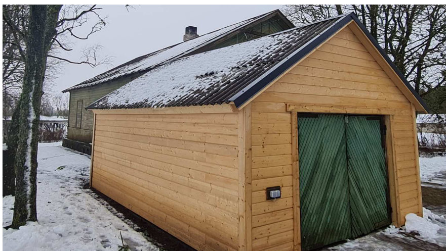
5. Paikvaatlus 2023 kevad, vaade juurdeehitusele põhja suunalt
