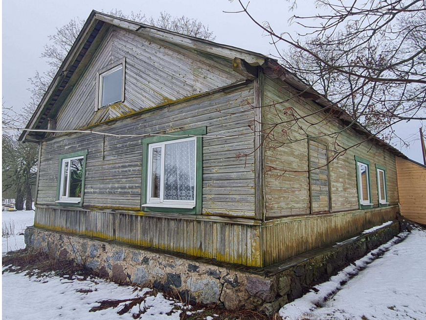
8. Paikvaatlus kagust 2023 - Paremäl on näha kinniehitatud algse akna raamistik
