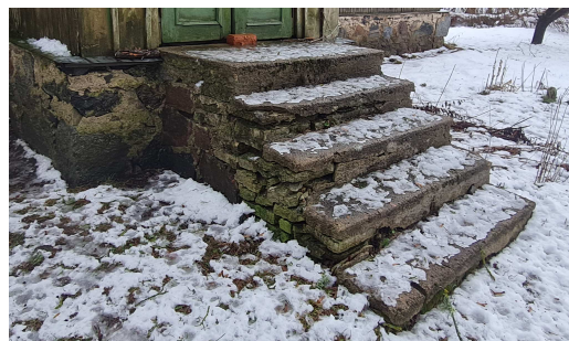
13. Paikvaatlus 2023 veranda trepp
