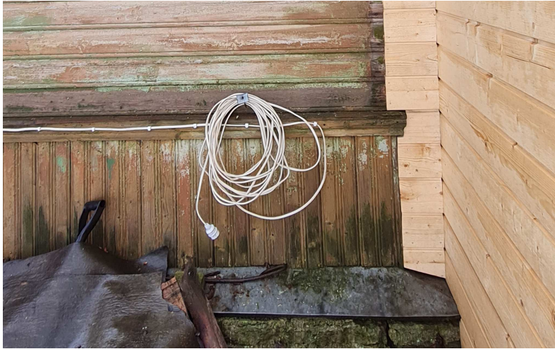
16. Paikvaatlus 2023 - hoone juurdeehituse ühenduskoht põhjaküljel
