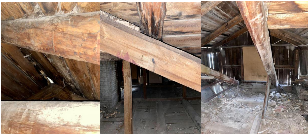
Illustratsioonid 19, 20 ja 21 Rohu 18 katusekonstruktsioon ja vahelagi 2023
