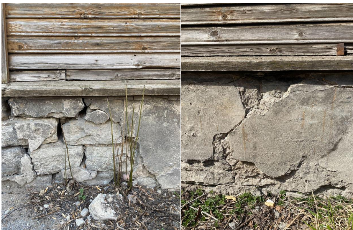
Illustratsioonid 7 ja 8 Rohu 18 soklil säilinud krohviosa 2023
