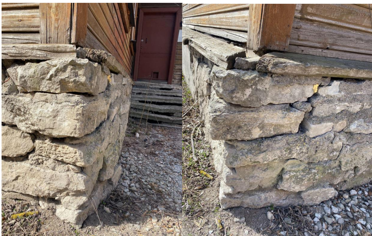
Illustratsioonid 5 ja 6 Rohu 18 sokli seisukord hetkel 2023
