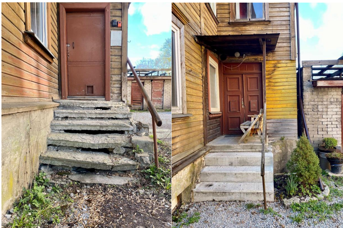
Illustratsiooni 9 ja 10 Rohu 18 välistreppide ja välisuste (Lisa 2 joonis 1 ja 3 VU-2 ja VU-3) seisukord 2023
