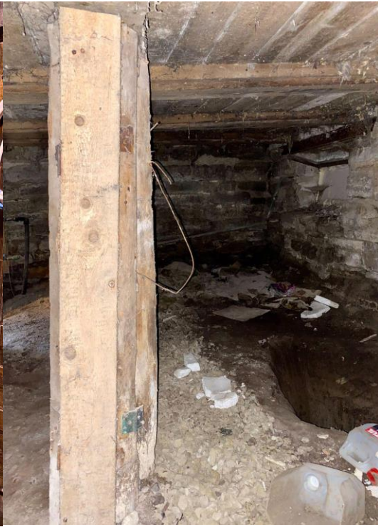
Illustratsioon 18 Rohu 18 kelder
