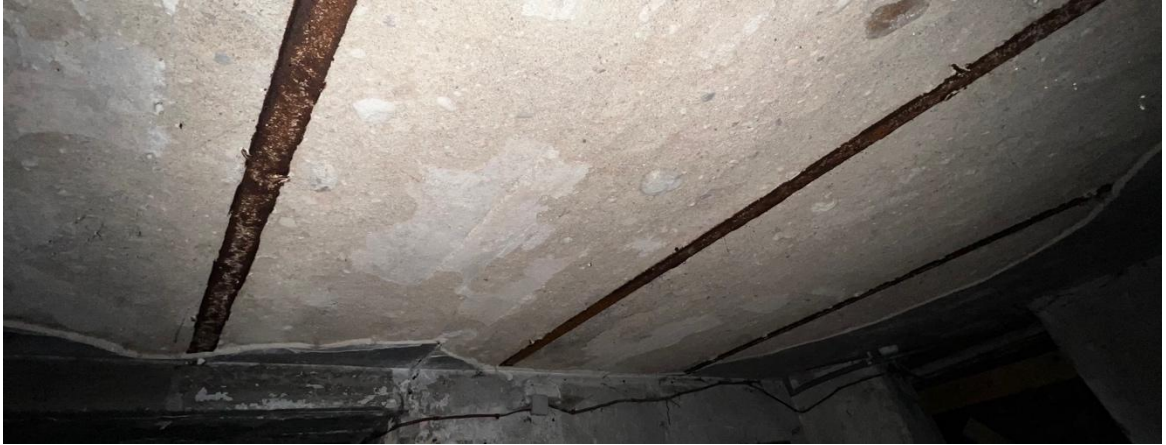
Näide keldri laes olevatest kohati roostetanud taladest 53
