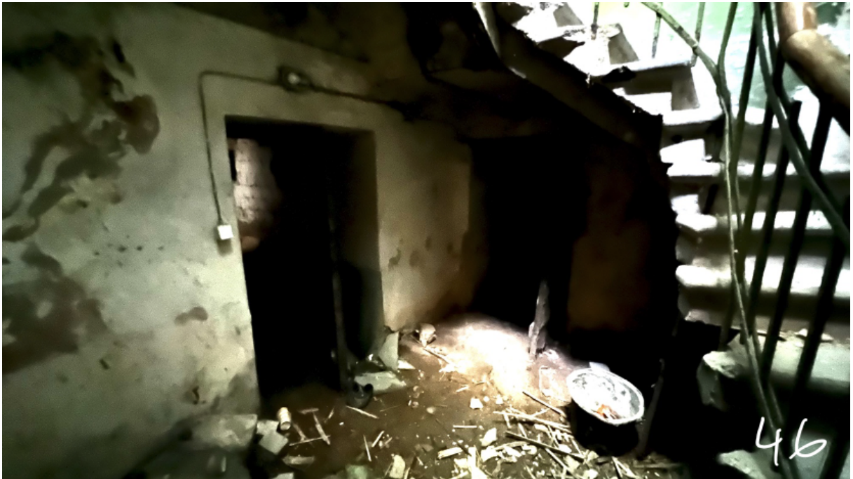
Trepi mademete otsapadjad on osaliselt murdunud 72 .
