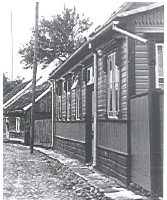
Foto 42 - Suur-Põllu 18 (1931, MKA) (valdav osa hoone fassaadidekoorist hävinud)
